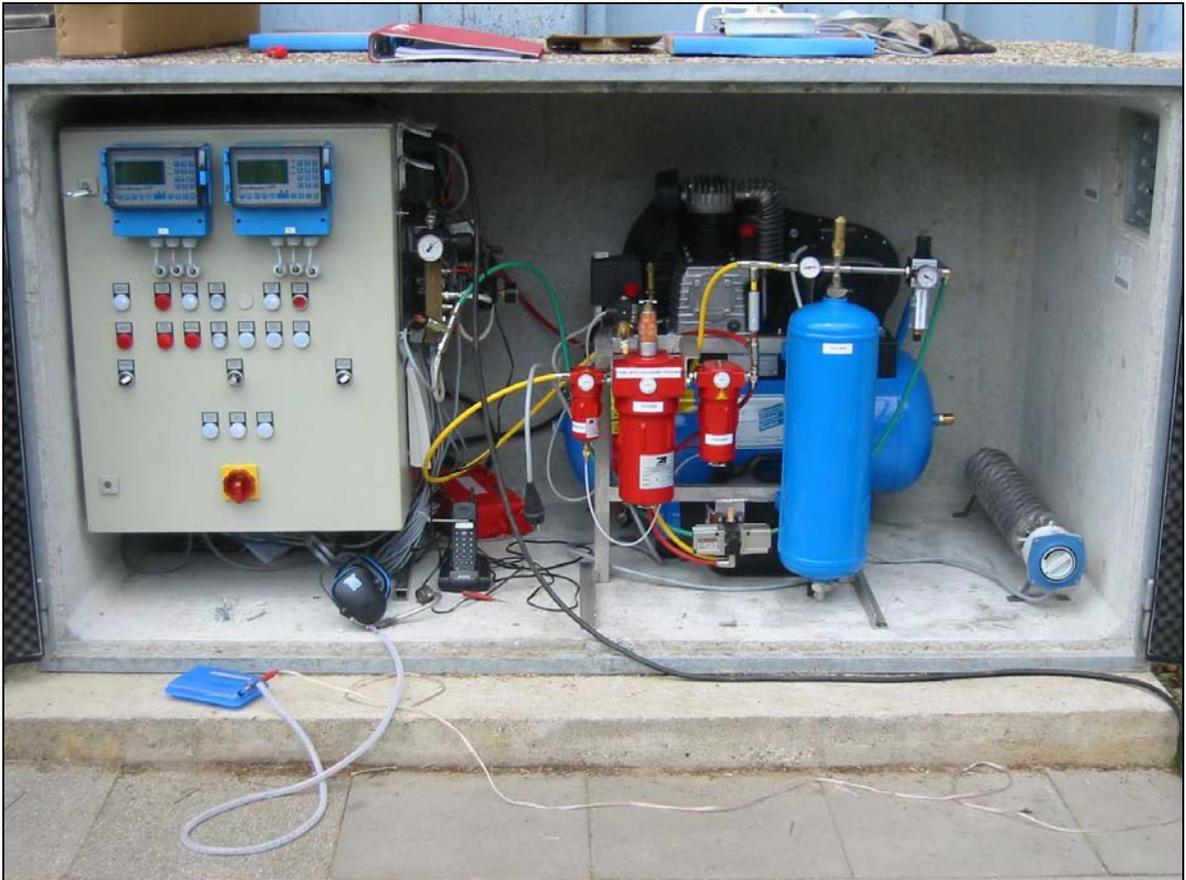
**Bild A 1:** Schaltschrank des neu entwickelten Reinigungssystems mit Kompressor sowie weiteren Einrichtungen für die Steuerung und Datenübertragung
