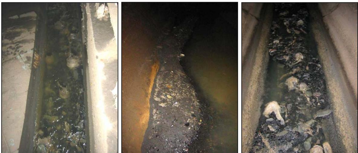
**Bild 4.1: Fotos der im Stauraumkanal vorgefundenen Ablagerungen (linkes und mittleres Foto: unterer Abschnitt; rechtes Foto: oberer Abschnitt)**
