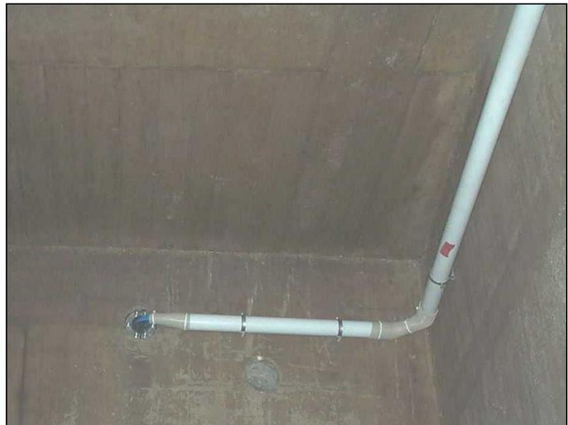
**Bild A 2:** Montierte Füllstandssonde der Endress+Hauser Messtechnik GmbH+Co. (links) und Führung der Strom- und Datenleitungen über eine exgeschützte Quetschdichtung in Schacht 1 (rechts)
