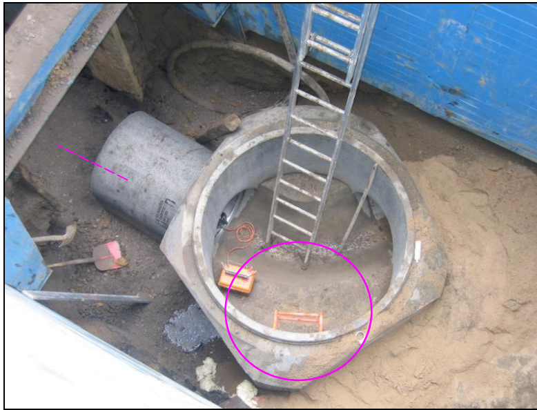
Bild 131 Kanallaser im Schacht zum Nivellement des Auflagers und der Rohre (Laserstrahl angedeutet) [Bildmaterial: S & P Consult GmbH]
