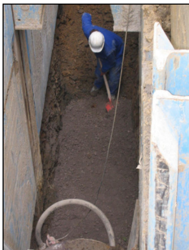
Bild 128 Verteilen des Schottermaterials zur Herstellung der unteren Bettungsschicht [Rohraufleger] (Bildmaterial: S & P Consult GmbH)
