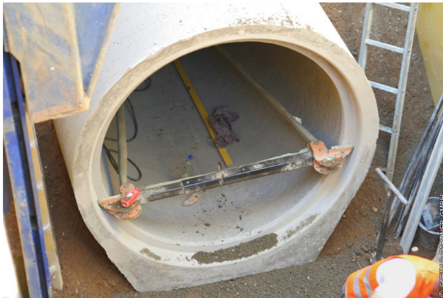
Bild 137 Rohrzuggerät zum Zusammenfügen von Rohren größerer Nennweite (WIMAG GmbH) [210] (links: im Rohr verspanntes Zuggerät, rechts: Traverse mit Zugband)
