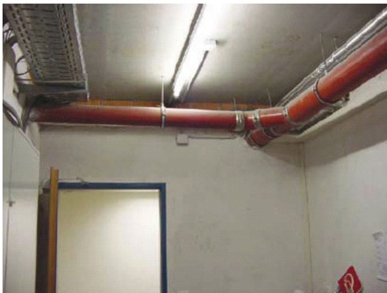
Bild 44 Erneuerung von Hausanschlussleitungen durch Umbau des Entwässerungssystems im Gebäude (Bildmaterial: S & P Consult GmbH)
