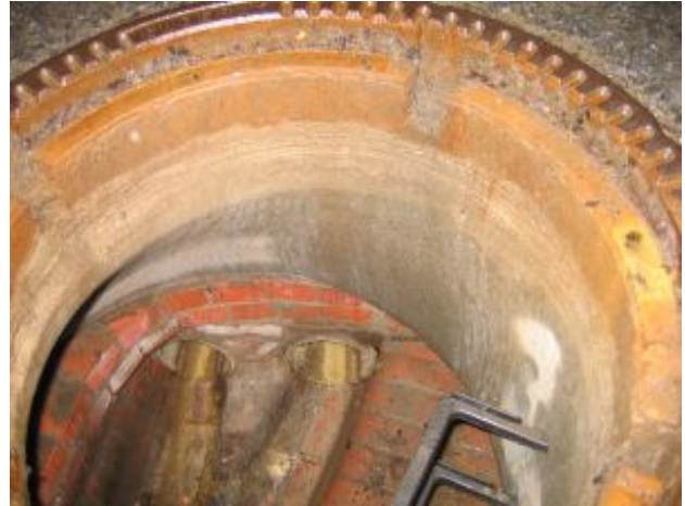
Gemessener Fremdwasseranfall an Messstelle 2 (M 2) mit Q = 3,01 \text{ l/s}
