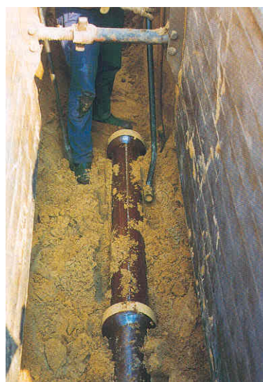
Bild 36 Seitliches Anstampfen des Rohrzwickels von Hand [102]
