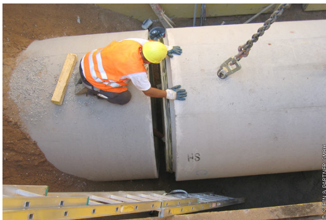
Bild 134 Frei hängendes Zusammenfügen der Rohre im Graben (Bildmaterial: S & P Consult GmbH)
