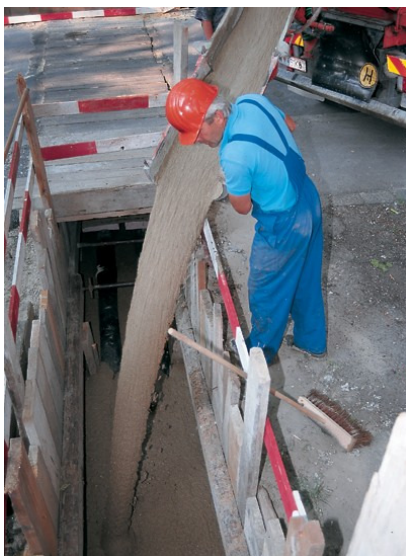
a) Fahrmischer mit Betonrutsche („Schurre“)
