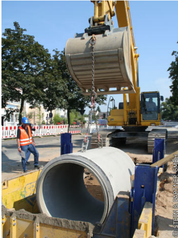
Bild 132 Einbringen der Rohre in den Graben (Bildmaterial: S & P Consult GmbH)
