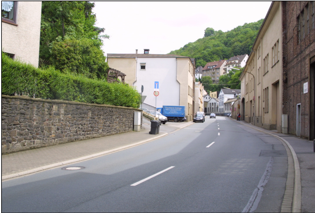
Bild 86 Örtliche Verhältnisse „Nettestraße“ / Giershager Weg, Blickrichtung NE´ (Bildmaterial: S & P Consult GmbH)
