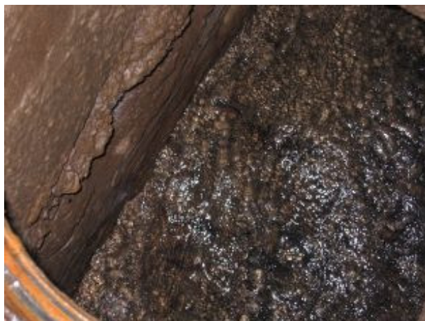
Gemessener Fremdwasseranfall an Messstelle 13 (M 13) mit Q = 81,88 l/s
