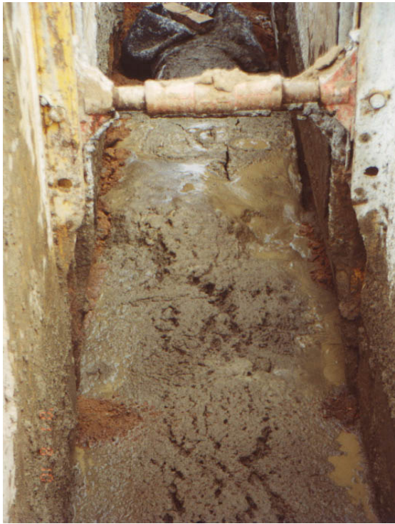
Bild 84 Einbau von RSS ® - Flüssigboden
