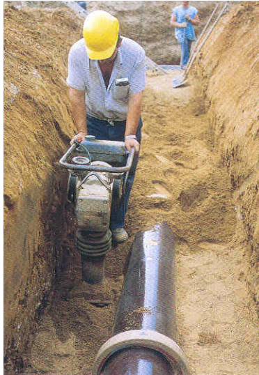
Bild 37 Lagenweise Verdichtung der Seitenverfüllung mit Vibrationsstampfer [102]
