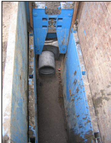
Bild 129 Verdichten des Rohraufagers (Bildmaterial: S & P Consult GmbH)
