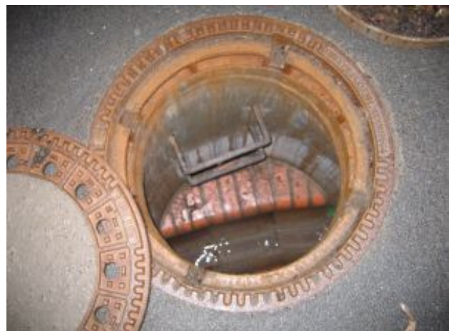
Gemessener Fremdwasseranfall an Messstelle 1 (M 1) mit Q = 0,68 l/s
