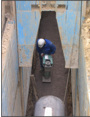
Bild 129 Verdichten des Rohraufagers (Bildmaterial: S & P Consult GmbH)
