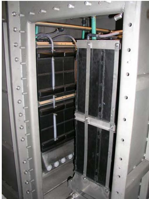
**Abbildung 7: Installation der siClaro<sup>®</sup> - Membranfilter in die Filterkammer**
