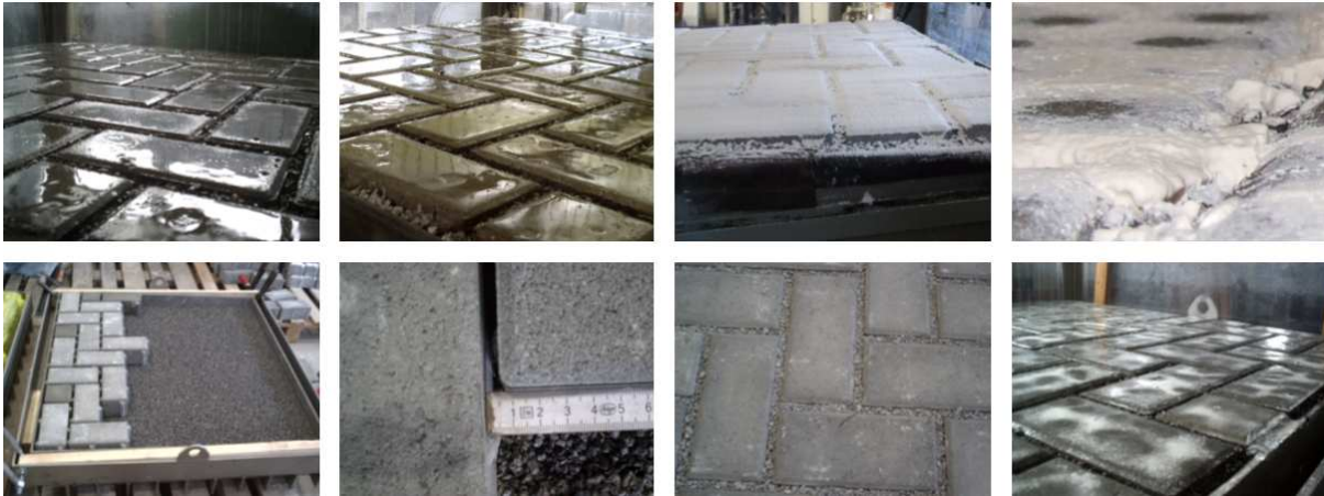
Abbildung 54: Flächenbeläge aus Betonsteinen mit splittverfüllten Sickerfugen
