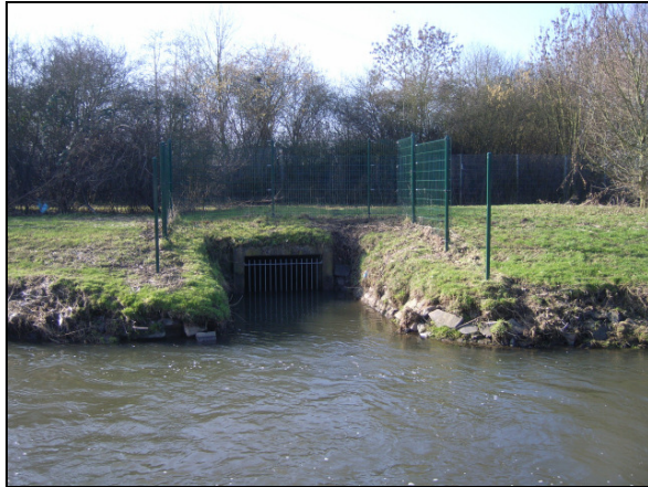
Blick auf die Einleitung. (Datum: 16.02.2011)
