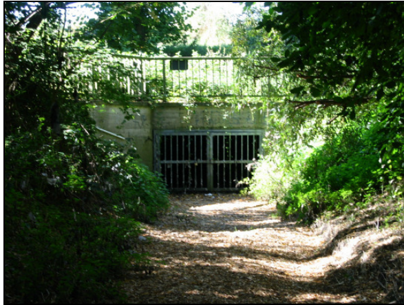
Blick auf die Einleitestelle (Datum 09.09.2008)
