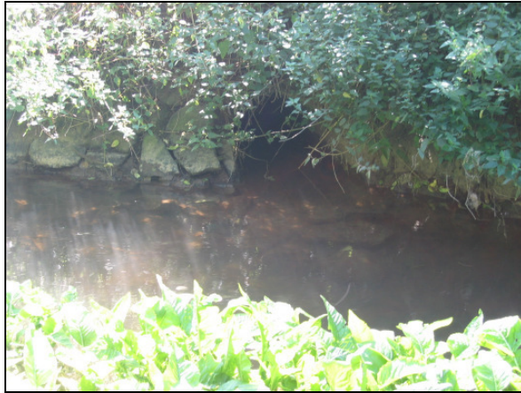
Blick auf die Einleitung. (Datum: 09.09.2008)
