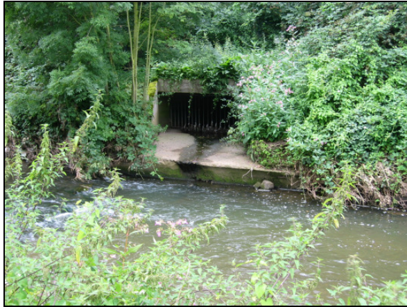
Blick auf die Einleitung. (Datum: 13.08.2008)
