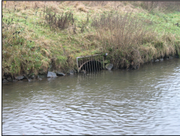
Blick auf die Einleitung (Datum: 17.12.2008)
