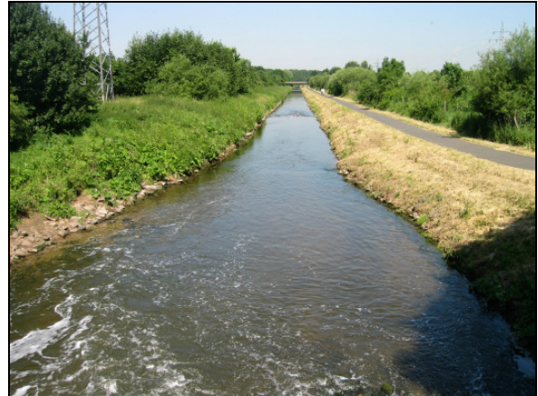
Blick oberhalb der Einleitung, in Fließrichtung. (Datum: 24.06.2008)
