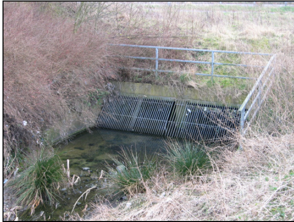
Blick auf die Einleitestelle (Datum 27.02.2008)
