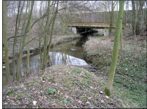
Einmündungsbereich, Vorflutgraben BAB61 von rechts in den Neffelbach. (Datum:27.02.2008)
