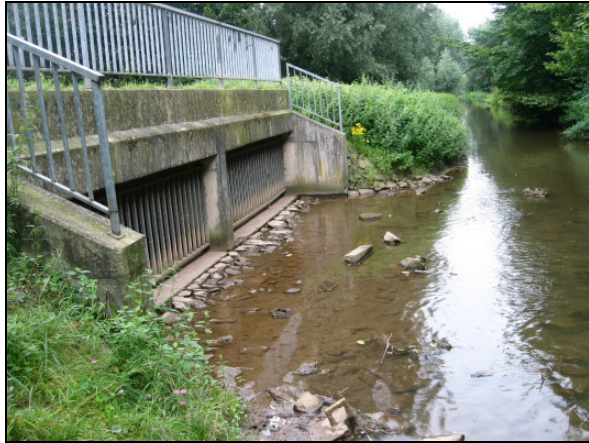
Blick auf die Einleitung. (Datum: 27.08.2008)
