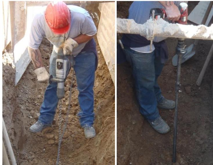
BILD 144: VORBOHREN MIT BOHRMEißEL (LINKS) UND EINDREHEN DER ANKER (RECHTS)
