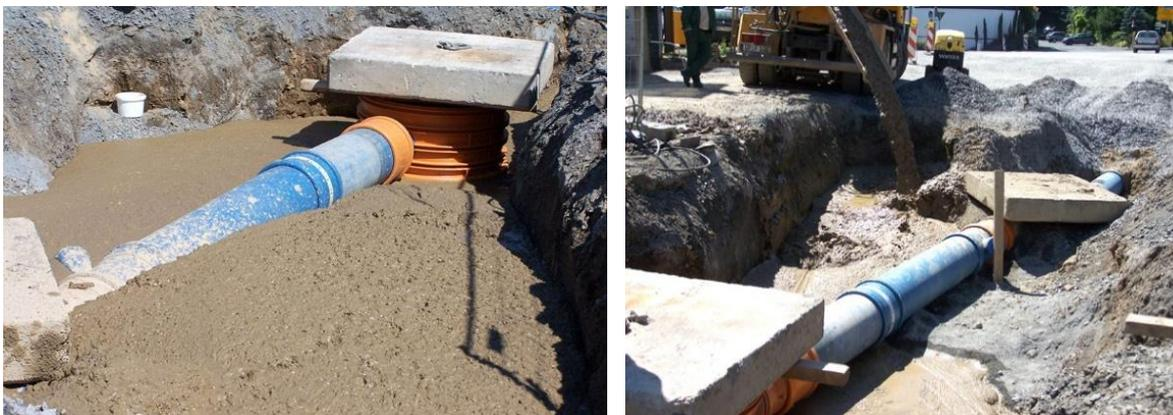
BILD 134: BALLASTIERUNG EINES ROHRES (REHAU, 2009)
