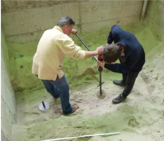
BILD 104: EINBRINGEN DER VERANKERUNG FÜR DIE ROHRAUFLAGER
