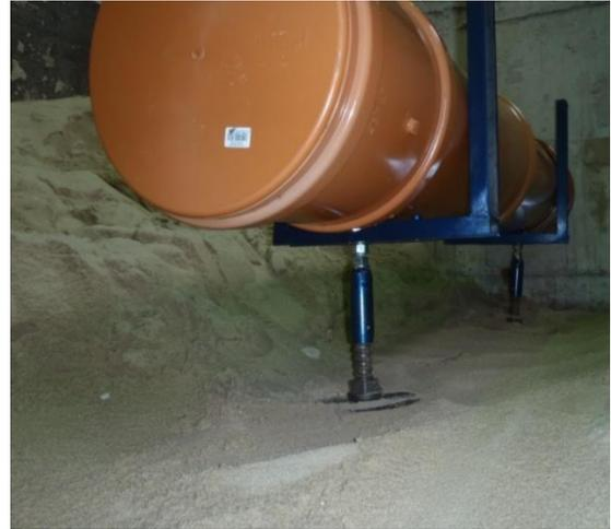
BILD 105: ROHRAUFLAGER ZUR AUFTRIEBS- UND LAGESICHERUNG
