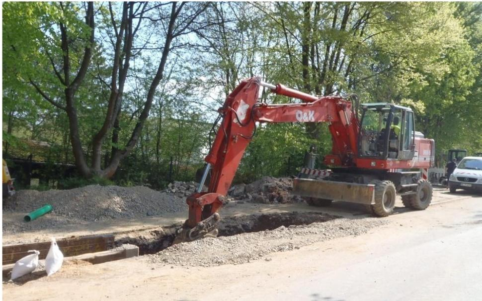
BILD 119: GRABENAUSHUB VOR KOPF BEI VORÜBERGEHEND STANDFESTEN BODENVERHÄLTNISSEN
