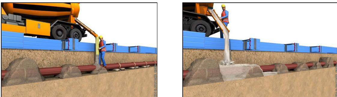
BILD 135: ARBEITSABLAUF BEI DER HERSTELLUNG VON LEITUNGSBÄNKEN (S&P GMBH)
