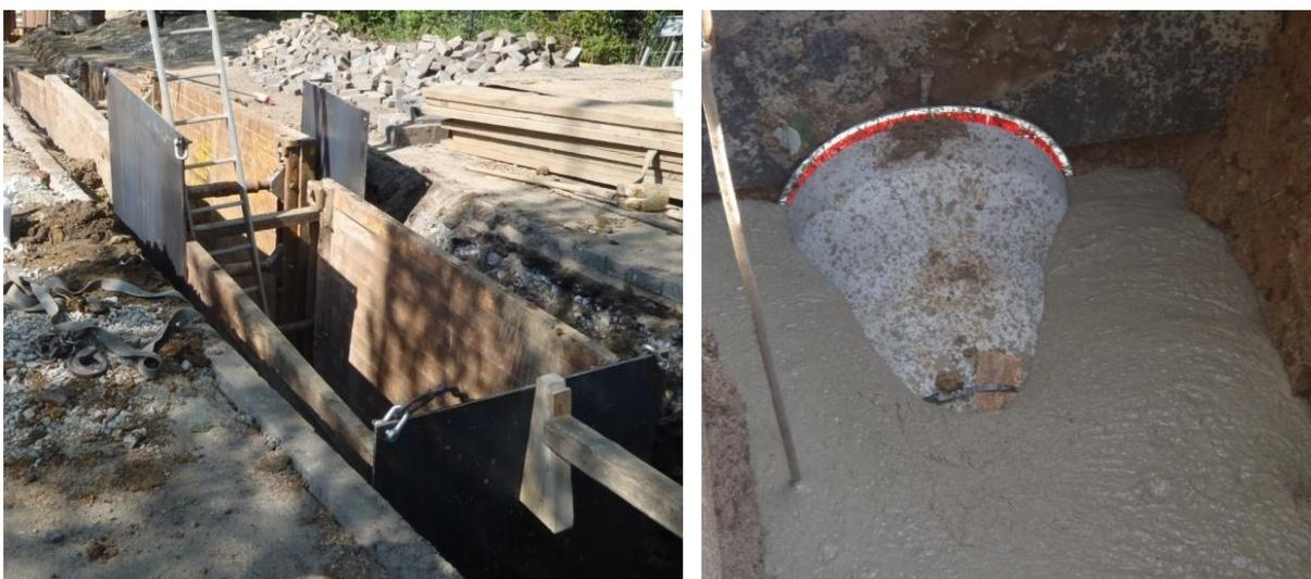
BILD 121: GRABENVERBAU MIT STAHLPLATTEN ALS LÄNGENAUSGLEICH UND QUERSCHOTT VOR KOPF (LINKS) UND ROHRLEITUNG MIT VERSCHLUSS UND QUERSCHOTT (RECHTS)
