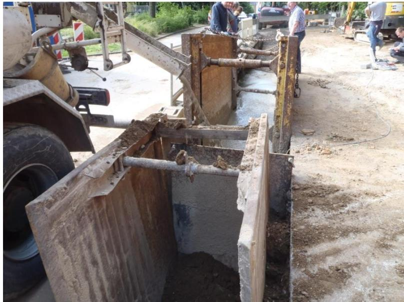
BILD 120: AUFFÜLLEN DES SUSPENSIONSVERLUSTES BEIM ZIEHEN DER VERBAUGERÄTE
