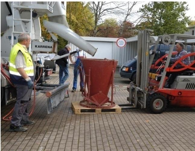
BILD 109: BEFÜLLEN DER BETONBOMBE AUS DEM FAHRMISCHER
