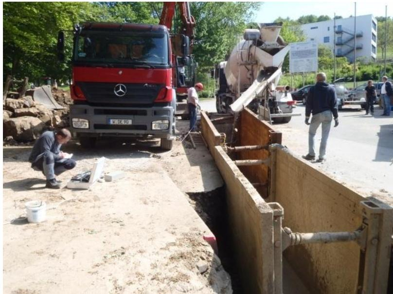
BILD 129: BAUSTELLENVERSUCH ZUR AUFTRIEBSWIRKUNG VON FLÜSSIGEM VERFÜLLMATERIAL
