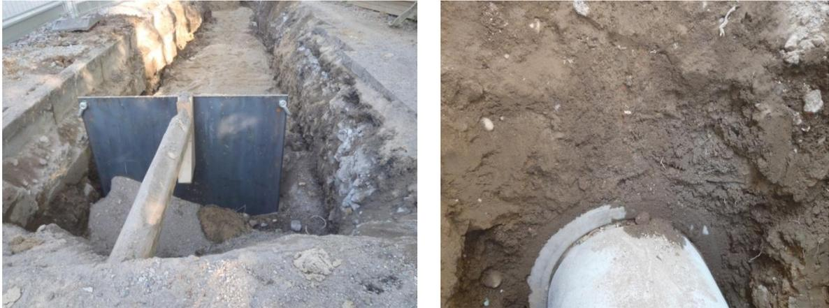
BILD 122: QUERSCHOTT MIT SAND-/KIESHINTERFÜLLUNG (LINKS), ANSCHLUSS AN FOLGEROHR (RECHTS)
