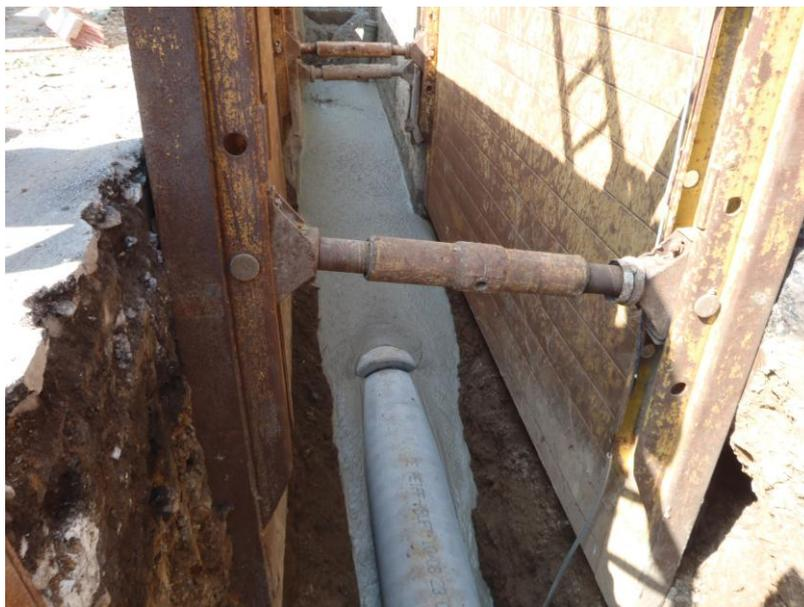
BILD 132: UMSTRÖMUNGSVORGANG DES ROHRES AUF DER BAUSTELLE
