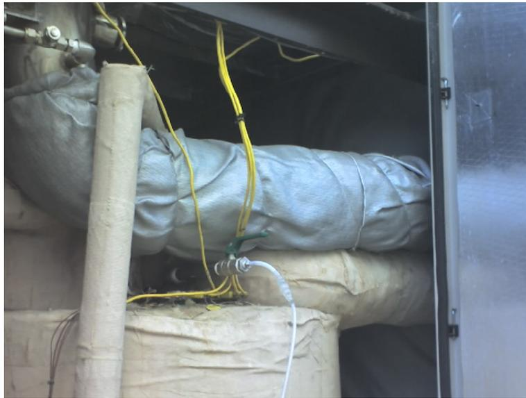
*Gasproben-Entnahme am Anodeneingang*
