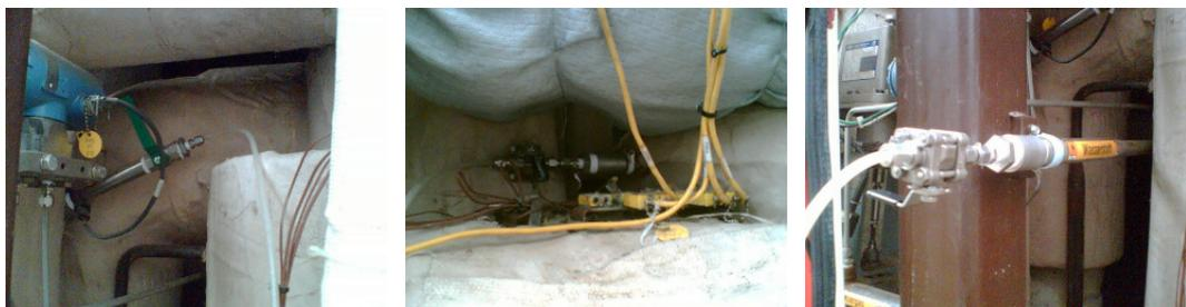
*Prozessgasmessstellen am Reformer und Shift Converter*
