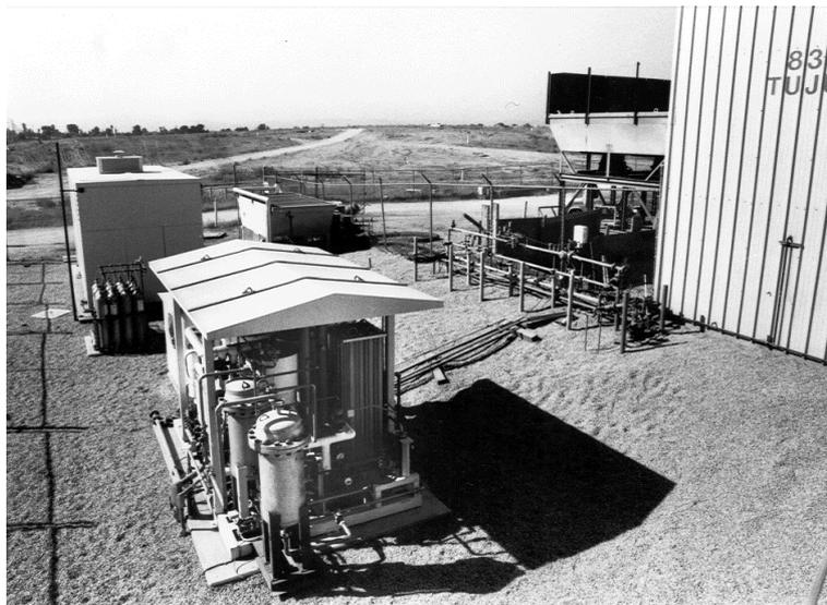
*Erste Testanlage einer Brennstoffzelle mit Deponiegas in Penrose, CA (1995)*
