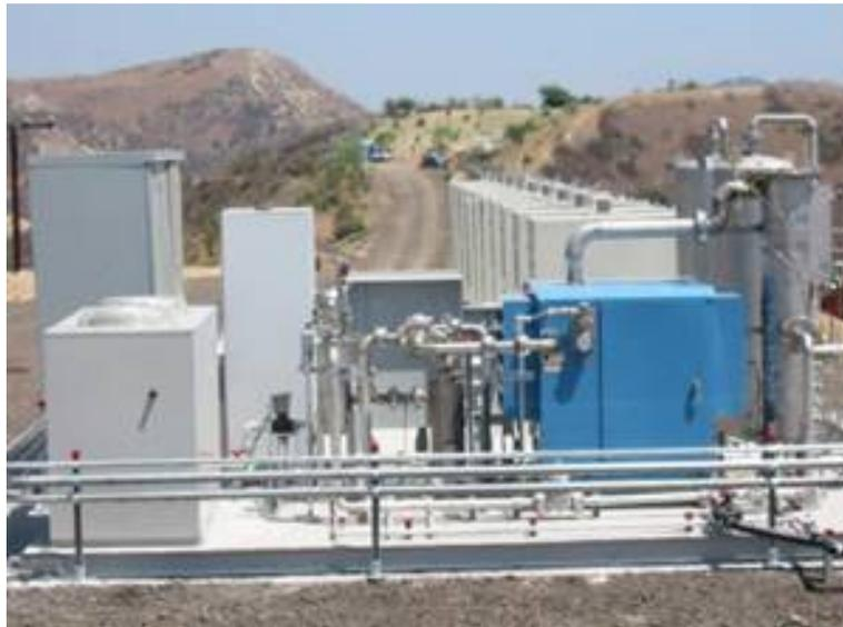
*Zehn 30 kW Mikrogasturbinen von Capstone im Deponiegasbetrieb
