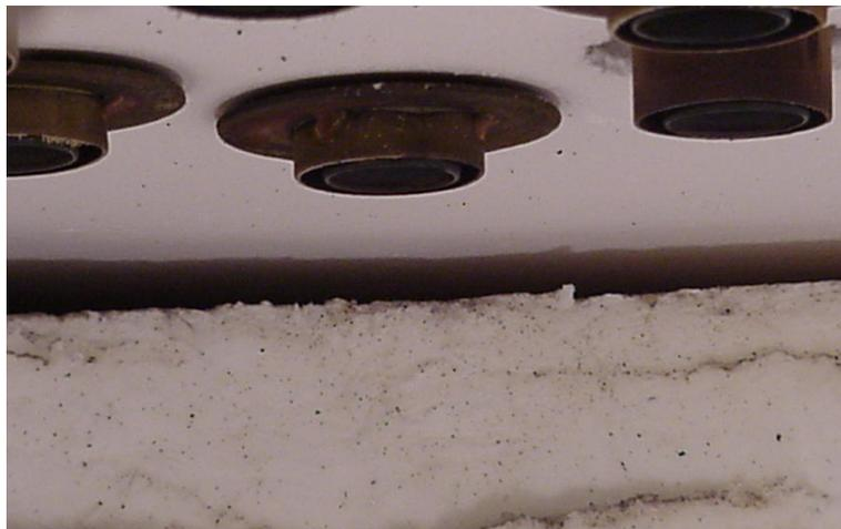
*Umlaufender Spalt zwischen Wand- und Deckenisolierung*
