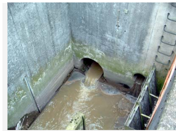
Bild 5: Kläranlagenzulauf
