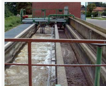
Bild 7: Belüfter Sandfang
