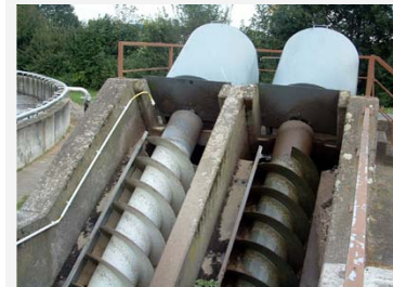
Bild 6: Abwasserhebewerk
