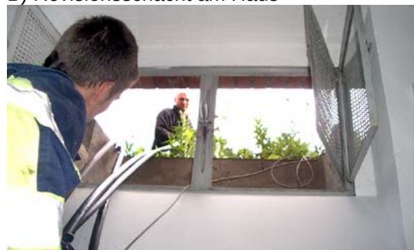
C) Zugang zum Revisionsschacht im Keller
