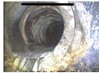
C) starker Fremdwasserzufluss
