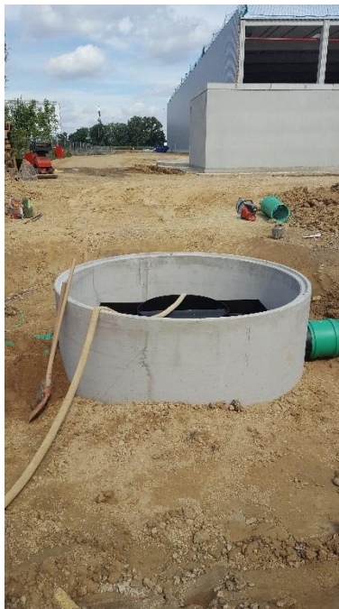
Abbildung 5: Einbau der ViaDrop 30/150 in Bönen (Quelle: Mall GmbH)
