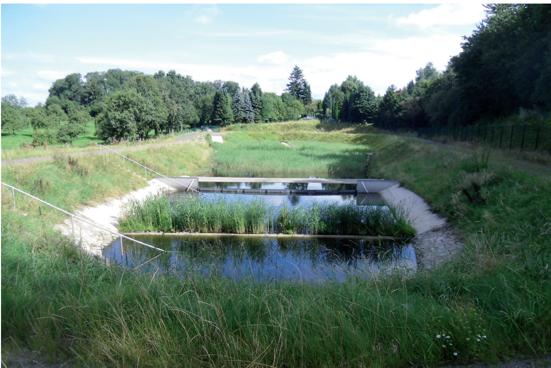
Retentionsbodenfilter zur Niederschlagsentwässerung von Verkehrsflächen
