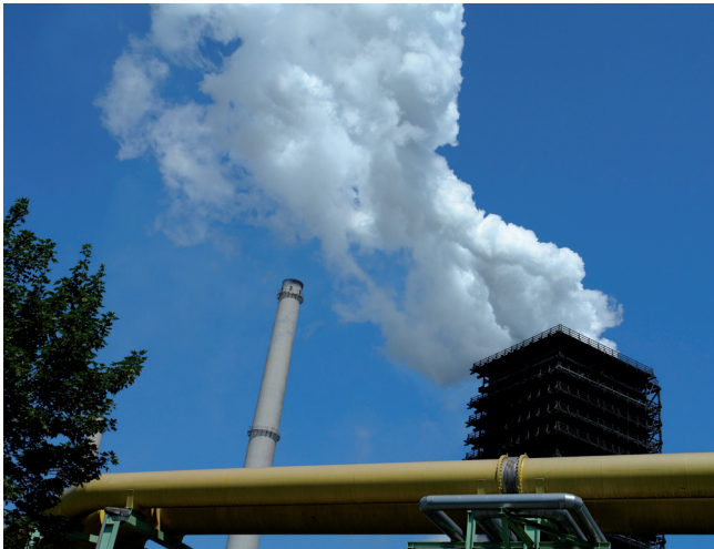
Hochofen ThyssenKrupp Duisburg
