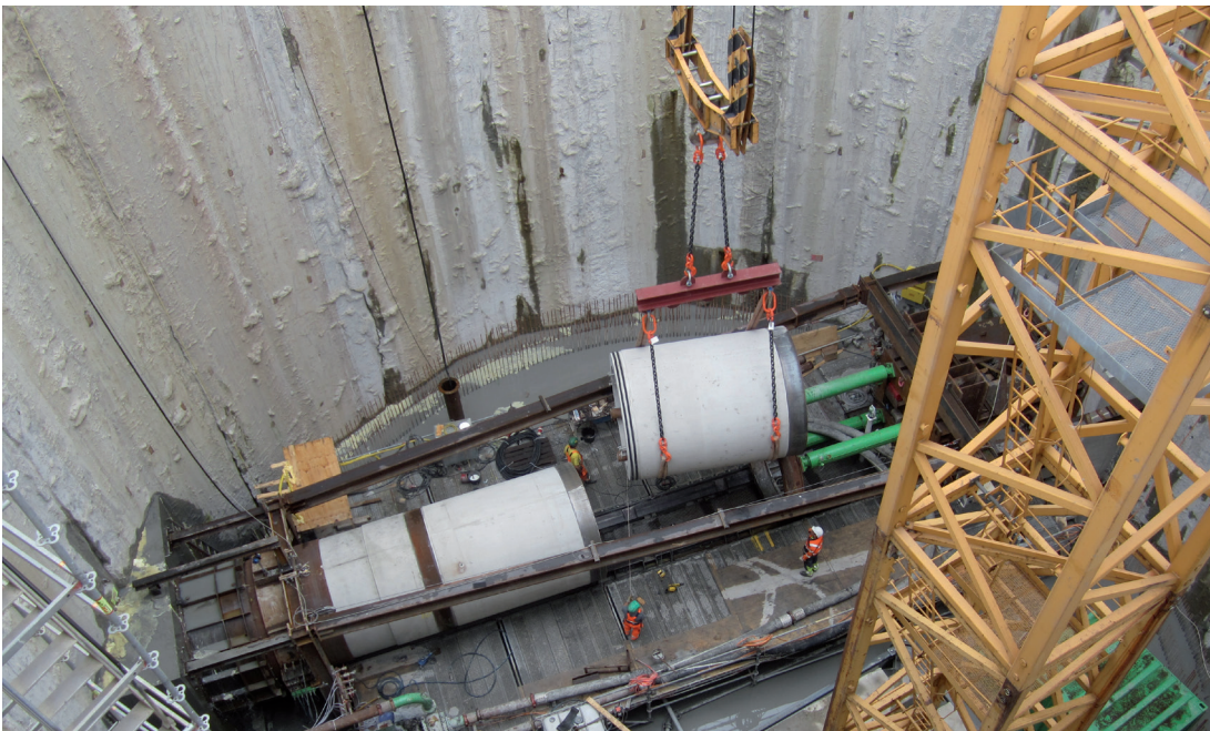
Kanal-Baustelle Abwasserkanal Emscher
