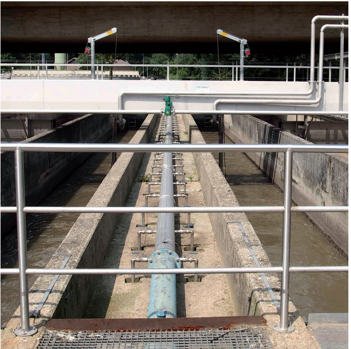
Sand- und Fettfang der Kläranlage Aachen-Soers
