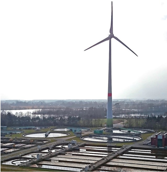
Windrad auf der Kläranlage Paderborn
