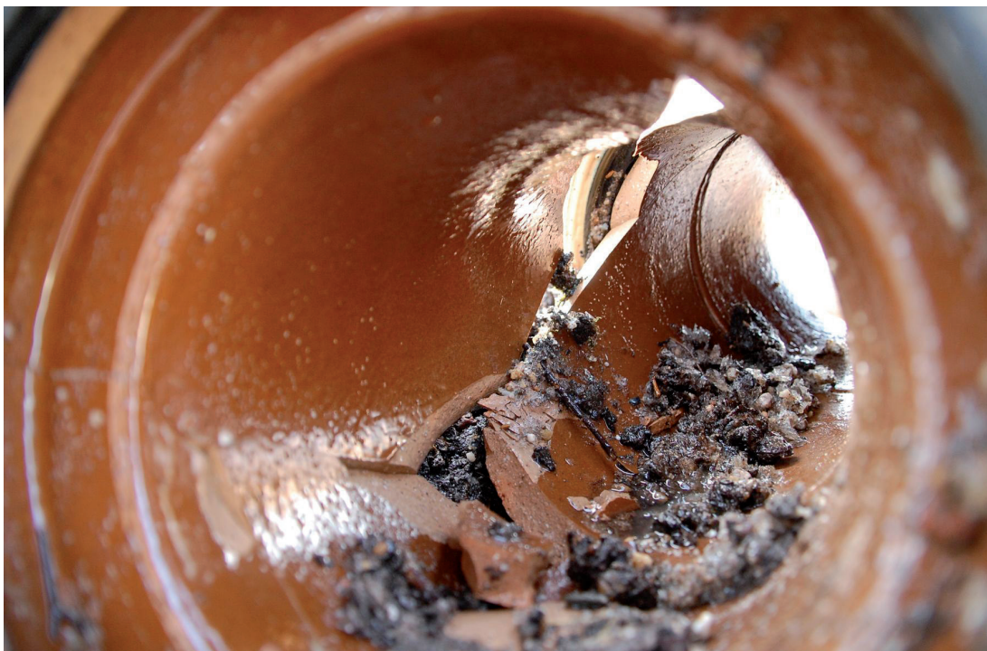
Abwasserrohre müssen funktionstüchtig sein
