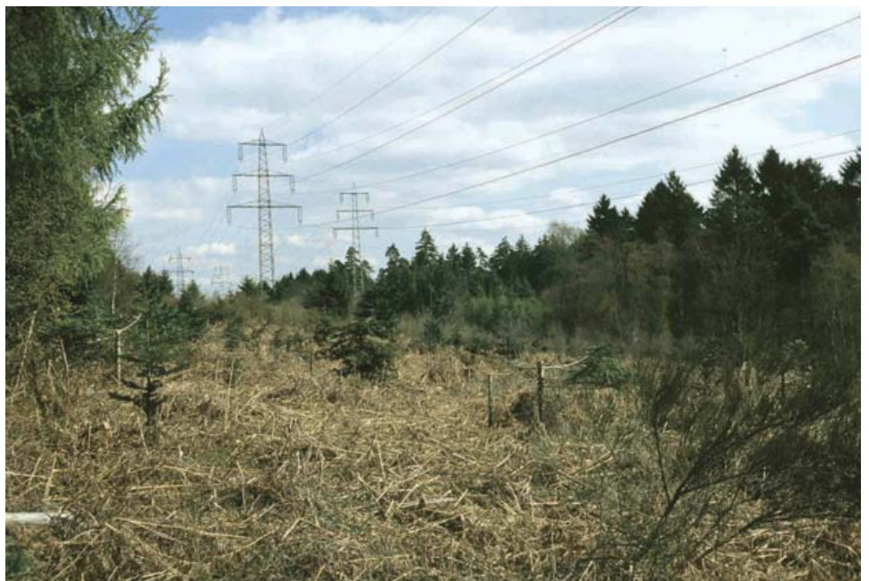
Zentraler Bereich der Freileitungstrasse im Marscheider Wald. Vor Durchführung der Pflegemaßnahmen. Foto: A. Geiger
