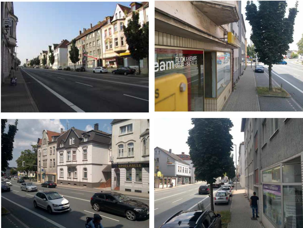
Abbildung 10: Bilddokumentation Bochum Herner Straße (Quelle: Stationsdokumentation LANUV NRW 2018, nachzusehen in [3])
