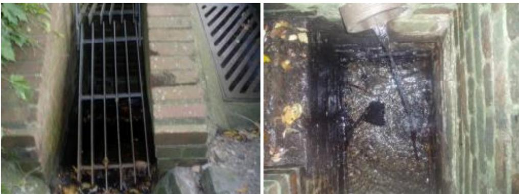
Bild 8 Einlaufbauwerk in den verrohrten Bachabschnitt (2031)
