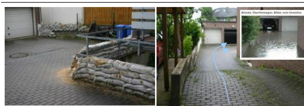
Bild 33 Garageneinfahrt und Kellerzugang ohne freien Abfluss für zufließendes Oberflächenwasser (Ortstermin April 2009)
