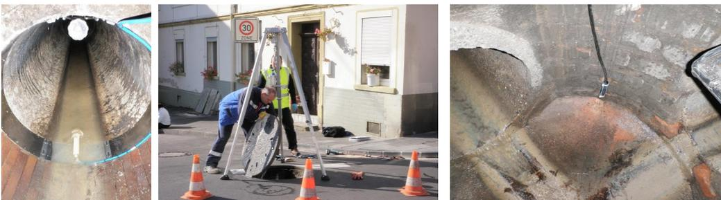
Bild 19 Einbau von Abfluss- und Wasserstandsmessungen zur Bauwerksüberwachung im Rahmen von Überflutungsuntersuchungen (Ursachenanalyse/Maßnahmenplanungen; Bilder: Dr. Pecher AG)
