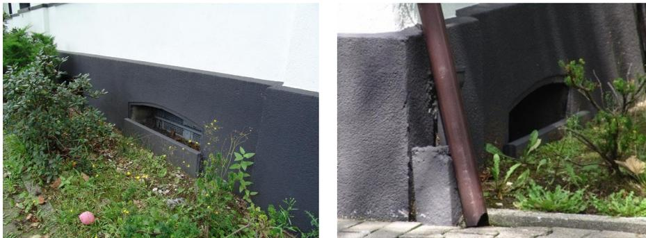
Bild 24 Provisorisch vor Überflutung „geschützte“ Kellerfenster (links) und kurzfristige „Abkopplung des Niederschlagswassers“ (rechts) im Untersuchungsgebiet (Bilder: Dr. Pecher AG)
