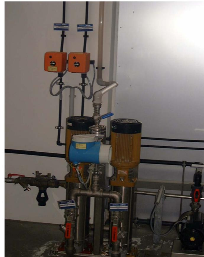
Die Dosierung der mit Weichwasser verdünnten Natronlauge zum Hauptstrom erfolgt vor einem statischen Mischer über 2 Dosierlanzen
