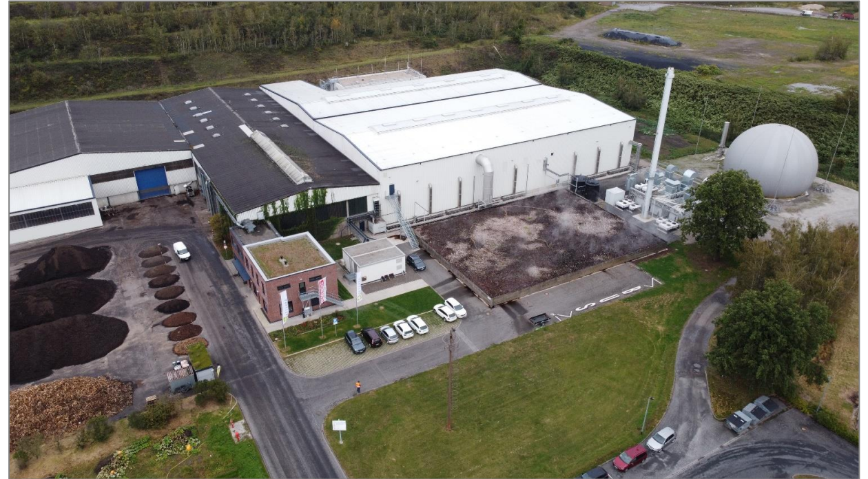
Vergärungs- und Kompostierungsanlage Lünen, Lippewerk (Foto RETERRA)
