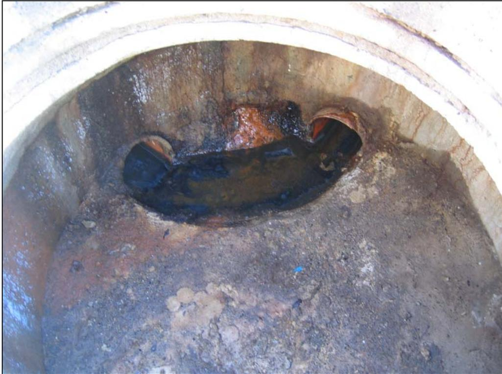
Abb. 4.3-5: Fehlende Höhendifferenz beim Einlauf für die Probenahme
