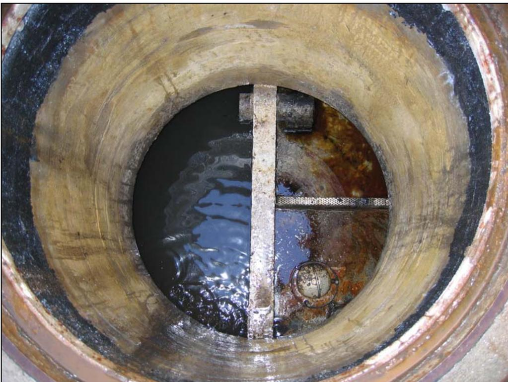
Abb. 4.3-3: Koaleszenzabscheider mit integriertem Schlammfang und versetzt eingebautem Koaleszenzmaterial
