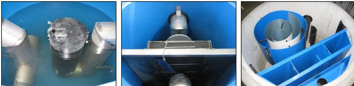
Abb. 3.3-1: Verwendete Abscheider (links Abscheider Klasse II, Mitte und rechts Koaleszenzabscheider Klasse I)
