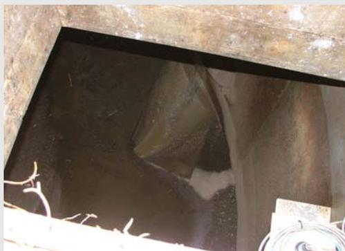
Ultraschallsonde im Zulaufbereich des RÜB zur Bestimmung der Beckenfüllstände
