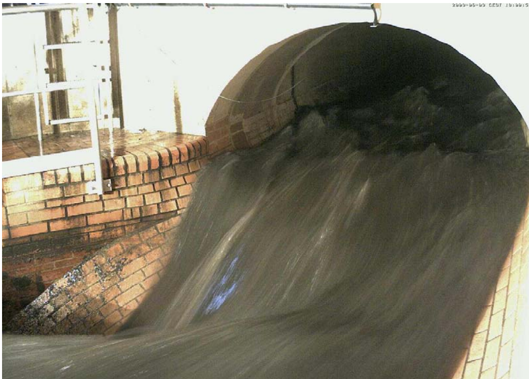
Bild 10 Ableitung des als klärfpflichtig definierten Abflusses im Zeitraum der Regenwasserableitung am Trennbauwerk VZW 53 im Briller Bach
