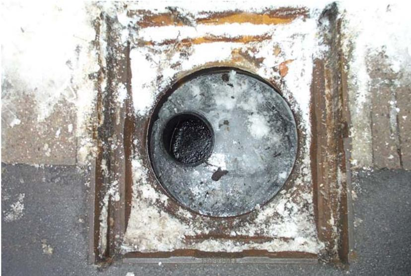
Abbildung 60: Zugefrorener Nassschlammfang und Eiskecke in der ersten unteren Kammer am 30.01.2006.
