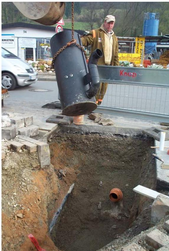
Abbildung 16: Einbau der Versuchsanlage in den Straßenkörper.
