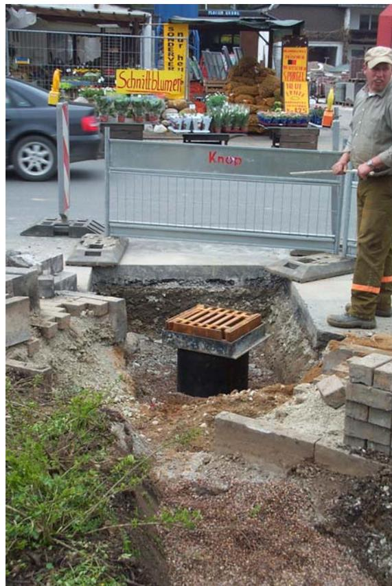
Abbildung 17: Centrifuge-System nach erfolgreichem Einbau mit komplettem Aufsatz, vor dem Verfüllen und Aufbringen einer Teerdecke
