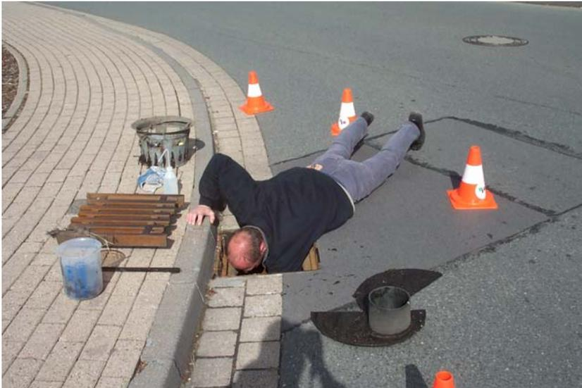
Abbildung 59: Ein- und Ausbau des Koaleszenzfilters
