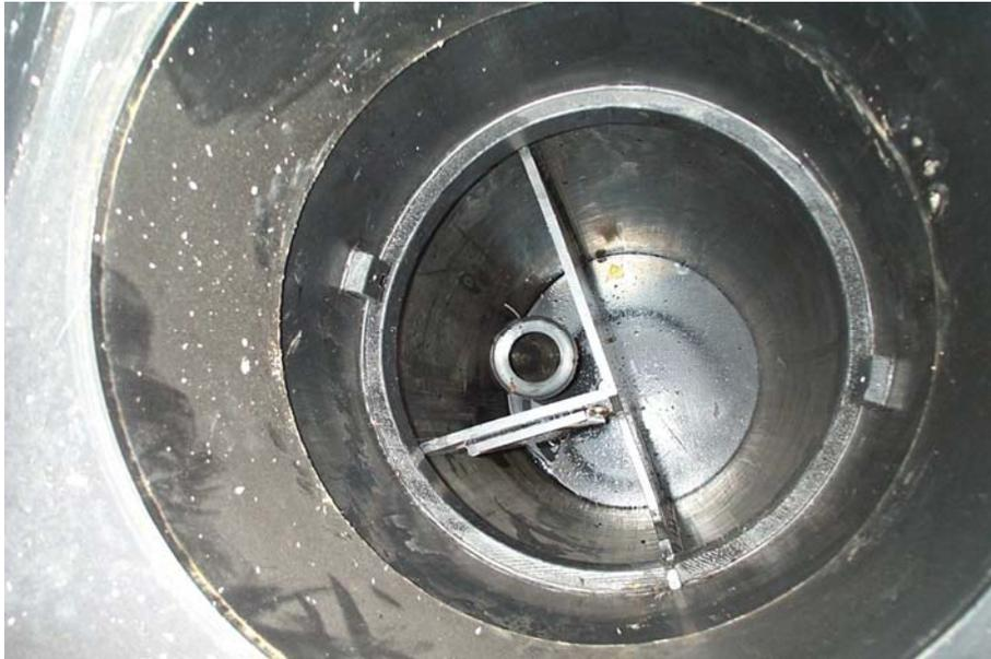
Abbildung 6: Blick in die unteren drei Kammern des Centrifugal-Systems, die Ventilkugel wurde entnommen
