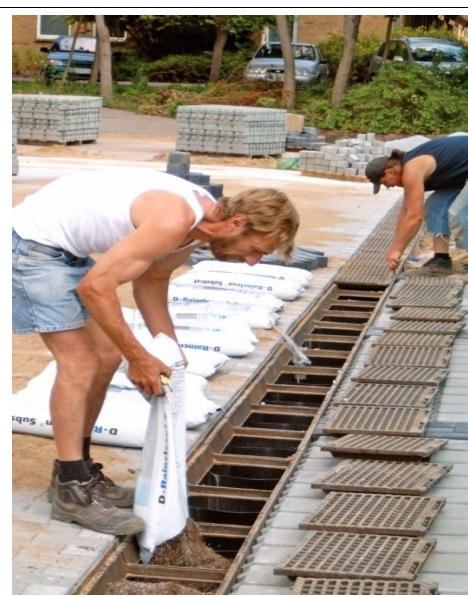
Abbildung 4-4: Herstellung einer D-Rainclean®-Sickermulde
