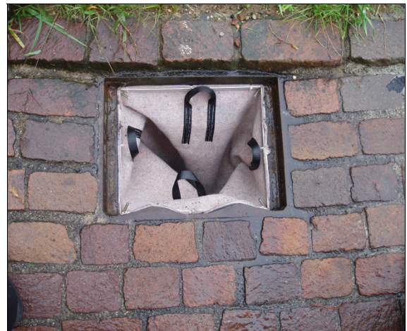
Abbildung 6-4: Geotextilfiltersack, eingehängt in Straßenablauf [Käser, 2008]
