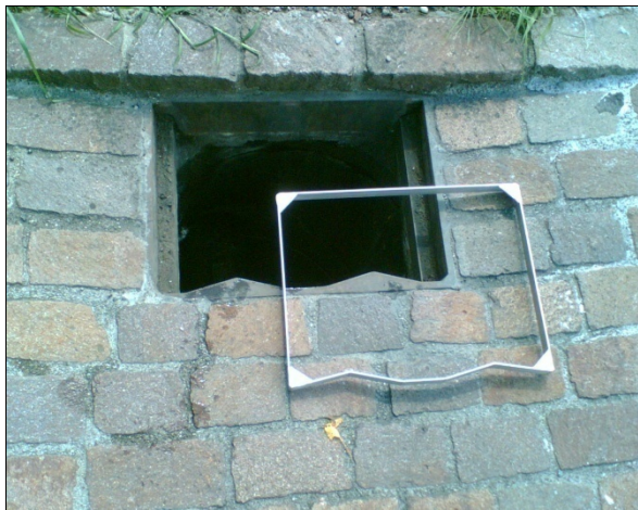
Abbildung 6-4: Geotextilfiltersack, eingehängt in Straßenablauf [Käser, 2008]
