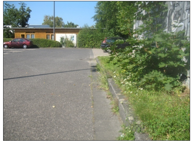
Abbildung 4-2: Rinne Parkplatz Hallenbad [Neuhaus, 2008]
