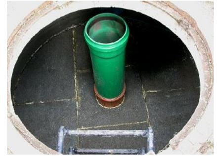
Abb. 63: Das im Filterschacht 3 installierte grüne Überlaufrohr
