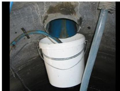
Abb. 53: Optimierte Zulaufprobe im Verteilerschacht
