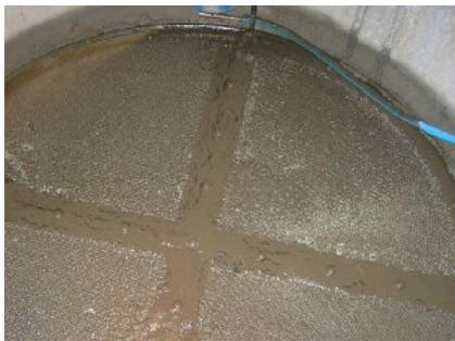
Abb. 58: Eine dünne, feine Schlammschicht oberhalb Filtersystem 1 und 2
