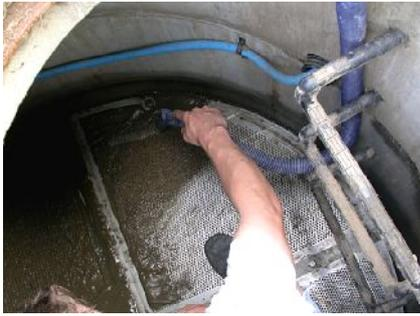
Abb. 61: Absaugen des Schlammes durch einen Trocken-Nass-Sauger
