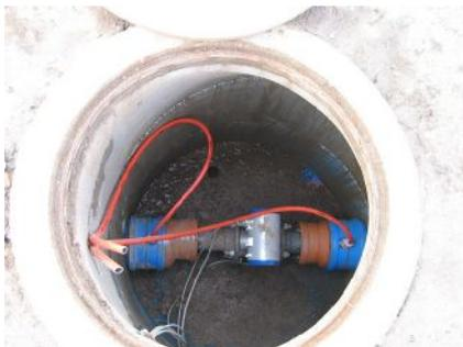
Abb. 52: Entlüftungsschläuche vor und nach den Messgeräten
