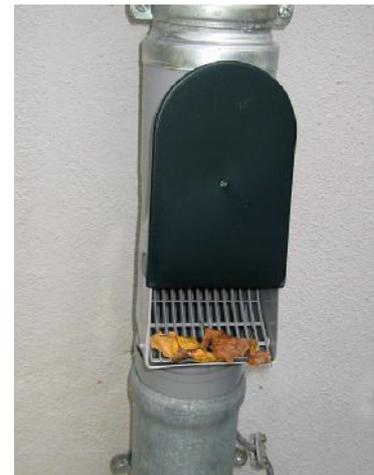
Abb. 66: In die Regenfallrohre installierte Laubabscheider
