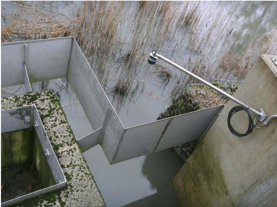
**Abbildung 8.2: Mögliche Störung der Höhenstandsmessung durch Schilf**
