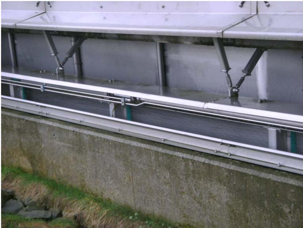
**Abbildung 8.4: Überfallschwelle mit Siebrechen**
