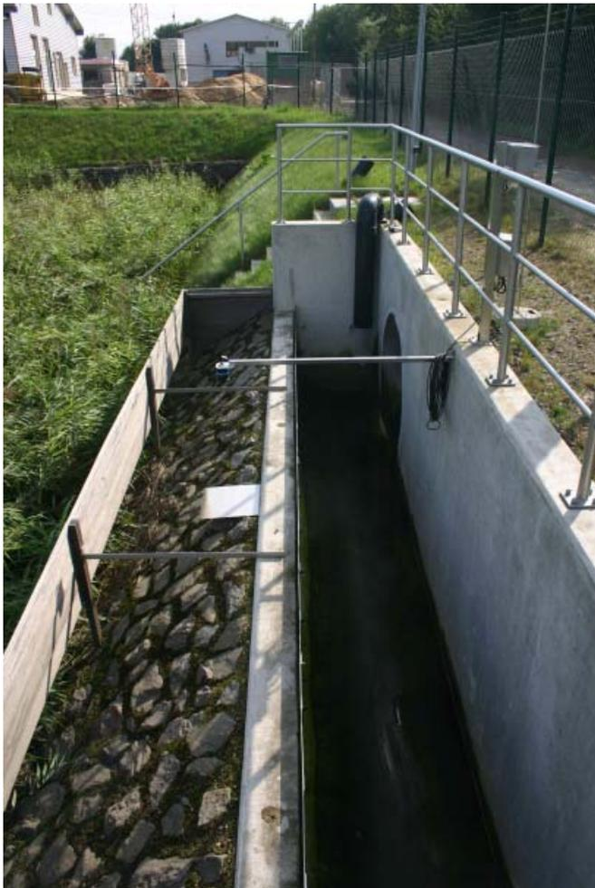
**Abbildung 8.1: Ungünstige Anordnung der Messsonde unmittelbar vor der Schwelle**
