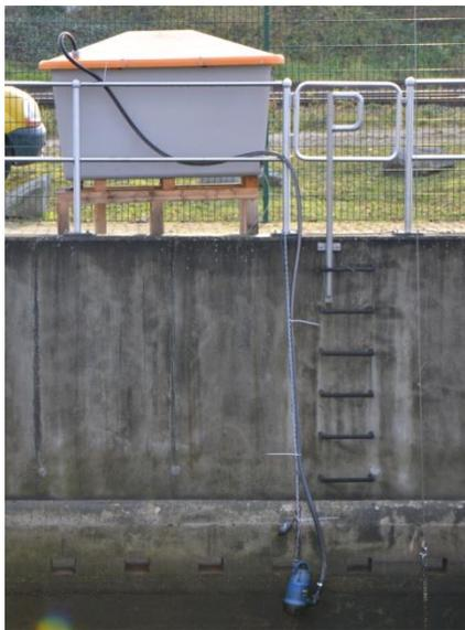
Abbildung 3.5: Schmutzwassertauchpumpe und Feststoffsammler im Zulauf
