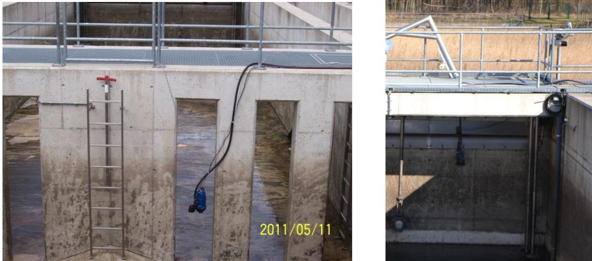
Abbildung 3.23: Zulaufpumpe und Klärüberlaufpumpe am RKB Lochfeld
