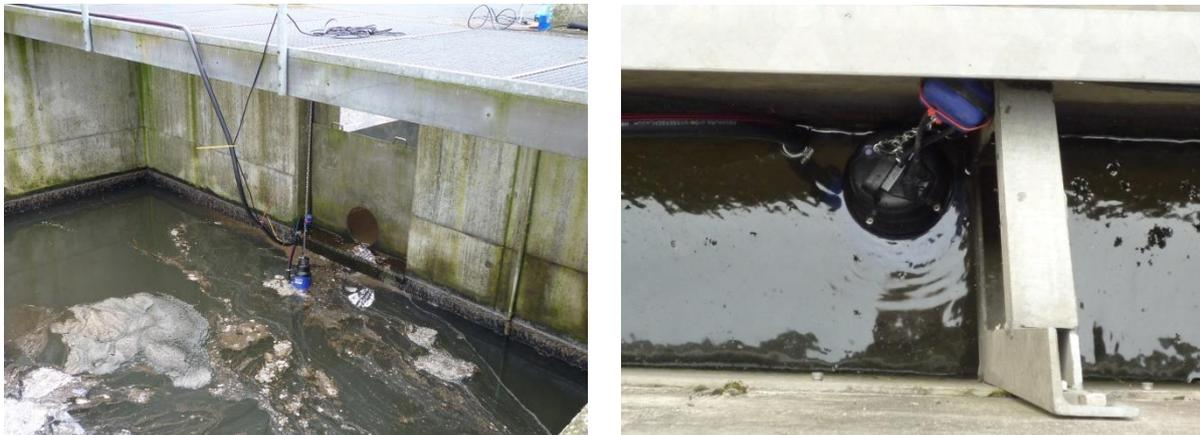
Abbildung 3.11: Zulaufpumpe und Pumpe vor dem Klärüberlauf in Ibbenbüren
