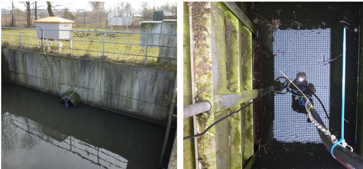
Abbildung 3.7: Zulaufpumpe (links) und Klärüberlaufpumpe (rechts) Daimlerstraße
