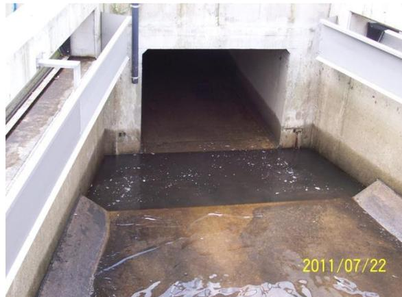
Abbildung 3.22: Zulaufbereich mit Geschiebeschacht, Lochfeld
