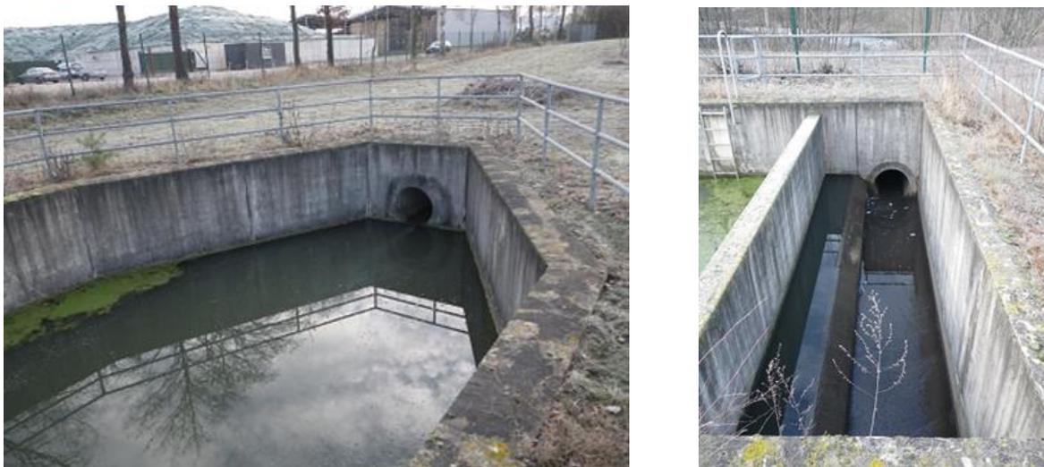
Abbildung 3.8: Zulauf (links) und Klärüberlauf (rechts) des RKB Haarstraße in Recke
