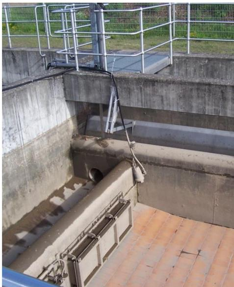
Abbildung 3.29: Zulaufpumpe Oberbruch mit Spülklappe
