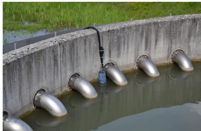
Abbildung 3.27: Zulaufpumpe (links) und Klärüberlaufpumpe (rechts) am RKB Bettringen
