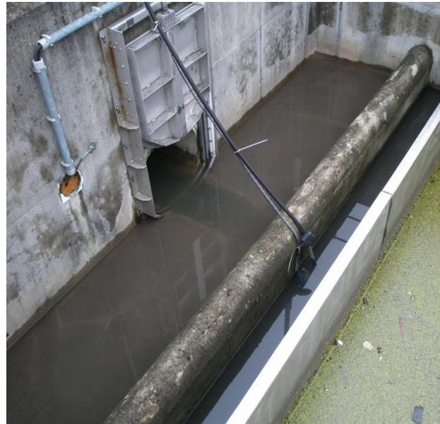
Abbildung 3.15: Zulaufpumpe und Pumpe vor dem Klärüberlauf am RKB Erlenstraße
