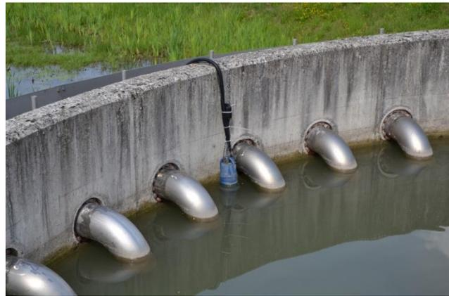
Abbildung 3.4: Schmutzwassertauchpumpe auf KÜ-Höhe
