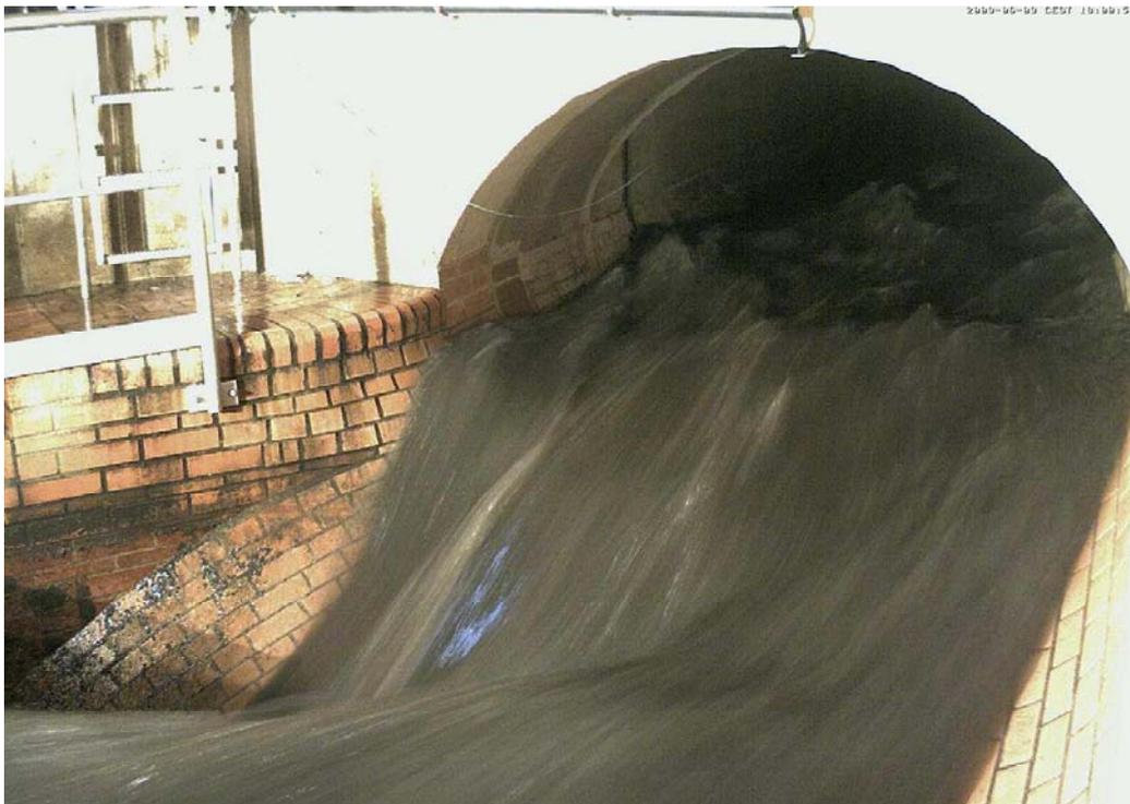
Bild 10 Ableitung des als klärflichtig definierten Abflusses im Zeitraum der Regenwasserableitung am Trennbauwerk VZW 53 im Briller Bach
