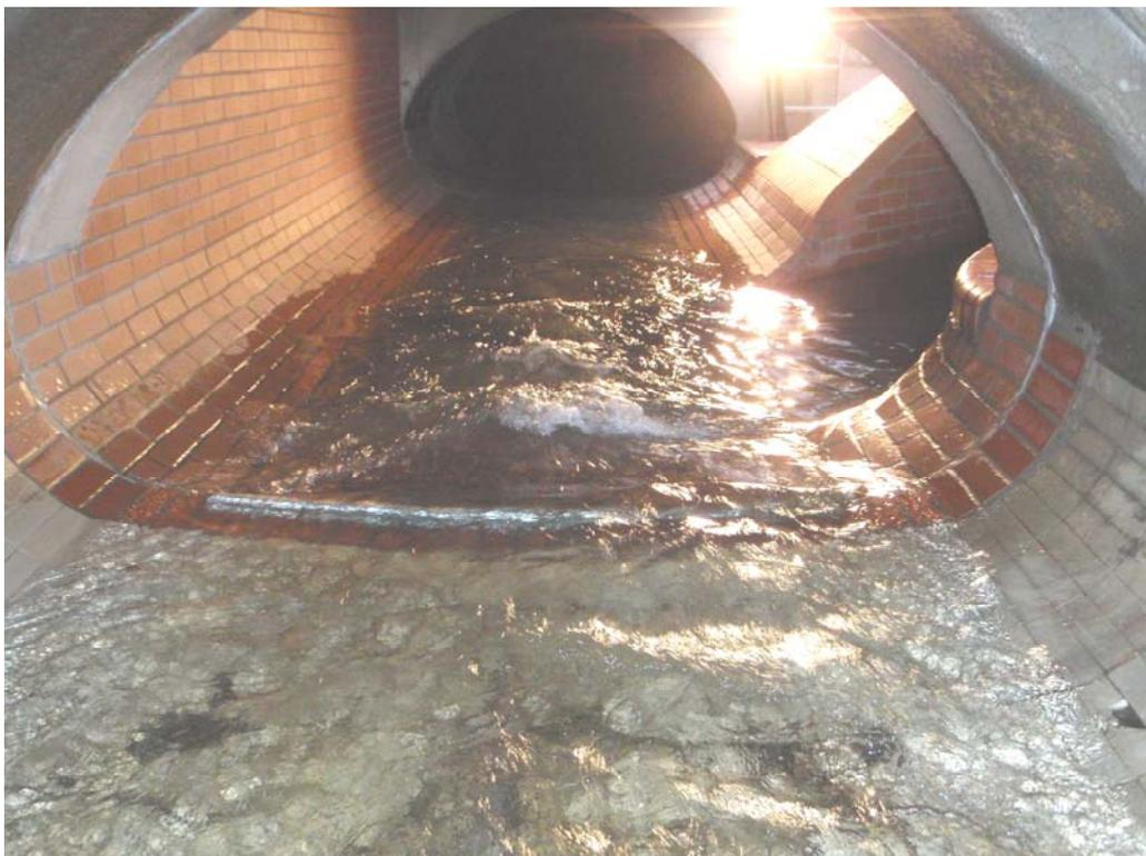
Bild 2 Blick in den kanalisiertem Briller Bach etwa 150 m vor der Einleitung in die Wupper in einem Zeitraum mit kontinuierlichem Basisabfluss ohne Oberflächenabflusseinleitung
