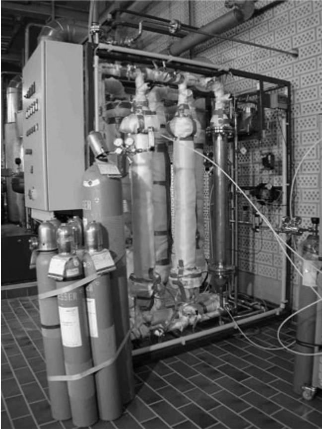
**Bild 5-11:        Installierte Gasreinigungsanlage auf der Kläranlage Wuppertal-Kohlfurth [108]**
