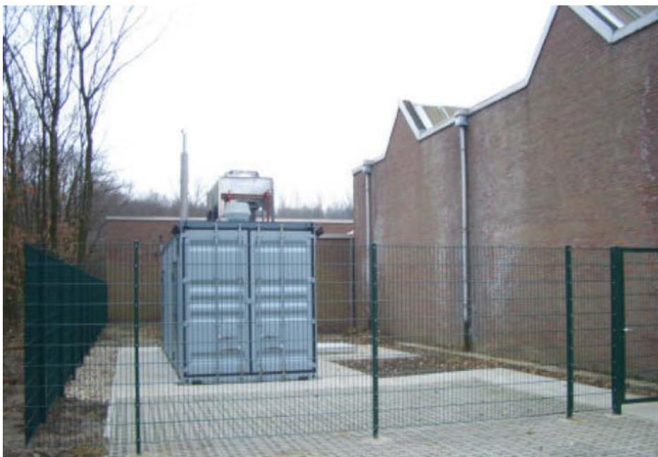
**Bild 5-6: Wasserstoff-BHKW im Container am Schulzentrum in der Welheimer Mark (eigenes Bild)**
