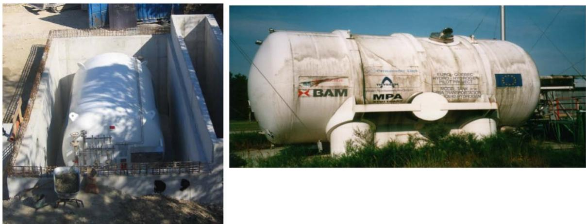
**Bild 3-14: Stationäre Flüssigwasserstofftanks (Tankstelle München und Demoprojekt Schifftransport 60 m<sup>3</sup> LH<sub>2</sub> [5])**
