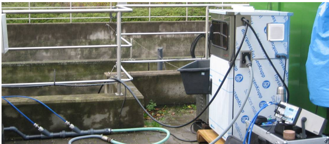
Bild 11.2: Durchflussmessstrecke im Ablauf des Probennehmers (DILKAUTE [2006])
