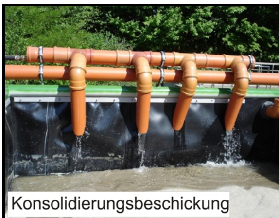
Bild 13.2: Fotos zum Filtereinbau (Dränage, Filtermaterial, Konsolidierung, Zulaufbewärung)
