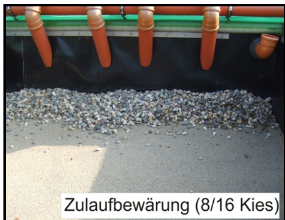
Bild 13.2: Fotos zum Filtereinbau (Dränage, Filtermaterial, Konsolidierung, Zulaufbewärung)
