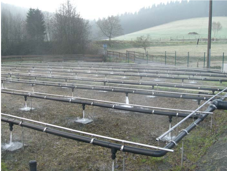
Bild A.3: Verteilersystem der Pflanzenkläranlage Zinse
