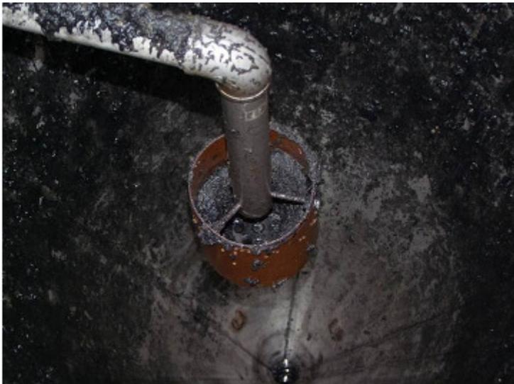
**Bild 6.35: Anlagerung von PAK-Schlamm in der Sedimentation**
