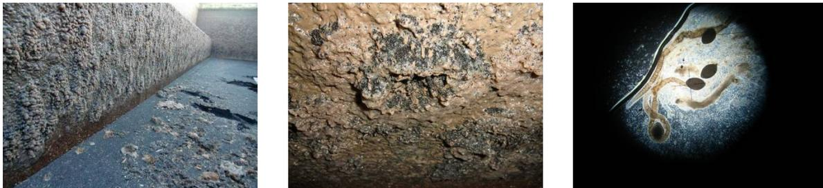
**Bild 4.52: Entleerte Filterzelle mit Biomassenaufwuchs an der Filterinnenwand (l.), Nahaufnahme Biomasse mit inkorporierter GAK (m.) und Lichtmikroskopische Aufnahme der Wassernymphe *Nais* sp. mit Eiern als Hauptbestandteil der Biomasse (r.)**
