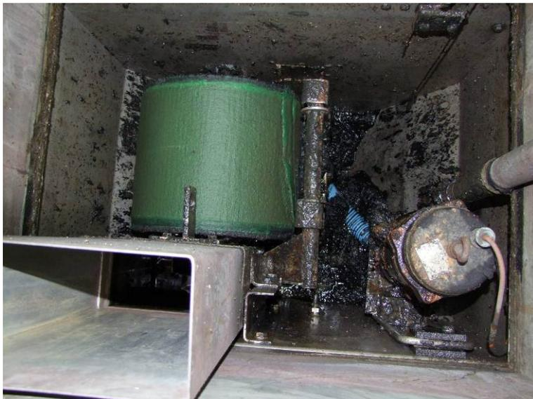
**Bild 6.37: Große Mengen an sedimentiertem PAK-Schlamm**
