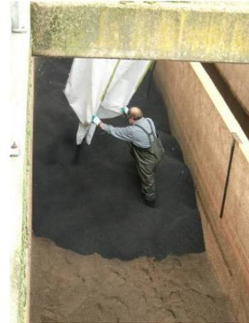
**Bild 4.12: Einfüllen der 1. GAK, 06/2011**
