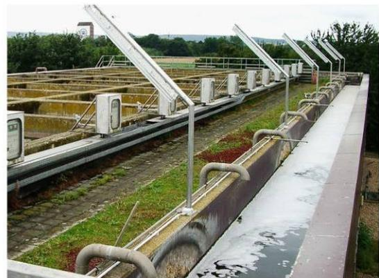
**Bild 4.2: Filter der Kläranlage Düren (links: Nahaufnahme einer Filterzelle, rechts: Gesamtansicht mit Zulaufgerinne)**
