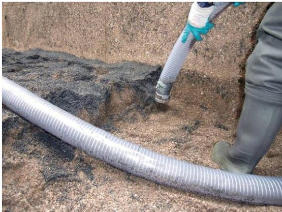
**Bild 4.13: Absaugen der 1. GAK (hier bereits bis auf die Übergangsschicht zwischen alter Filterschicht und 1. GAK abgesaugt), 09/2011**
