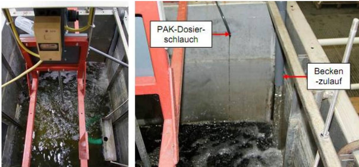
**Bild 6.29: Mischzone des Adsorptionsbeckens mit Detailansicht der PAK-Dosierung**
