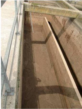
**Bild 4.11: Filterzelle nach Absaugung des alten Filtermaterials bis auf Stützschrift von ca. 40 cm, 06/2011**
