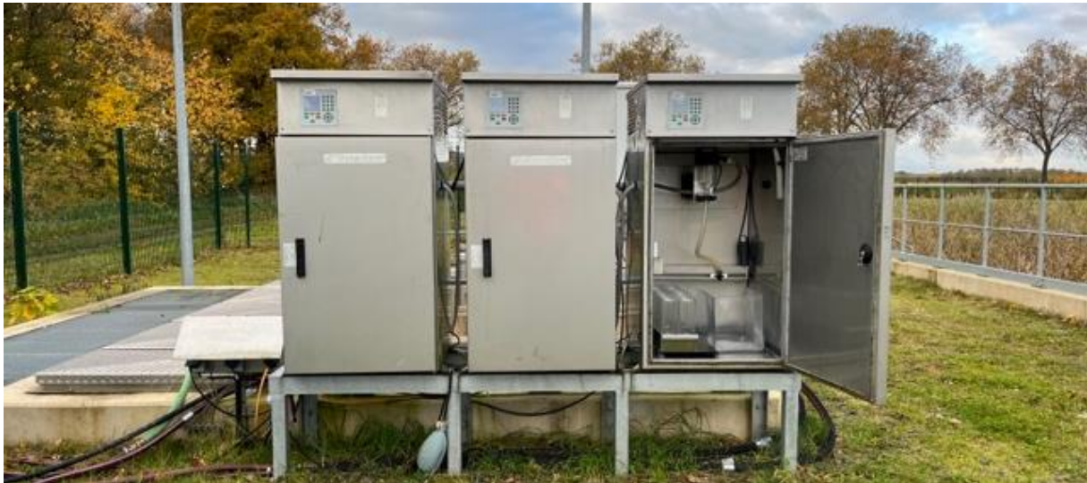
Abbildung 3: Automatische Probenahmegeräte der Firma WaterSam für die drei Abläufe des RBF+ Rheinbach.
