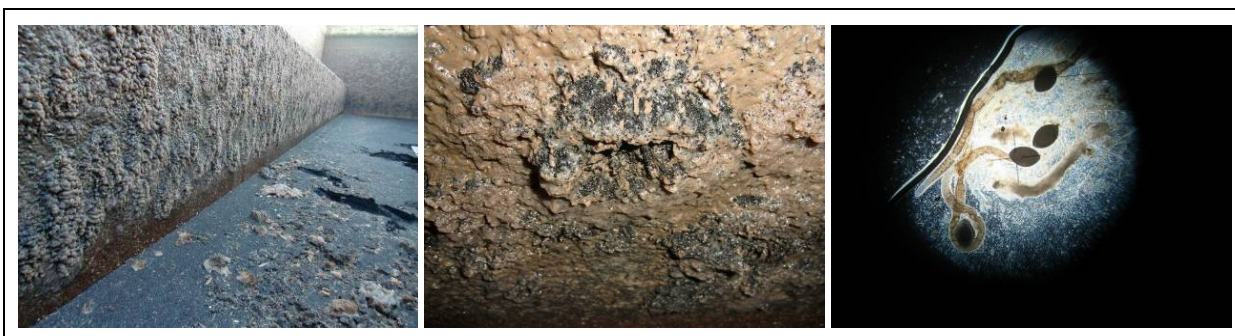
Bild 55: Entleerte Filterzelle mit Biomassenaufwuchs an der Filterinnenwand (l.), Nahaufnahme Biomasse mit inkorporierter GAK (m.) und licht-mikroskopische Aufnahme der Wassernymphe Nais sp. mit Eiern als Hauptbestandteil der Biomasse (r.)
