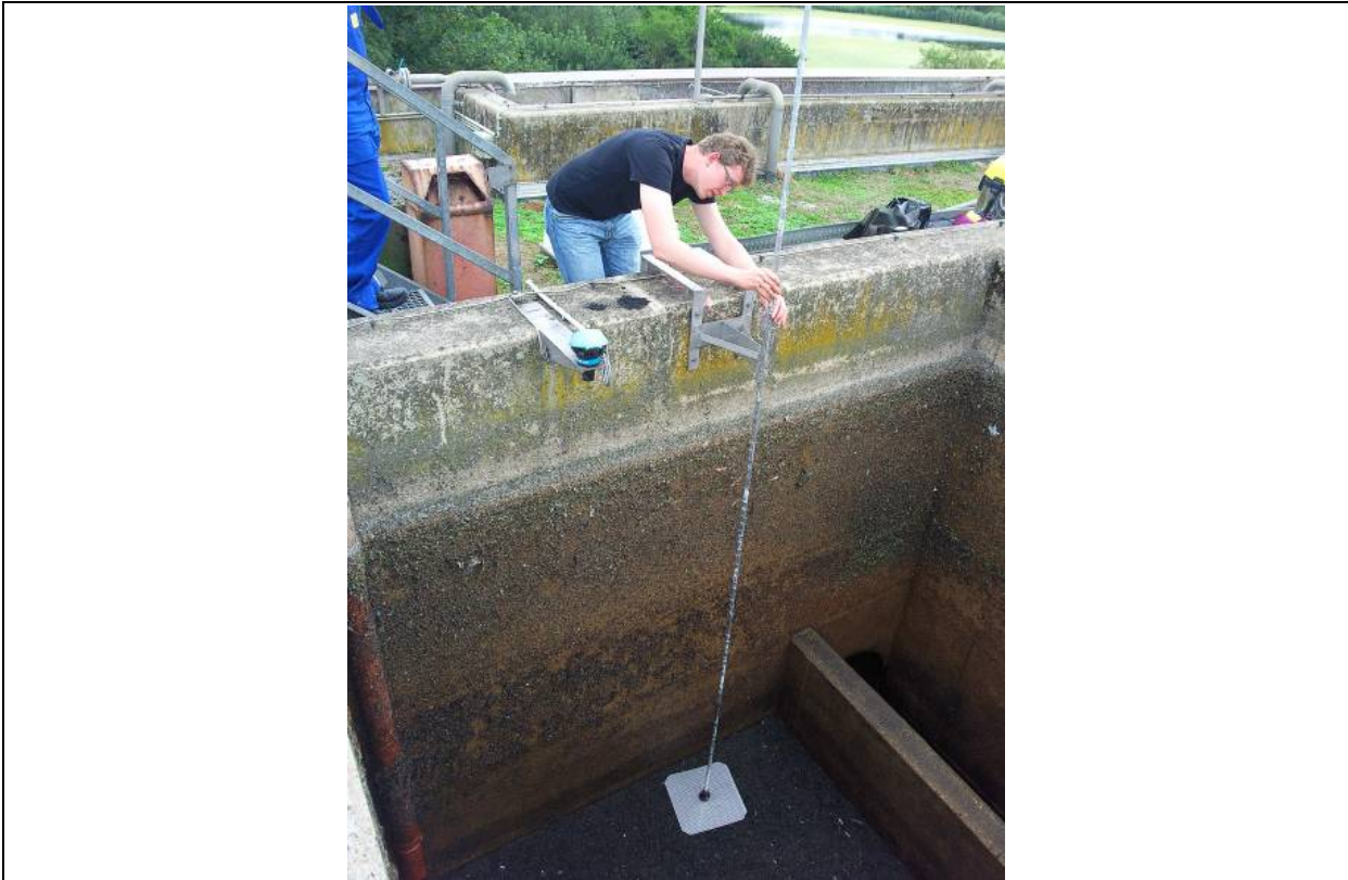
Bild 15: Messung der Filterbetthöhe (hier mit abgelassenem Überstau)
