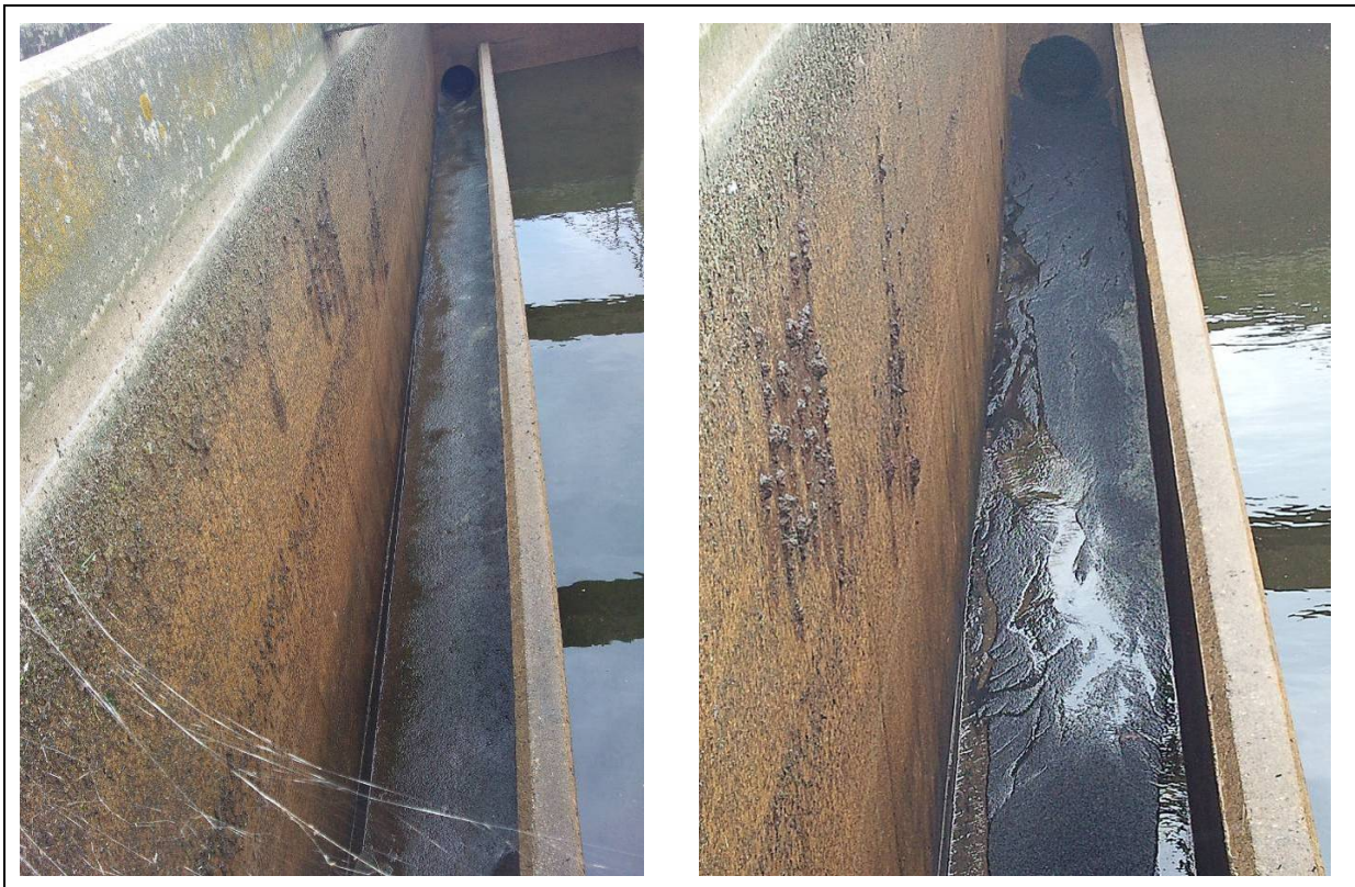
Bild 56: Spülrinne ohne (l.) und mit ausgetragener GAK (r.)
