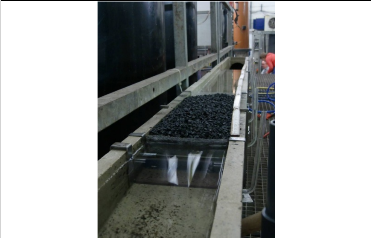
Bild 10: Adsorptionspassage mit eingebauter GAK (hier 0,5 m) auf der HtK-Neuss (Ansicht in Längsrichtung)
