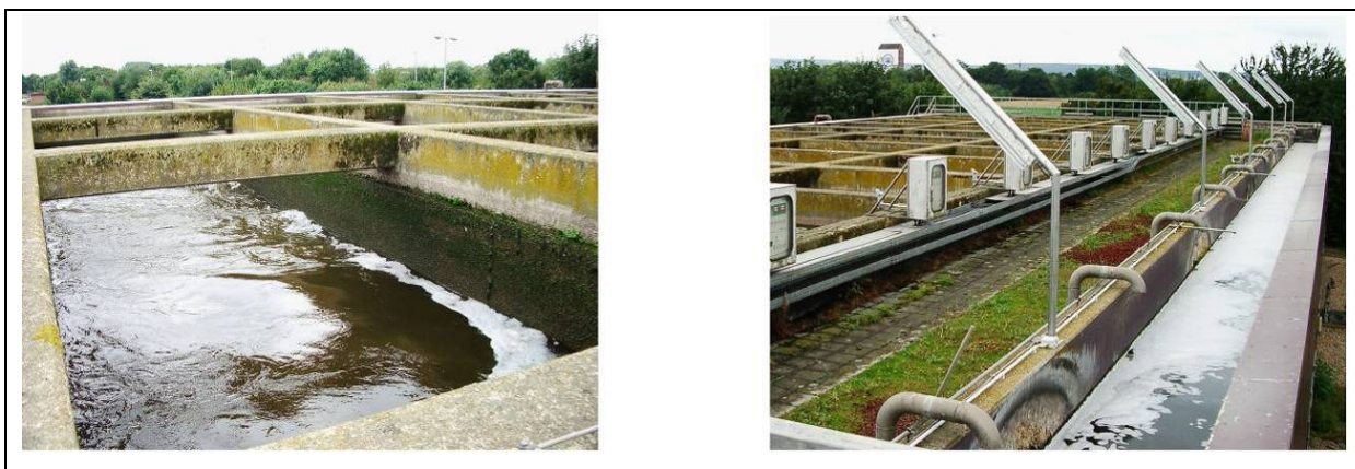
Bild 7: Filter der Kläranlage Düren (links: Nahaufnahme einer Filterzelle, rechts: Gesamtansicht mit Zulaufgerinne)
