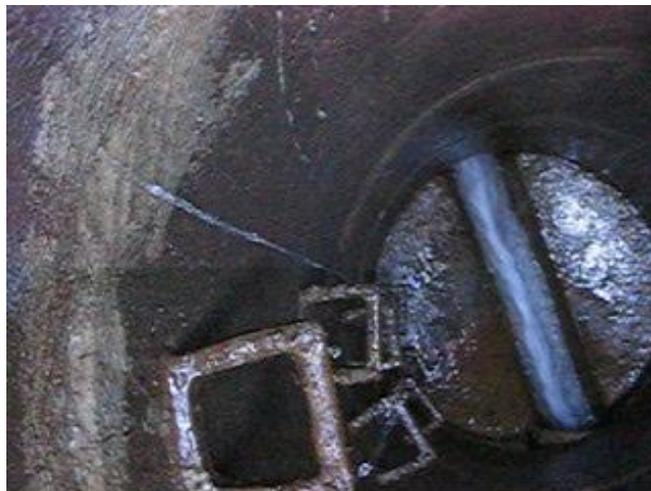
Bild 4 Erneuter Fremdwassereintrag über einen kürzlich sanierten Schachtringzwischenraum 70 cm unter GOK, fotografiert am 16.03.2005
