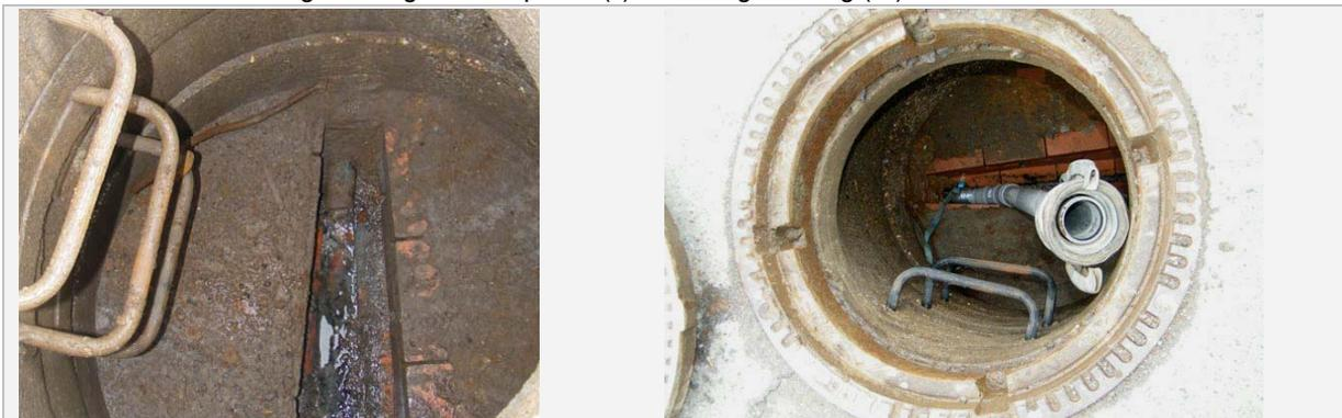
Abb. 66: In Gerinne einragende Druckleitung (li) und Behelf für Anschluss des Saugfahrzeugs (re)
