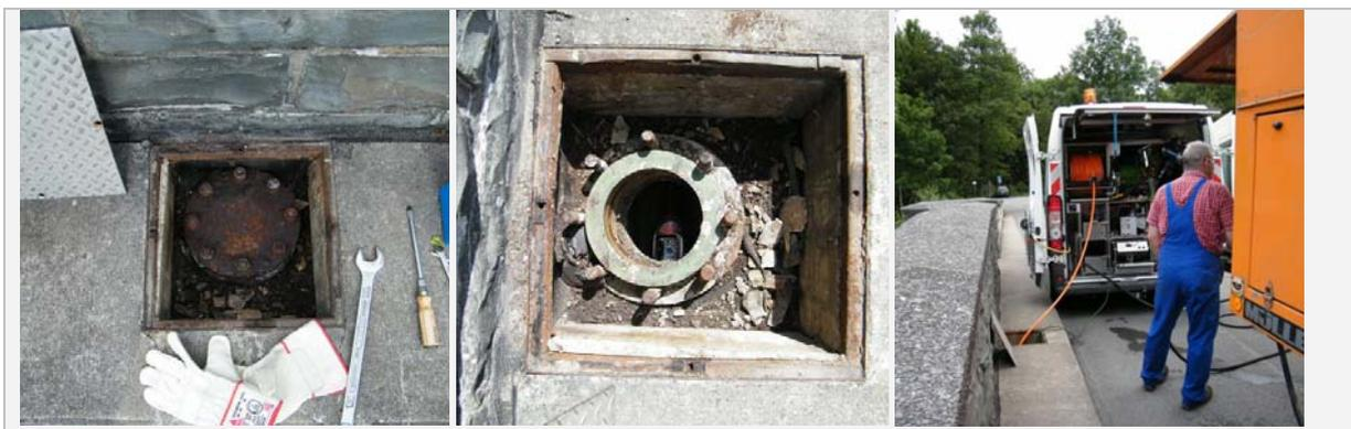
Abb. 88: Revisionsöffnung am Hochpunkt (li und mi), Inspektionsfahrzeug an Revisionsöffnung (re)
