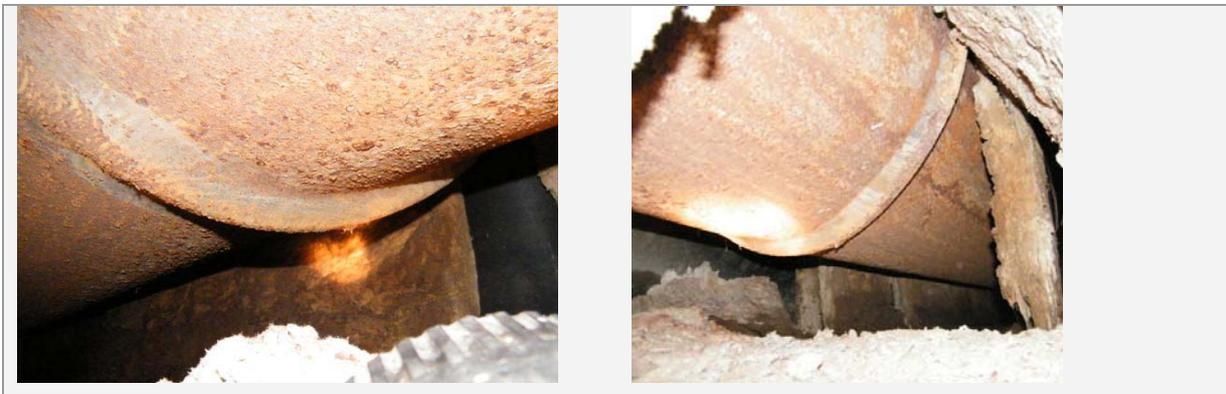
Abb. 123: Rohrverformung (Außenansicht)
