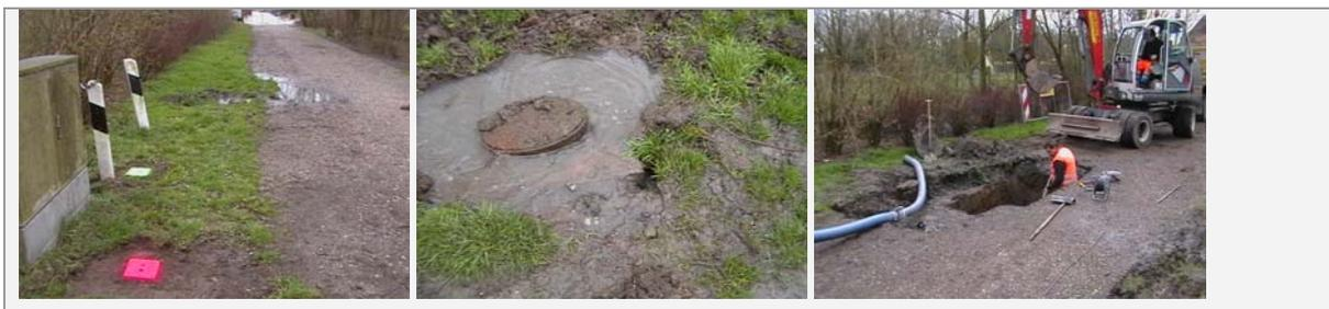
Abb. 49: Schaden an der Geländeoberfläche durch schadhafte Abwasserdruckleitung (li, mi) und Aufgrabung [39]
