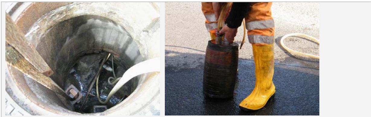
Abb. 56: Übergabeschacht zur Freispiegelkanalisation (li) und Absperrblase (re)
