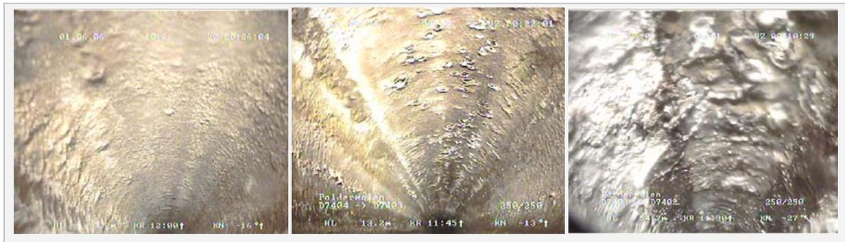
Abb. 25: Blasenbildung (li, mi) und Ablösen von Material (re) der Rohrwand einer Trinkwasser-Asbestzementleitung [47]
