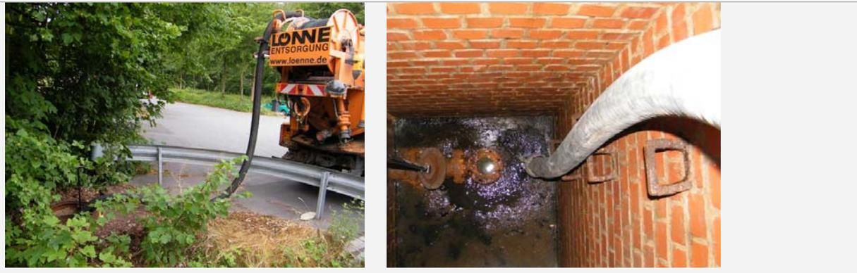
Abb. 92: Saugfahrzeug am Entleerungsschacht (li) und Entleerungsschacht (re)
