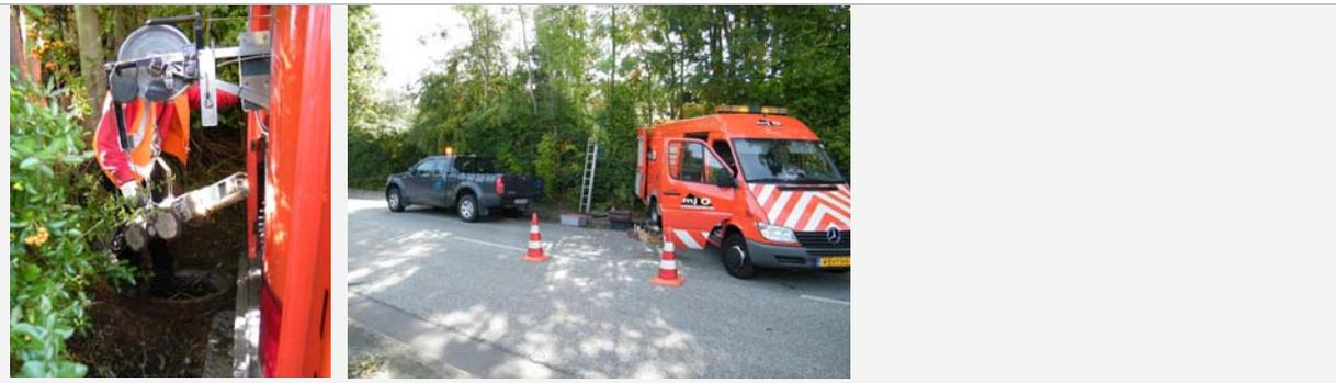
*Abb. 97: Kamera bei Einsatz in Schacht (li) und Baustellensituation (re)*
