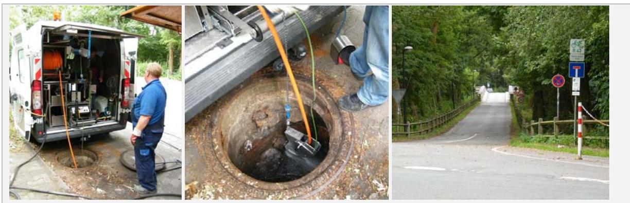
Abb. 89: Inspektionsfahrzeug am Endschacht (li), Führungsrolle im Schacht (mi), Blick Richtung Hochpunkt auf der Brücke (re)
