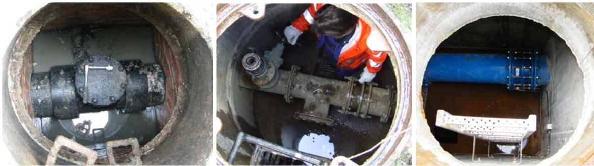
Abb. 8: Revisionsöffnung (li), T-Stück und Spülstutzen (mi) und Passstück (re) in Gussleitungen
