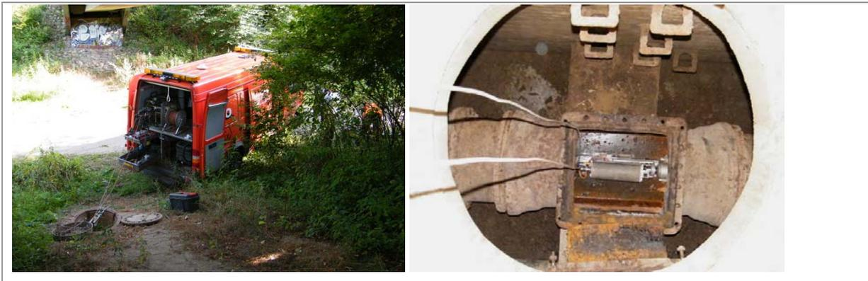
Abb. 101: Schacht mit TV Fahrzeug (li) und Kamera in geöffneter Druckleitung (re)
