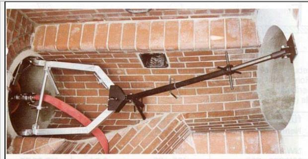
Abb. 51: Verbau von Absperrvorrichtungen [128]
