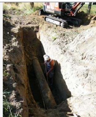
Abb. 114: Freilegen des Rohres
