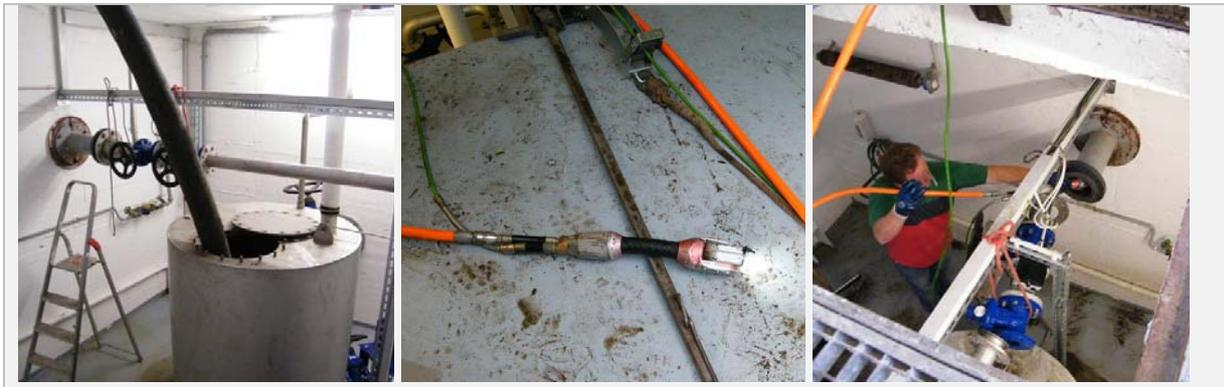
Abb. 87: Entleeren der Leitung: Saugschlauch in Pumpenkessel (li), Lindauer Schere mit 3/4"-Spülschlauch (mi), Einsetzen der Kamera über geöffnete Flanschverbindung (re)
