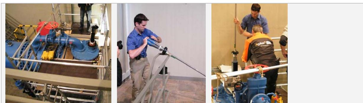
Abb. 126: Startpunkt (li); Greifvorrichtung mit SmartBall® (mi); ; Einbringen des Balls in die Leitung (re)
