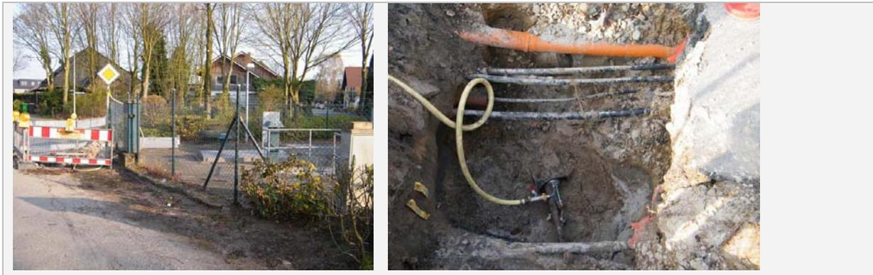
Abb. 54: Kopfloch am Pumpwerk (li) und geöffnete Leitung mit Absperrblase (re)
