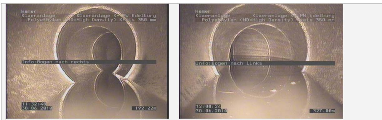
Abb. 72: Beispiele einer Bogenausführung (li) und Bogenstück bei Abbruch der Inspektion (re)
