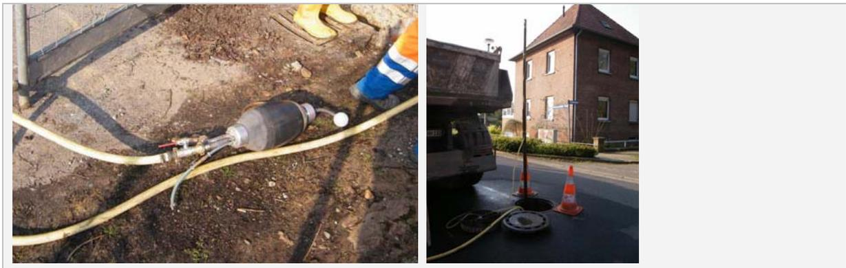
Abb. 55: Absperrblase am Pumpwerk (li) und Übergabeschacht am Druckleitungsende mit Prüfschlauch (re)
