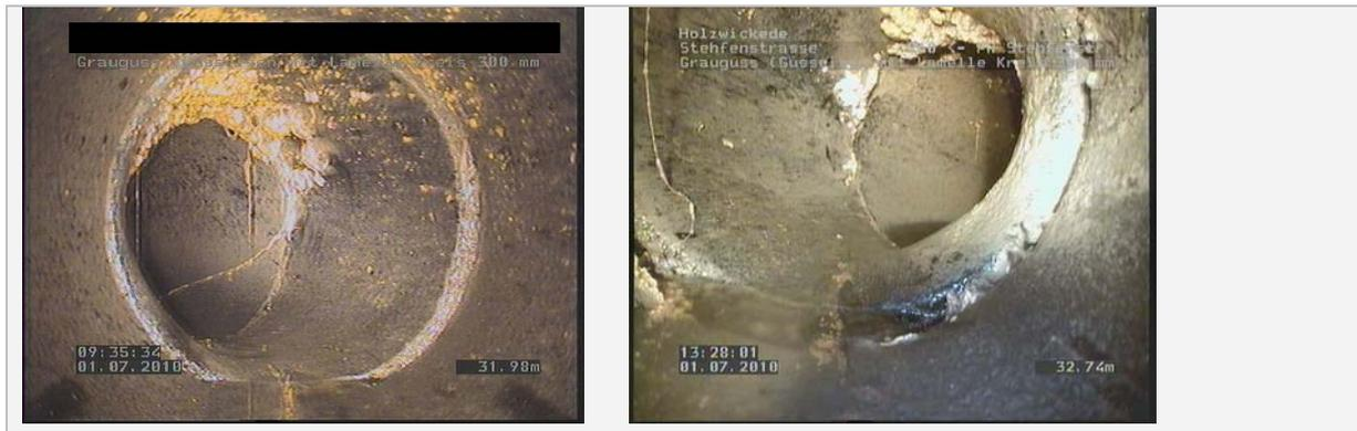
Abb. 79: Bogen (li) und Axialverschiebung mit Muffenspalt (re)
