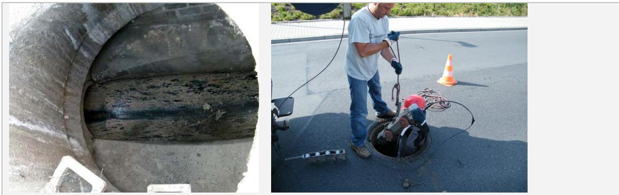
Abb. 77: Ende der Druckleitung im Übergabeschacht (li), Einbringen des großen Fahrwagens (re)
