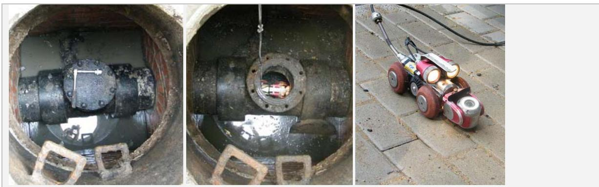
Abb. 78: Revisionsöffnung (li) mit eingesetzter Kamera (mi), kleiner Fahrwagen (re)
