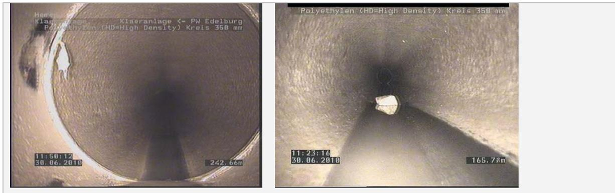
Abb. 73: Ablagerungen oder Wurzeleinwuchs an der Verbindung (li) und Stein in der Leitung (re)
