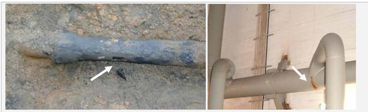
Abb. 17: Lochkorrosion in einer Grauguss-Abwasserdruckleitung und Korrosion einer Stahlleitung in einer Abwasserpumpstation (re) [36]
