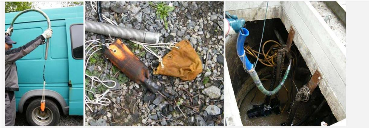
Abb. 64: Schleppekamera mit Saugschirm (li), Beispiele Saugschirm (mi) und Einsetzen der Kamera in Leitungsöffnung an Pumpstation (re)
