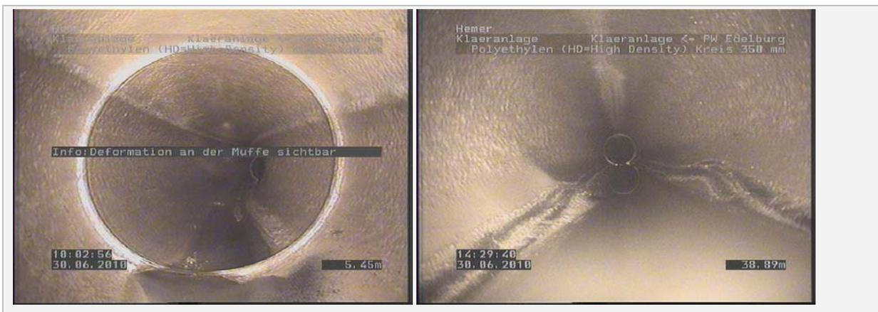
Abb. 19: Ovalisierung (li) und Deformation durch Punktlast in einer PE-HD-Abwasserdruckleitung
