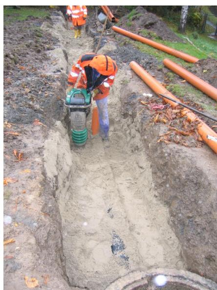
Bild 7.2: Versuchsabschnitt 1: Konventionelle Verdichtung der Seitenverfüllung mittels Vibrations-Stampfer
