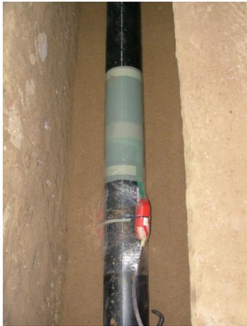
Bild 6.6:PE-Rohr muffenlos
