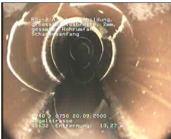
Bild 7.1: Risse und Scherbenbildung bei Station 13,2 m in der Haltung 740 nach 750
