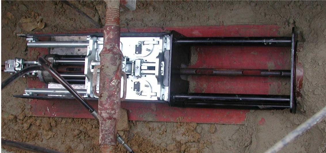
Bild 7.15: Zuggerät Grundoburst 200G beim Einsatz im ersten Versuchsabschnitt
