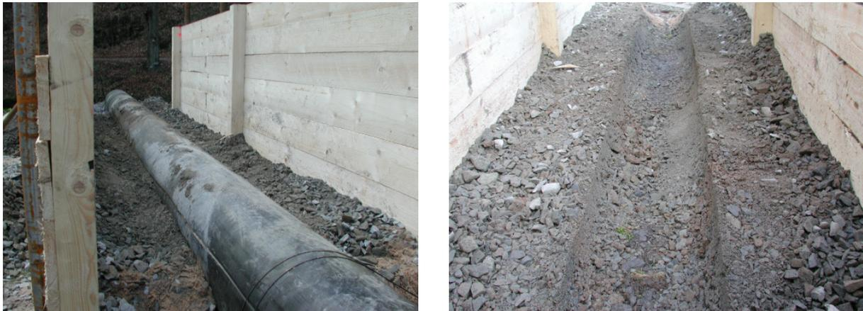
Bild 4.4: Test 2: Überprüfung des Verfüll- und Verdichtungszustandes im Bereich der Rohrzwickele
