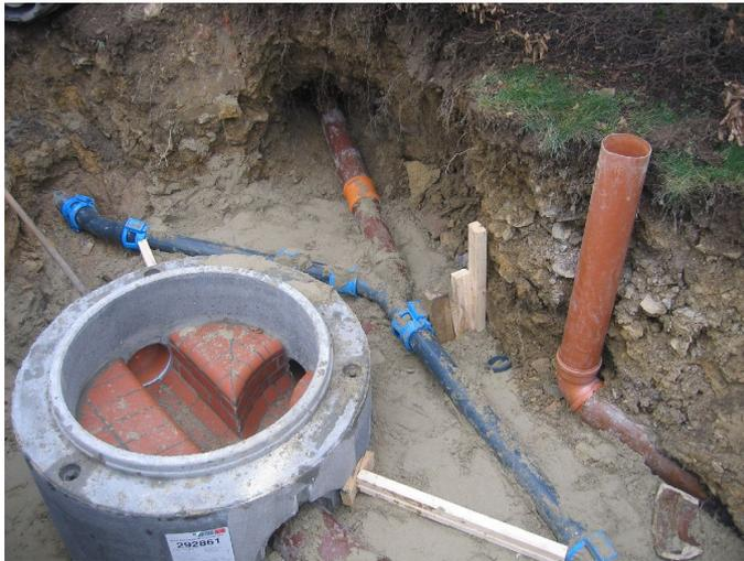
Bild 7.13: Umtrassierung der parallel zur Haltung verlaufenden Wasserleitung am Schachtbauwerk 09M0011900N
