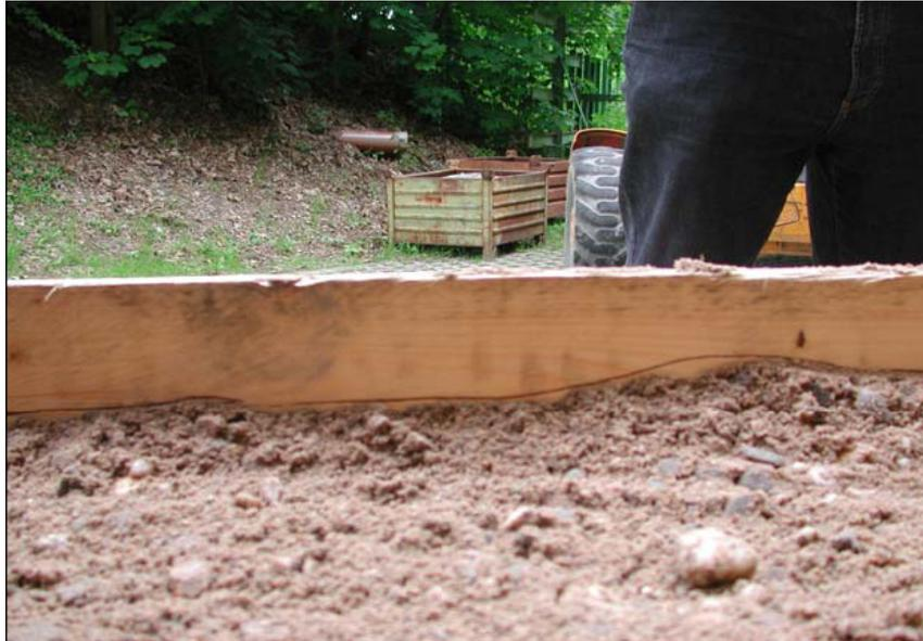
Bild 4.14: Markierung der Bodenhöhe vor Verdichtungsbeginn
