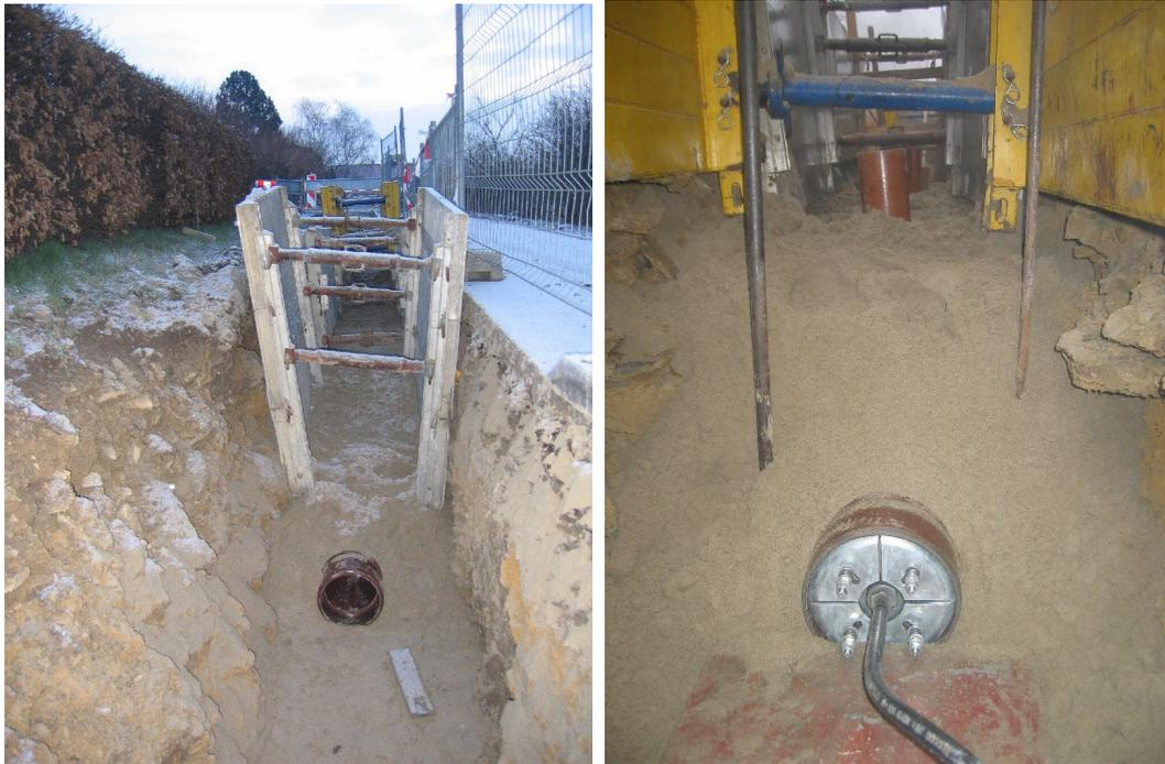
Bild 7.19: Blick auf den Versuchsabschnitt 5: links: Verbaute Leitungsröhre mit offener Rohrleitung am Ende; rechts: Eingebauter Innenverdichter
