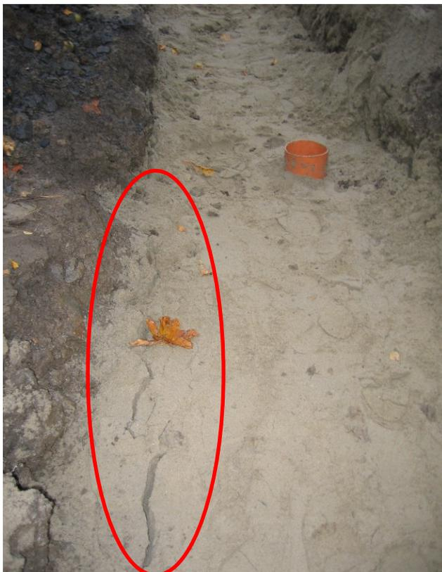
Bild 7.6: Rissbildungen im Sand im Randbereich des Grabens während des Verdichtungsvorganges mit dem Innenverdichter
