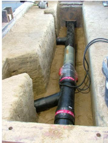
Bild 6.7:PE-Rohr mit Abzweig und Sattelstück
