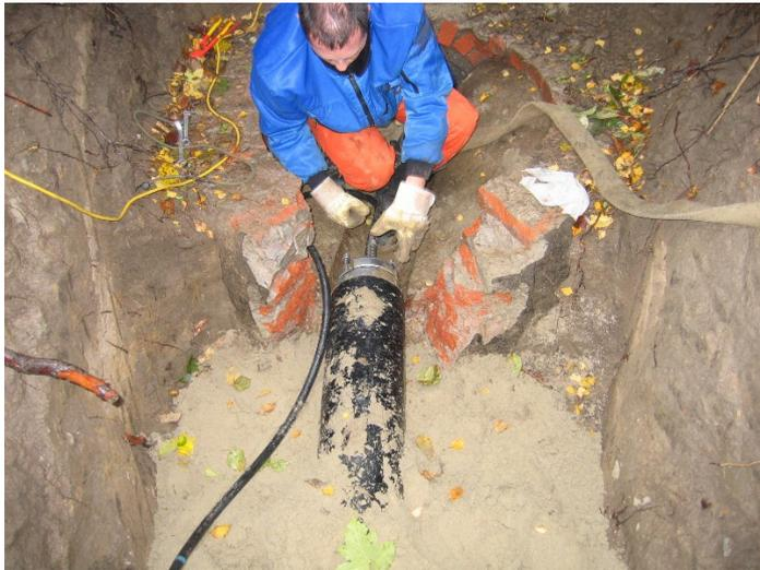
Bild 7.4: Einsetzen und Verspannen des Innenverdichters
