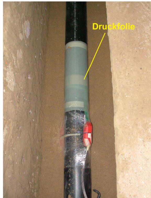
Bild 6.21: Beispiel für die Lage der Druckfolien im Leitungsgaben
