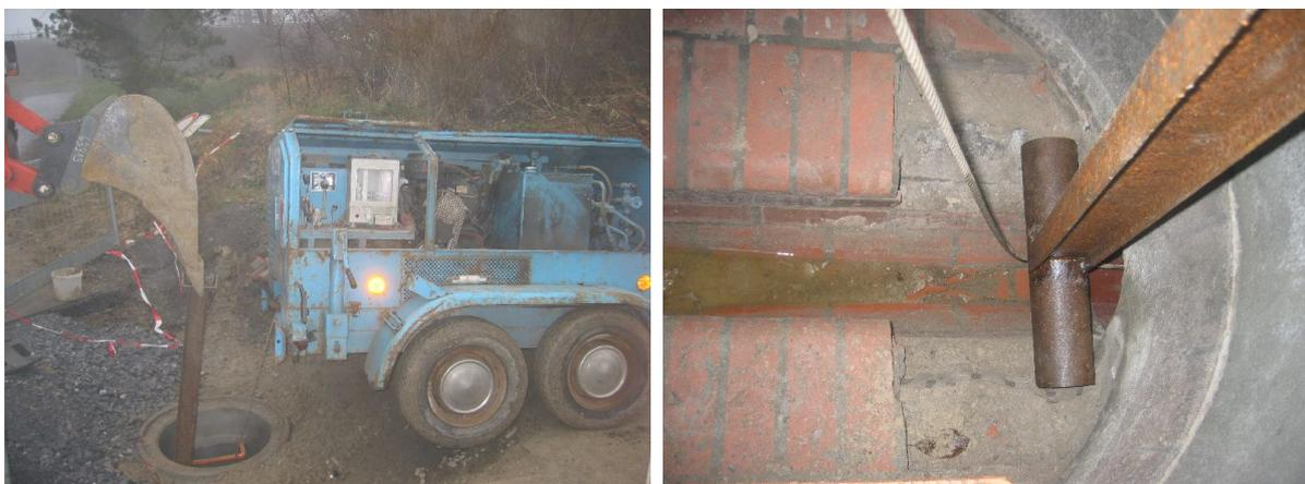
Bild 7.18: Ziehen des Innenverdichters mit der Kabelziehwinde, links: Fixierung der Umlenkrolle mittels Bagger, rechts: Blick auf die Umlenkeinrichtung im Schacht
