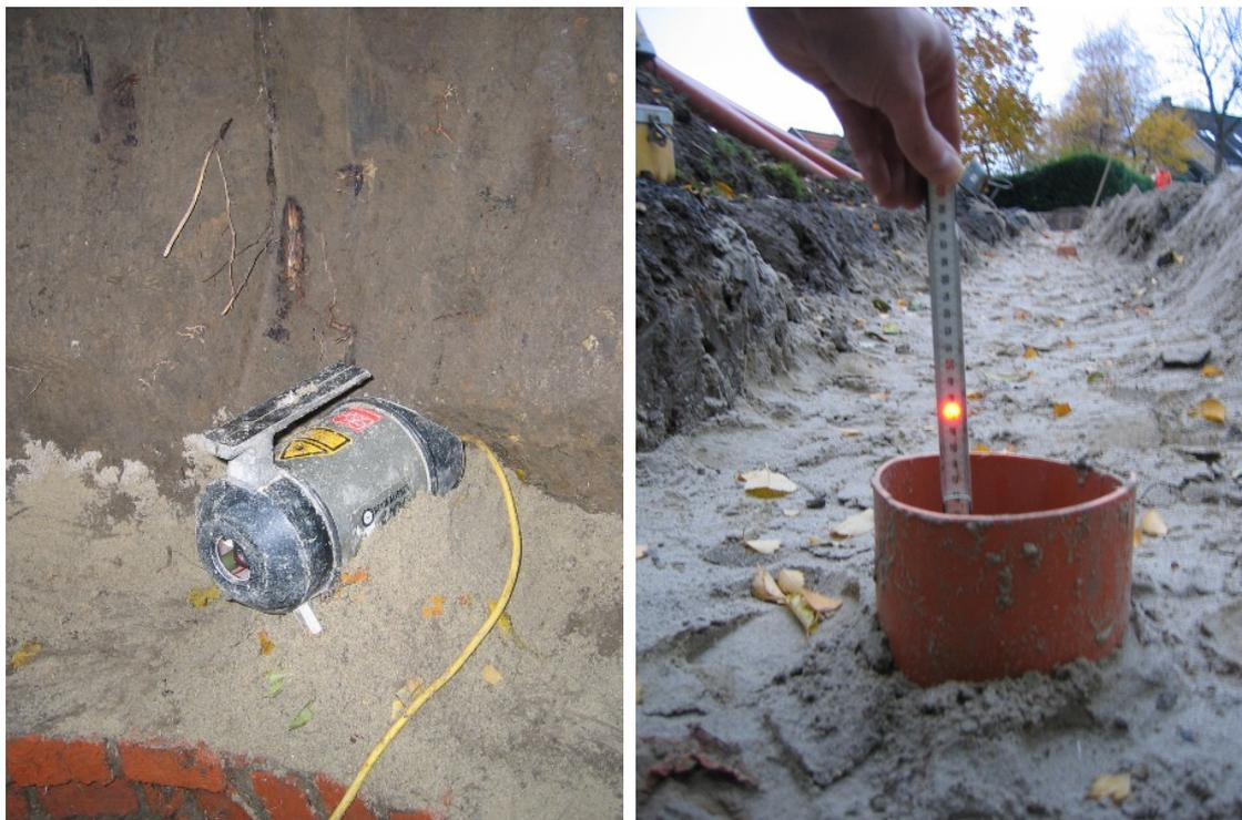
Bild 7.7: Messung der Höhenlage der Rohrleitung vor und nach dem Verdichtungsvorgang (links: Baulaser, rechts: Messung des auf dem Rohrscheitel aufsitzenden KG-Rohres)
