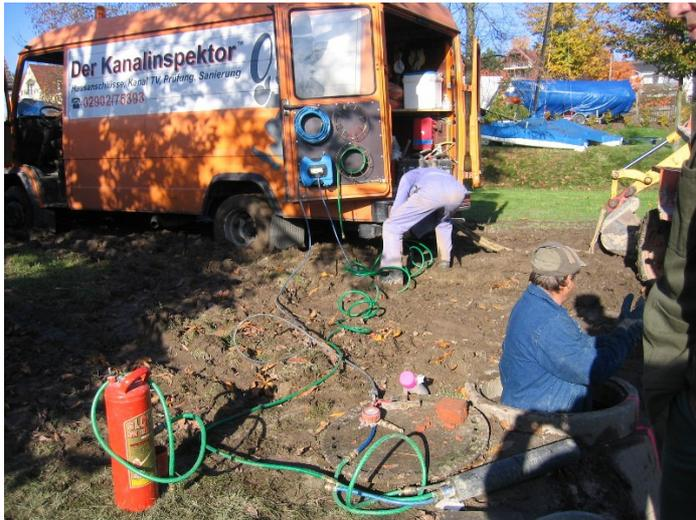
Bild 7.11: Dichtheitsprüfung nach DIN EN 1620 in den Versuchsabschnitten 1 und 2
