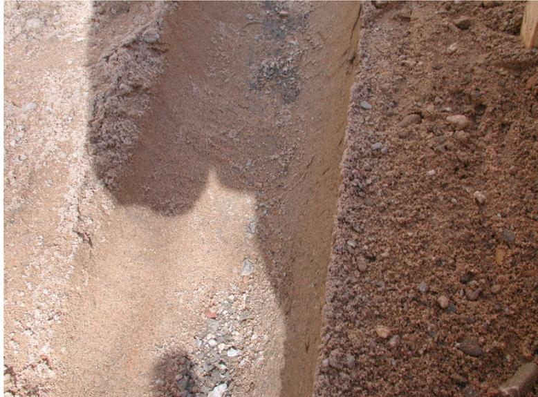
Bild 4.8: Test 4: Optischer Nachweis der Verfällung und Verdichtung der Rohrzwickelbereiche
