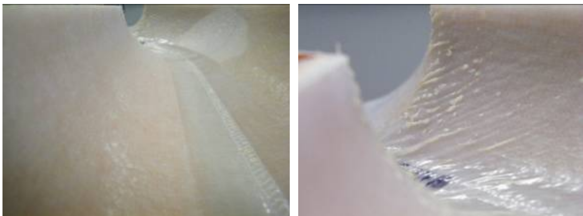
Abbildung 55: Hausanschlussliner nach dem Einsatz der Kettenschleuder lineTEC ProFlex, Harzsystem: Biresin lineTEC EP 40, DN 125, VFG Vereinigte Filzfabriken AG, Giengen
