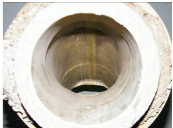
Steinzeug-Bogen 30°, DN 150, vertikal angeordnet, in Fließrichtung
