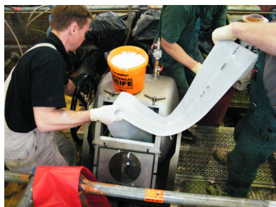
j) und k) Einziehen des mit Gleitmittel benetzten Schlauches in die Inversionstrommel
