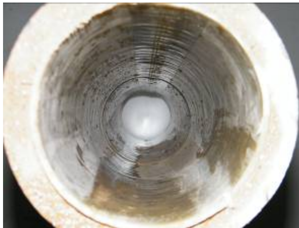
Steinzeug DN 150, Scheitelriss
