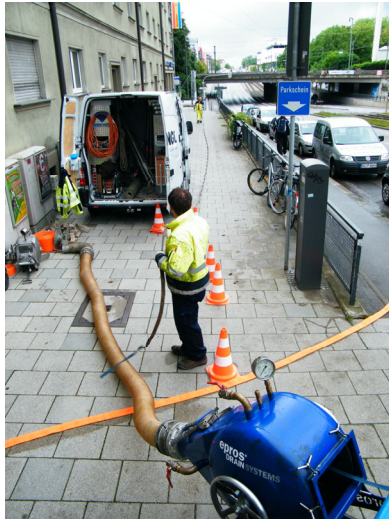
d) Vorbereitung des Invertierens
