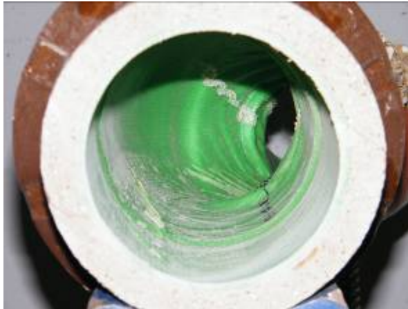
Übergang PVC-KG DN 125 auf Steinzeug DN 125
