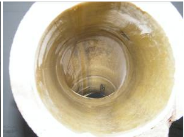
Steinzeug-Bogen 30°, DN 150, vertikal angeordnet, in Fließrichtung
