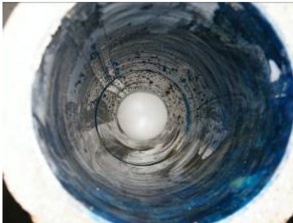
Steinzeug DN 150, Scheitelriss
