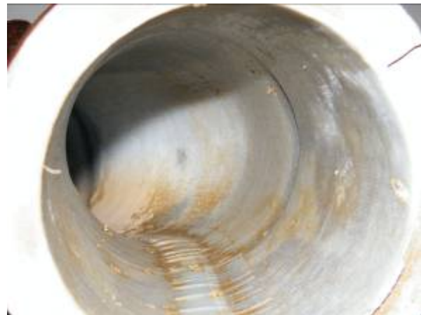
Steinzeug-Bogen 45°, DN 150, horizontal angeordnet, gegen Fließrichtung
