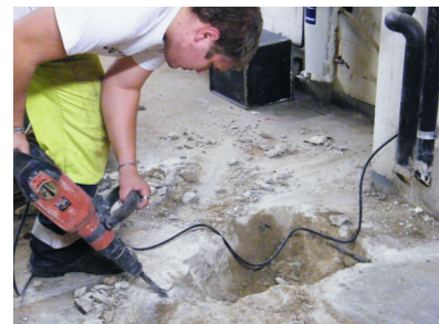
c) Aufstemmen des Bodeneinlaufs
