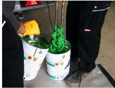
g) und h) Mischen von Komponente A und B
