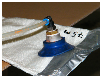
e) Entlüften des Liners
