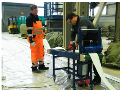
j) und k) Imprägnieren des Liners
