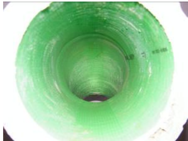
Steinzeug-Bogen 30°, DN 150, vertikal angeordnet, in Fließrichtung
