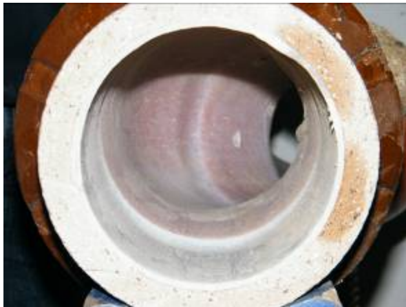
Übergang PVC-KG DN 125 auf Steinzeug DN 125
