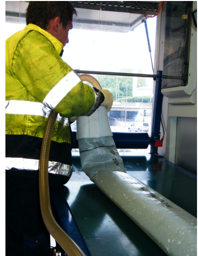
f) Einfüllen des Harzes
