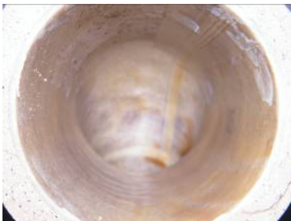
Steinzeug-Bogen 45°, DN 150, vertikal angeordnet, in Fließrichtung
