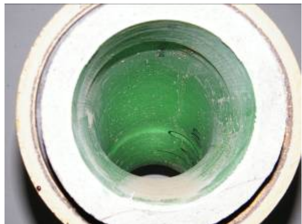
Steinzeug-Bogen 30°, DN 150, vertikal angeordnet, in Fließrichtung
