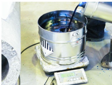
d) Abwiegen der Harzkomponenten
