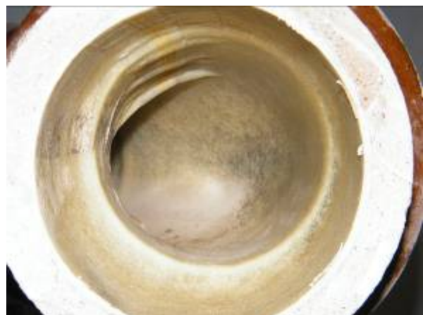
Steinzeug-Bogen 45°, DN 125, Nennweiten wechsel DN 125 auf DN 150, gegen Fließ- richtung
