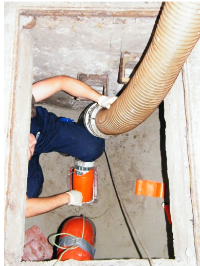
h) Inversionstrummel mit aufgewickeltem Liner
