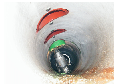
o) Nacharbeiten im Hauptkanal
