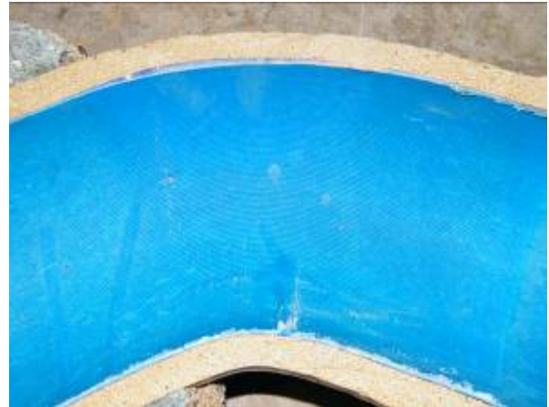
Steinzeug-Bogen 45°, DN 125, Sohlbereich vertikal angeordnet
