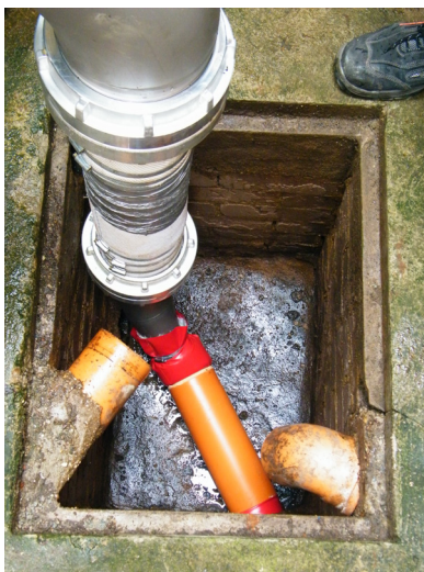
j) und k) Inversions des Liners und des Kalibrierschlauches
