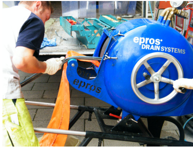
m) Aufrollen des Kalibrier-schlauches
