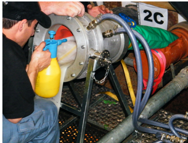
j) und k) Inversion des Liners mit einer „Linergun“
