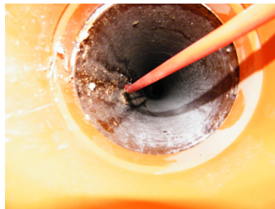
b) Reinigung der Leitung
