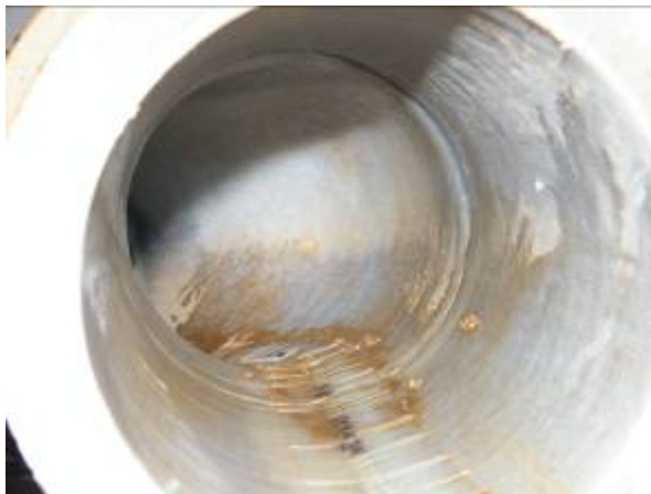
Steinzeug-Bogen 45°, DN 150, horizontal angeordnet, in Fließrichtung
