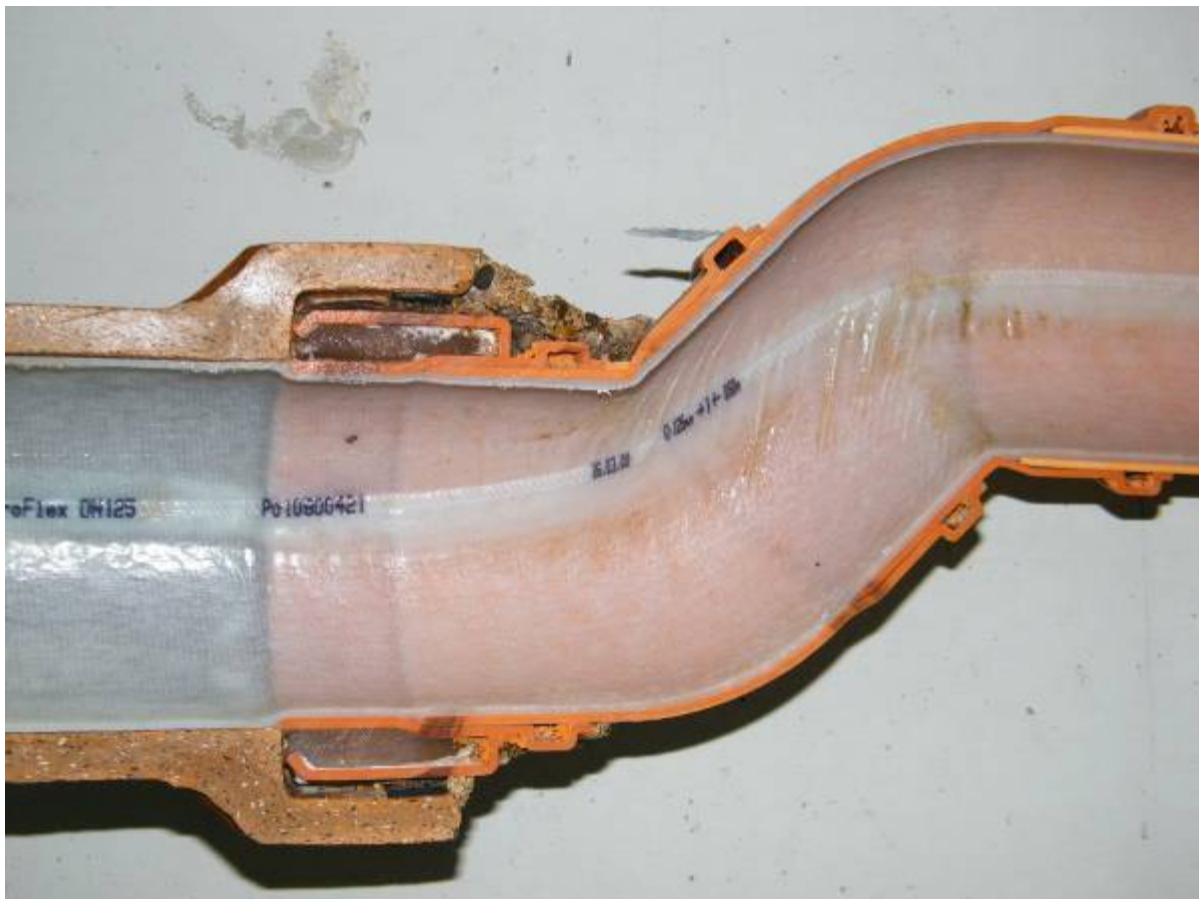
PVC-KG-Bögen 45°, DN 125, Übergang auf Steinzeug DN 125, Sohlbereich, horizontal angeordnet
