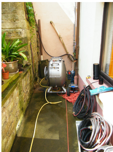
j) und k) Inversions des Liners und des Kalibrierschlauches
