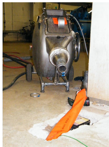
e) Vorbereitung des Einbaus des Kalibrierschlauches
