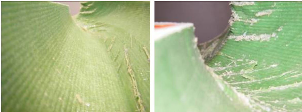
Abbildung 51: Hausanschlussliner nach dem Einsatz der Kettenschleuder BRAWOLINER XT, Harzsystem: BRAWO I, DN 125, Karl Otto Braun GmbH & CO. KG, Wolfstein
