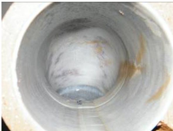
Steinzeug-Bogen 45°, DN 150, vertikal angeordnet, in Fließrichtung
