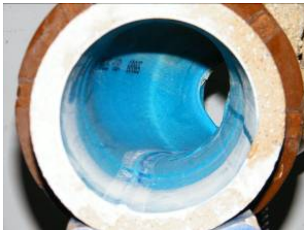
Übergang PVC-KG DN 125 auf Steinzeug DN 125
