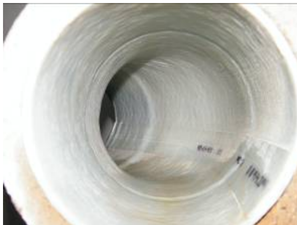
Steinzeug-Bogen 30°, DN 150, horizontal angeordnet, in Fließrichtung
