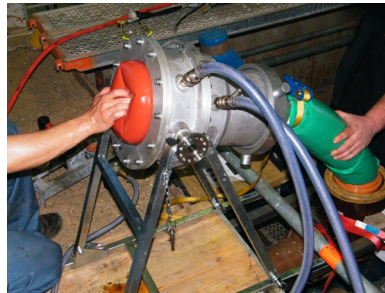
j) und k) Inversion des Liners mit einer „Linergun“
