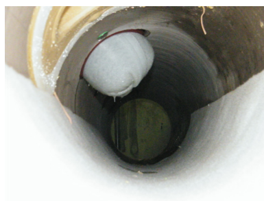
n) geschlossenes Linierende im Hauptkanal
