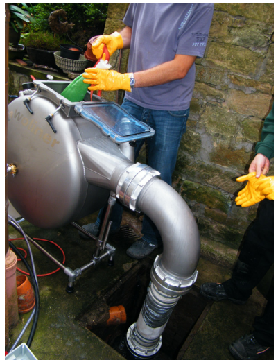
i) Aufrollen des Liners in die Inversionstrommel
