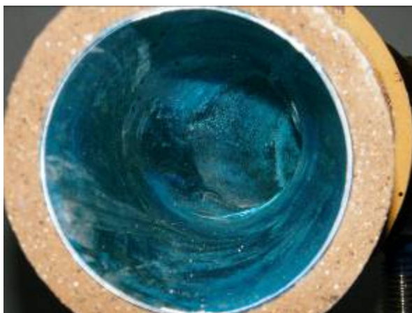
Steinzeug-Bogen 30°, DN 150, horizontal angeordnet, in Fließrichtung
