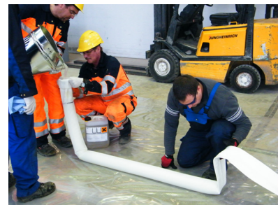
i) Einfüllen des Harzes
