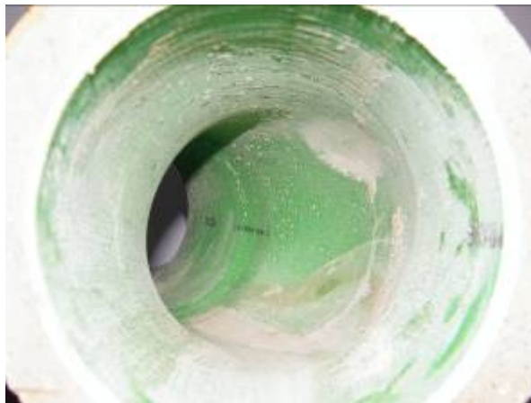
Steinzeug-Bogen 30°, DN 150, horizontal angeordnet, in Fließrichtung
