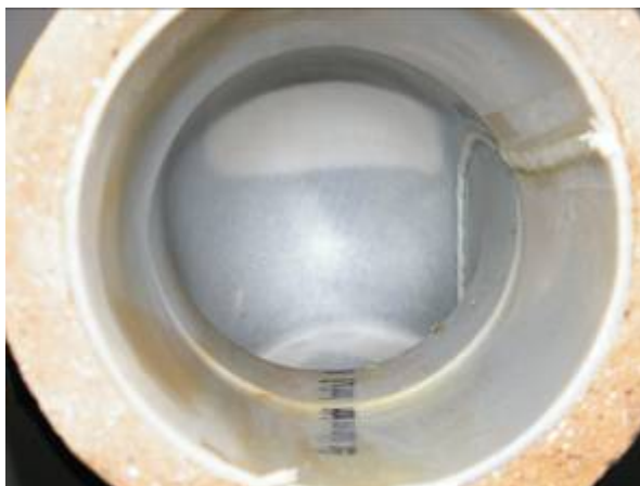
Steinzeug-Bogen 45°, DN 150, vertikal angeordnet, in Fließrichtung
