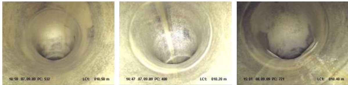
Bewertung RS MaxLiner-FLEX S, Harzsystem: MaxPox 15-40, RS-Technik AG, Esslingen
