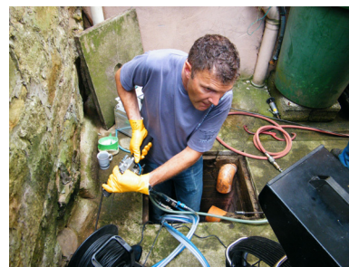
o) Aufräumen eines Seitenzu- laufs mit Fräsroboter
