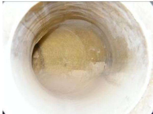
Steinzeug-Bogen 45°, DN 150, horizontal angeordnet, gegen Fließrichtung
