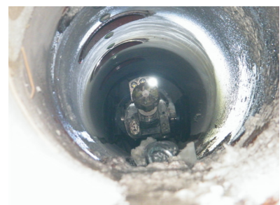
o) Nacharbeiten im Hauptkanal
