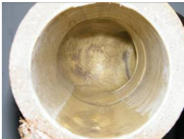
Steinzeug-Bogen 30°, DN 150, horizontal angeordnet, in Fließrichtung
