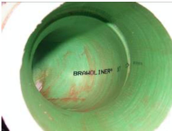
Steinzeug-Bogen 45°, DN 150, horizontal angeordnet, in Fließrichtung
