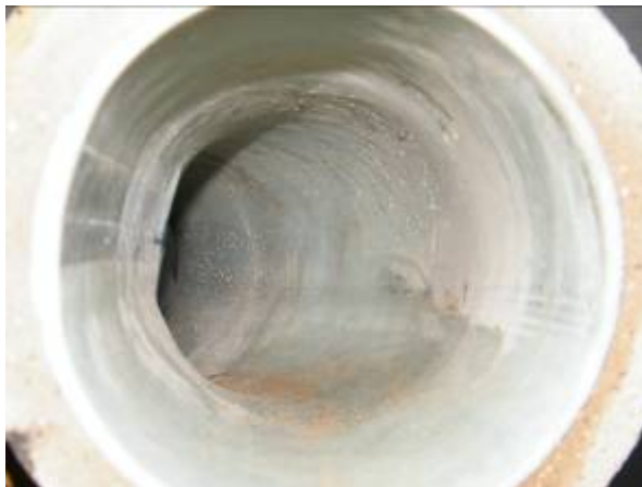
Steinzeug-Bogen 30°, DN 150, horizontal angeordnet, in Fließrichtung
