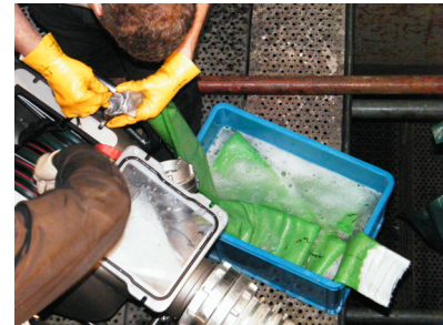
l) Einziehen des mit Gleitmittel benetzten Schlauches in die Inversionstrommel
