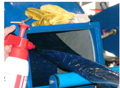
i) Einziehen des mit Gleitmittel benetzten Schlauches in die Inversionstrommel
