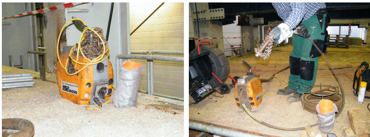
Abbildung 49: Einsatz der Kettenschleuder
