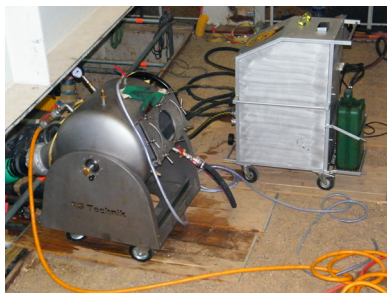
m) Inversion des Kalibrierschlauches
