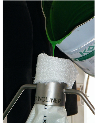
f) Einfüllen des Harzes
