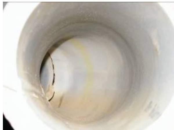
Steinzeug-Bogen 45°, DN 150, horizontal angeordnet, gegen Fließrichtung
