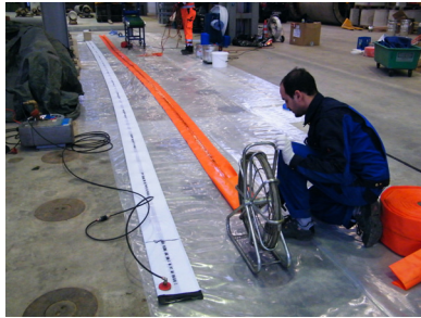
d) Ablängen des Liners und des Kalibrierschlauches
