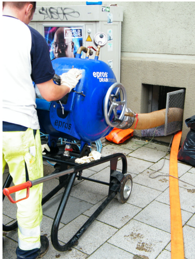
j) und k) Inversionsvorgang des Liners
