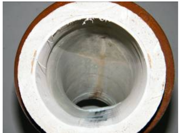
Steinzeug-Bogen 30°, DN 150, vertikal angeordnet, in Fließrichtung
