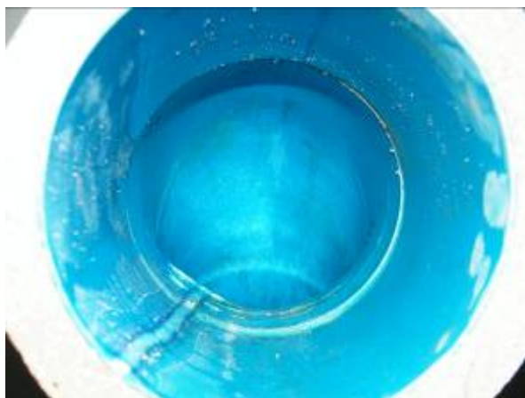
Steinzeug-Bogen 45°, DN 150, vertikal angeordnet, in Fließrichtung
