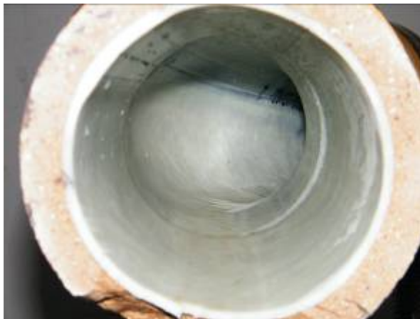
Steinzeug-Bogen 30°, DN 150, horizontal angeordnet, in Fließrichtung
