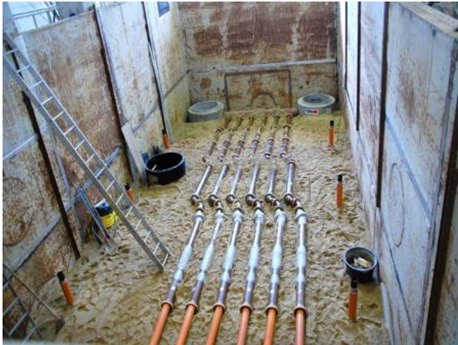
Abbildung 60: Tiefste Rohrlage vor der Überschüttung, spätere Überschüttungshöhe 5 m
