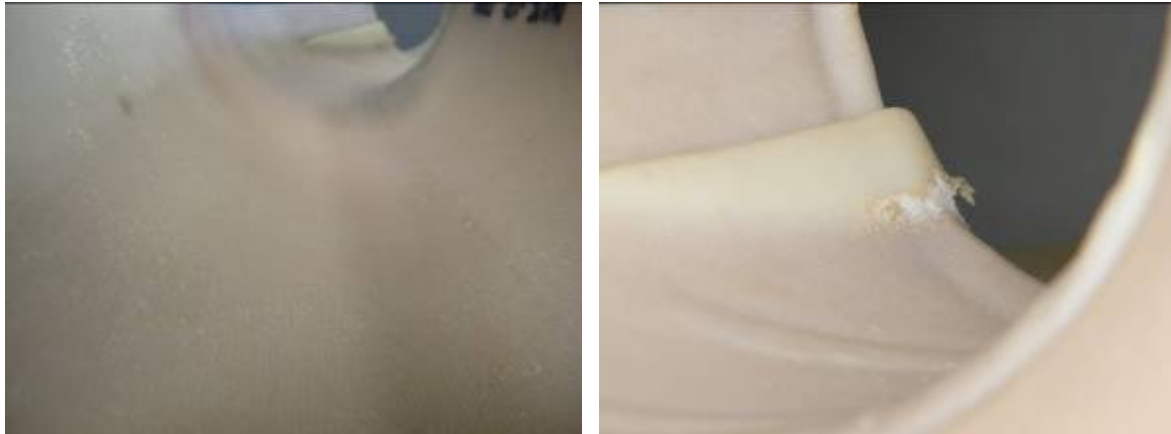
Abbildung 53: Hausanschlussliner nach dem Einsatz der Kettenschleuder DrainPlusLiner, Harzsystem: EPROPOX VIS A2/B2, DN 125, Trelleborg Pipe Seals Duisburg GmbH, Duisburg
