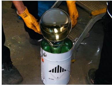
g) und h) Mischen von Komponente A und B
