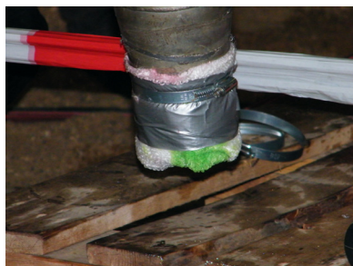
m) Linerende am Inversionsbogen
