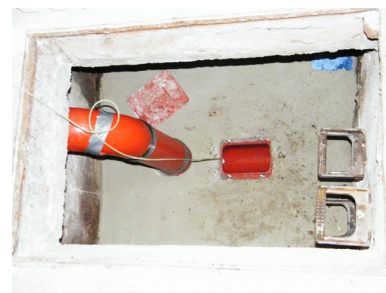
c) Revisionsschacht mit Reinigungsöffnung
