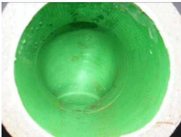
Steinzeug-Bogen 45°, DN 150, vertikal angeordnet, in Fließrichtung
