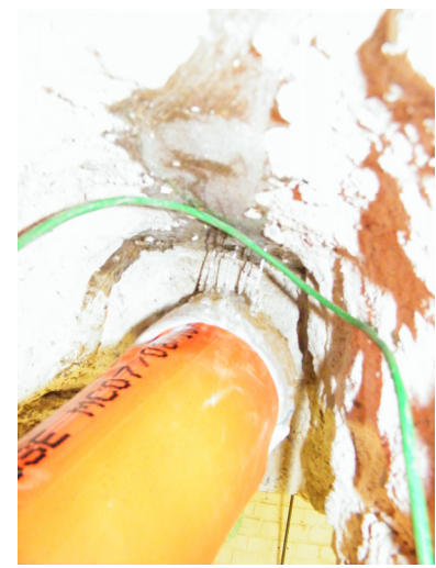
f) Invertierter Kalibrierschlauch am Leitungszugang
