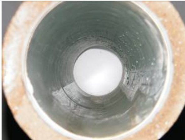
Steinzeug DN 150, Scheitelriss
