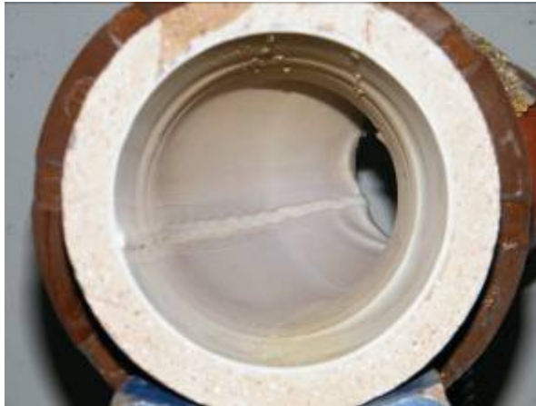
Übergang PVC-KG DN 125 auf Steinzeug DN 125
