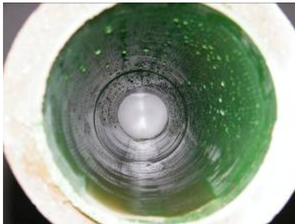
Steinzeug DN 150, Scheitelriss
