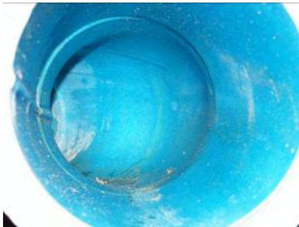
Steinzeug-Bogen 45°, DN 150, horizontal angeordnet, in Fließrichtung
