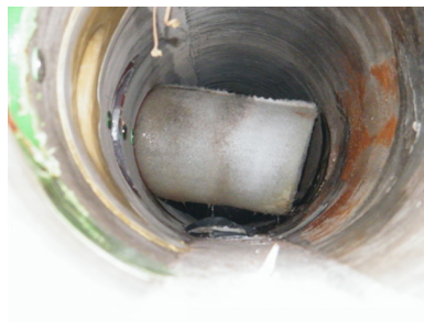
n) Aufgestelltes Linerende im Hauptkanal
