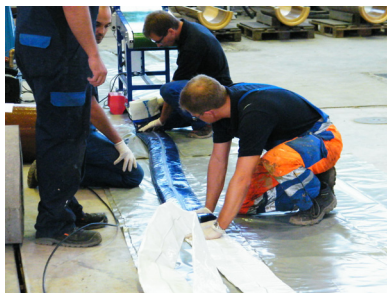
g) und h) Imprägnieren des Liners
