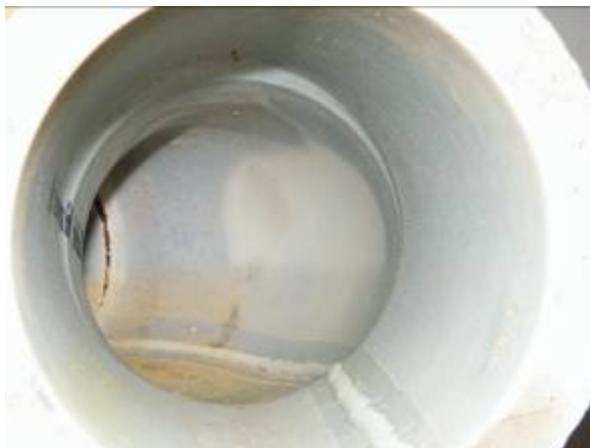
Steinzeug-Bogen 45°, DN 150, horizontal angeordnet, in Fließrichtung
