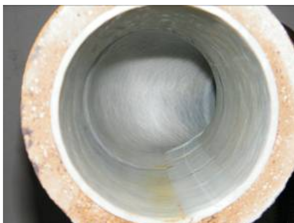
Steinzeug-Bogen 30°, DN 150, horizontal angeordnet, in Fließrichtung
