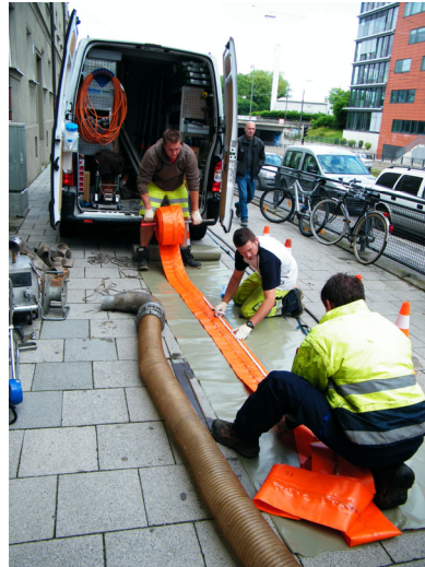
e) Zuschchnitt des Kalibrierschlauches
