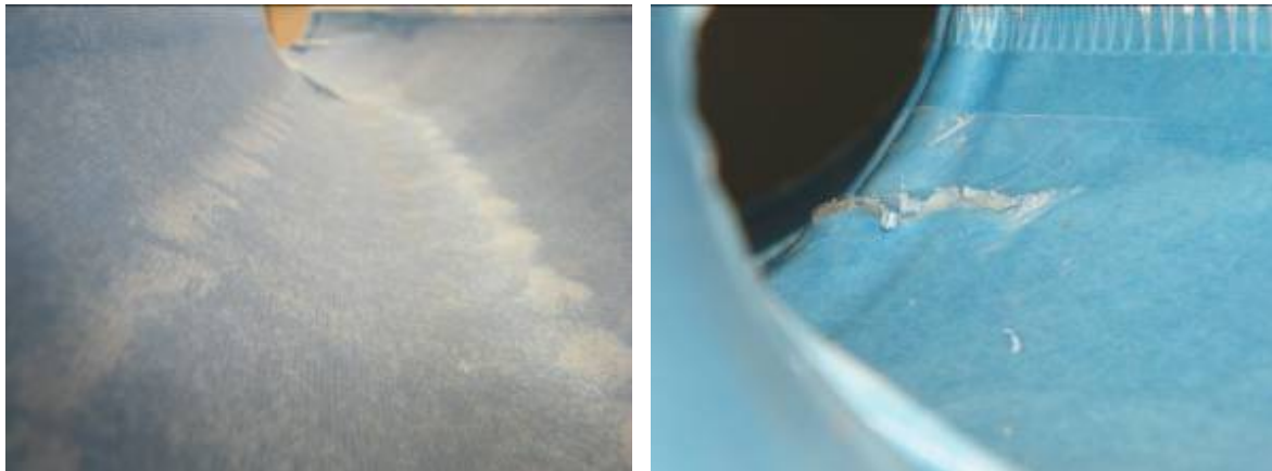
Abbildung 54: Hausanschlussliner nach dem Einsatz der Kettenschleuder epros ® DrainPlusGlassLiner (Prototyp), Harzsystem: EPROPOX VIS A4/B4, DN 125, Trelleborg Pipe Seals Duisburg GmbH, Duisburg
