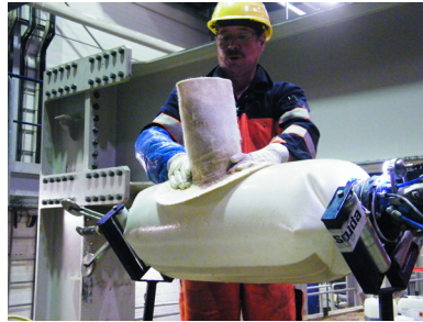
q) und r) Einbau der epros®LCR-S Hutmanschetten
