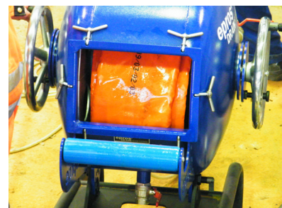
o) Kalibrierschlauch in der Inversionstrommel
