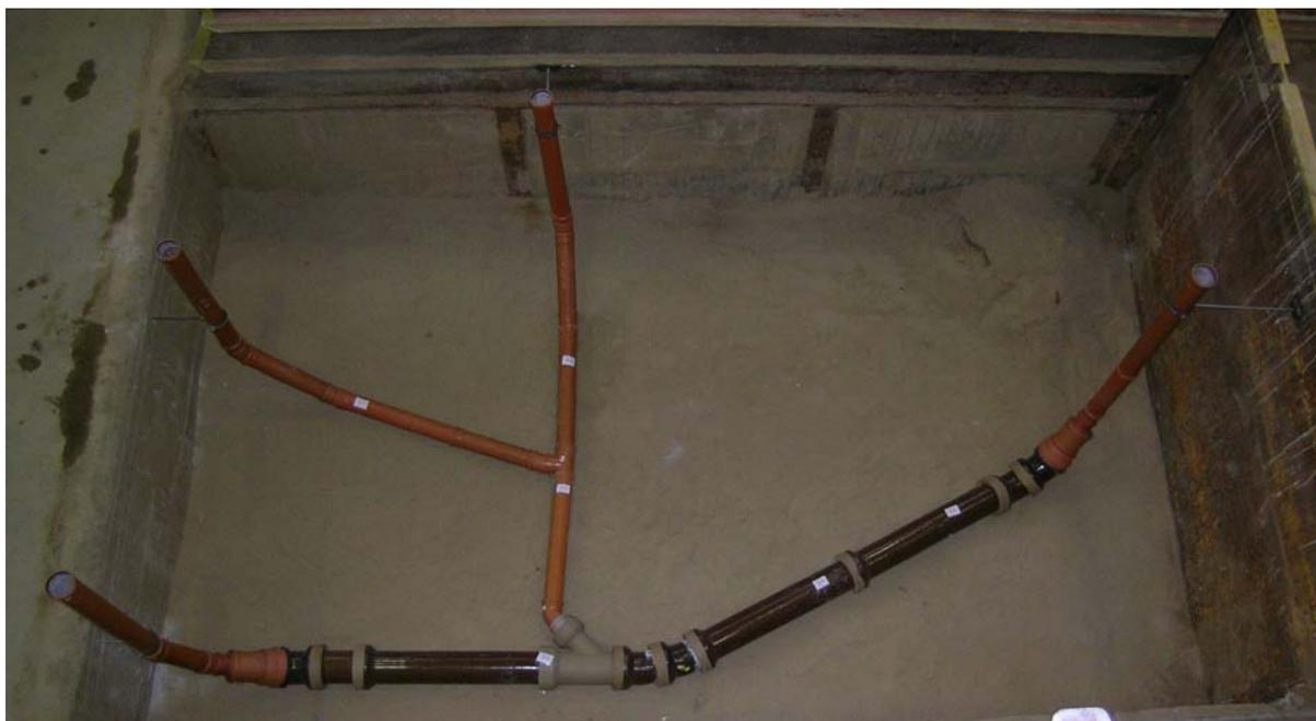
Abbildung 5-18: Eingebautes Grundleitungsnetz aus Kunststoff- und Steinzeugrohren
