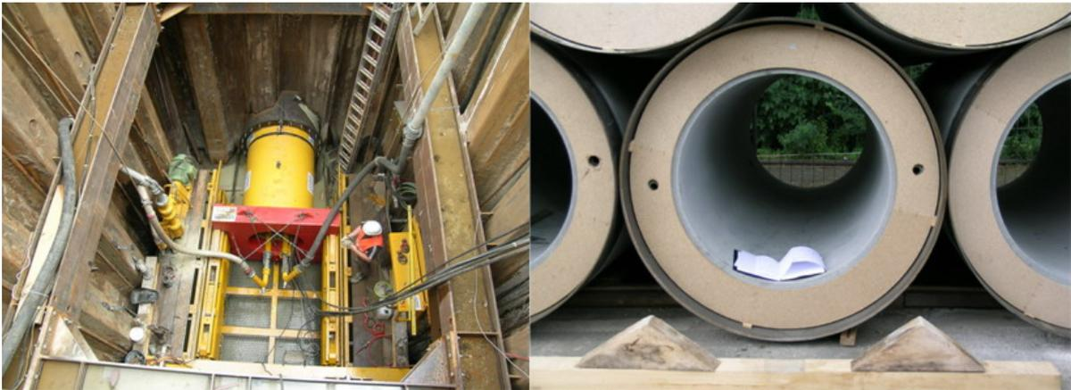
Bild 4.1: Pressgrube mit Spundwandverbau, Maschinenrohr AVN 1200, Herrenknecht AG (links), Stahlbetonvortriebsrohre mit Fugenzwischenlagen und Verrollungssicherungshülsen (rechts)
