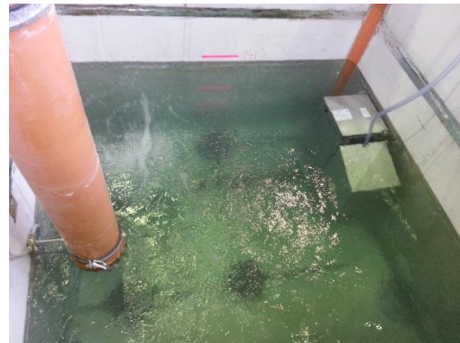
b) Drossel bei einem Wasserstand von 1,4 m
