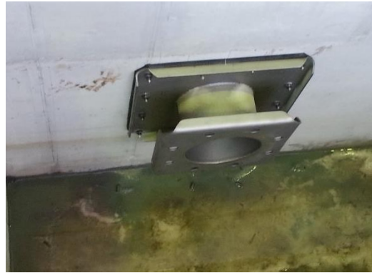
b) Nutzung des vorhandenen Flanschanschlusses
