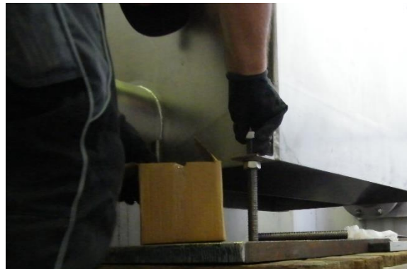
d) Ausrichten des Drosselorgans
