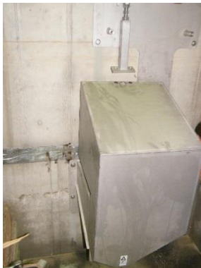
c) Einbringen der Haube mittels Kran
