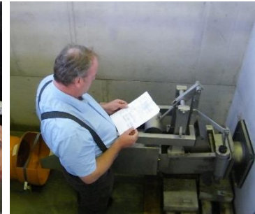
a) Lösen der Befestigungsschraube b) Verschieben des Gewichtes c) Kontrolle der Maße Bild 36 Wesentliche Arbeitsschritte für die Umstellung der Drosselwassermenge
