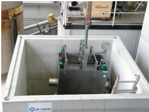
c) Einbringen des Drosselorgans mittels Kran
