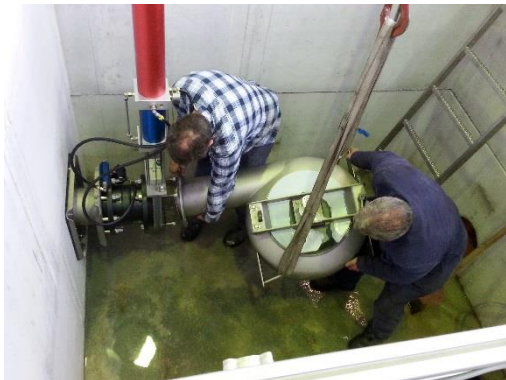
c) Einbringen des Drosselorgans mittels Kran
