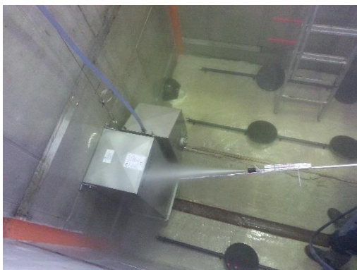
a) Hochdruck-Reinigung der Drossel
