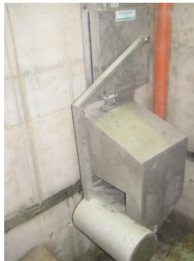
d) Anbringen des Schwimmers
