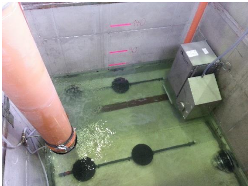
a) Drossel bei einem Wasserstand von 0,6 m
