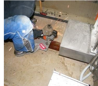
c) Kürzen der Schieberkanten
