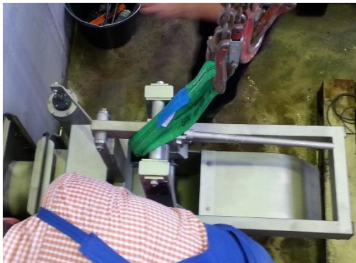
c) Einbringen des Drosselorgans mittels Kran
