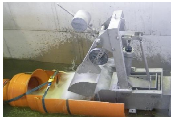
a) Strahl-Drossel im Trockenwetterzustand b) Strahl-Drossel in Betrieb
