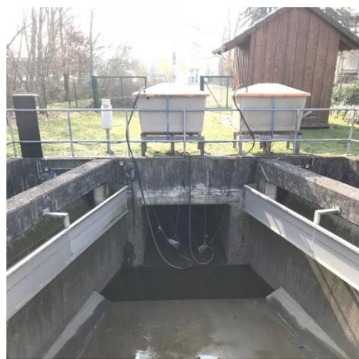
Bild 3.5: Zulaufgerinne mit Geröllschacht u. beidseitigen Federstaublechen
