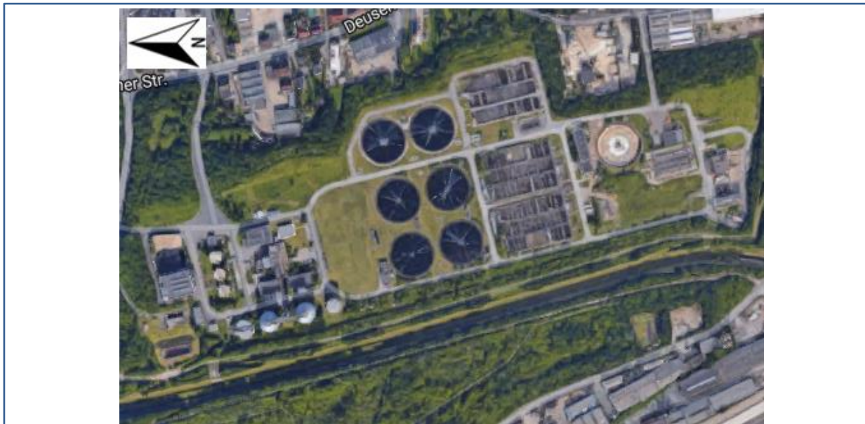
Abbildung 87: Luftbild der Kläranlage Dortmund Deusen (GeoBasis-DE/BKG 2009)
