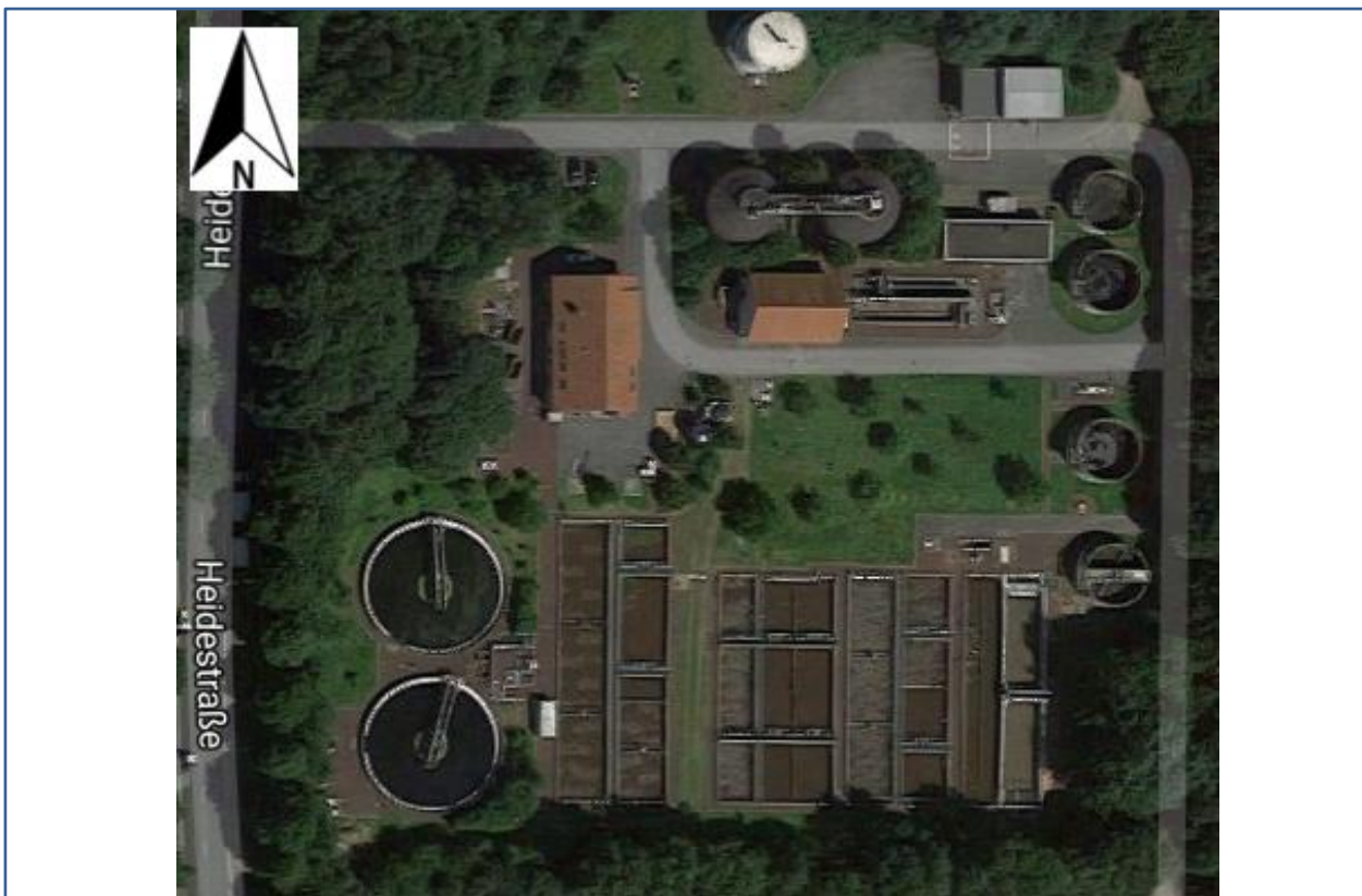
Abbildung 96: Luftbild der Kläranlage Herten Westerholt (GeoBasis-DE/BKG 2009)
