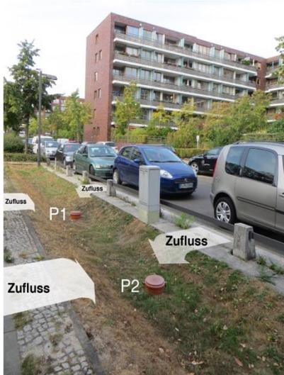
Abbildung 8: Fertigestellte Messstelle am Standort Berlin (M1). P1 und P2 bezeichnen die Messpunkte für die Sickerwasserextraktion.
