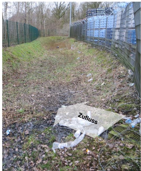
Abbildung 2: Versickerungsmulde (M2) im nördlichen Ruhrgebiet für den Hauptnutzungstyp Gewerbe. Die Mulde wird über einen punktuellen Zulauf beschickt (rechter Bildrand).
