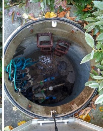
Abbildung 10: Messschacht zur Beprobung der Stoffkonzentration im Rigolenabfluss der gefassten Messmulde. Diese Messmulde schließt direkt an die Mulde mit Messstelle an (Ende der Mulde in Abbildung 8).
