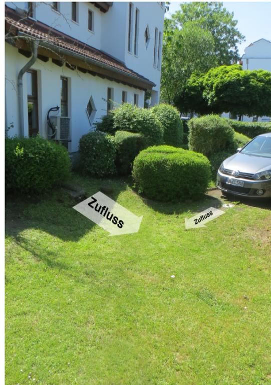
Abbildung 3: Ausgewähltes Mulden-Rigolen System im zentralen Ruhrgebiet für den Hauptnutzungstyp Dachabflüsse (M3). Die Mulde wird punktuell mit Dachabläufen (rechter Bildrand) und in geringem Umfang mit Abflüssen des Parkplatzes (linker Bildrand) beschickt.
