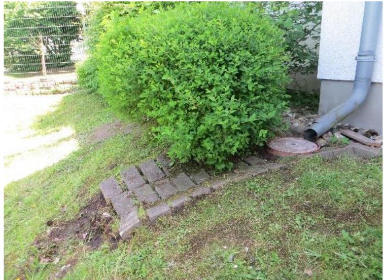
Abbildung 17: Einleitung der Dachabflüsse in die Mulde. In dem PVC-Rohr direkt unterhalb des gekrümmten Fallrohrs befindet sich ein Sammelgefäß für die Beprobung der stofflichen Belastung im Einlauf.
