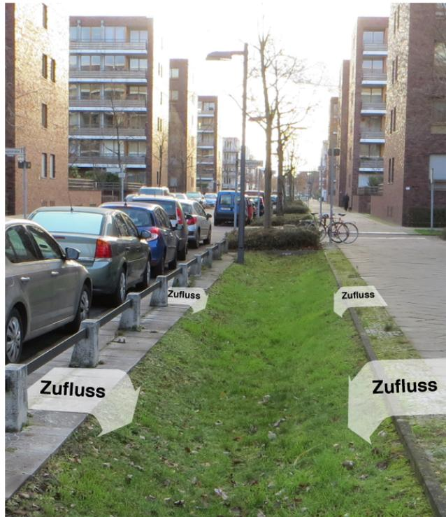
Abbildung 1: Ausgewähltes Mulden-Rigolen System im Raum Berlin für den Hauptnutzungstyp Straßenabflüsse im Wohnbereich (M1). Niederschlagsabfluss wird flächig von der angrenzenden Straße (rechte Bildseite) und dem Gehweg (linke Bildseite) eingeleitet.
