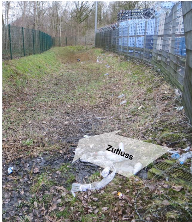
Abbildung 2: Versickerungsmulde (M2) im nördlichen Ruhrgebiet für den Hauptnutzungstyp Gewerbe. Die Mulde wird über einen punktuellen Zulauf beschickt (rechter Bildrand).
