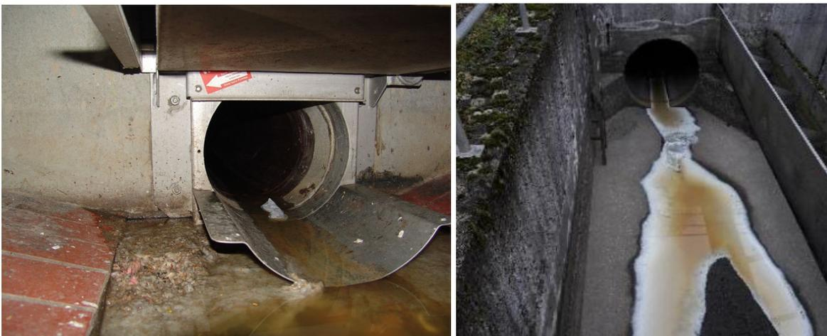
**Abb. 2:** Hinweise auf Fehleinleitungen, die bei Drosselprüfungen oder Bauwerksüberwachungen entdeckt werden können (links: Hygieneartikel und rechts: Verfärbungen/Schaum)
