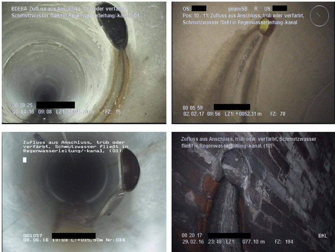
**Abb. 5: Verfärbung und Ablagerungen durch Schmutzwasser im Anschlussbereich von Regenwasserkanälen**
