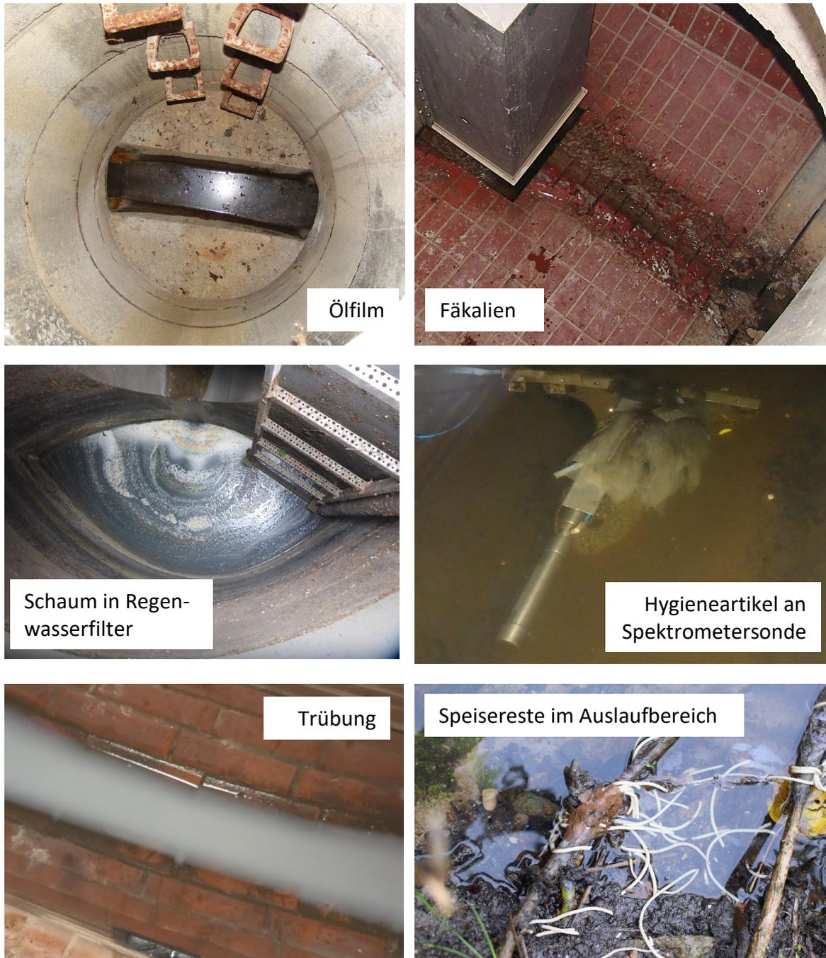
**Abb. 4:** Optisch erkennbare Folgen von Fehleinleitungen in der Regenwasserkanalisation und Fehleinleitungsindikatoren im Auslauf in ein Gewässer
