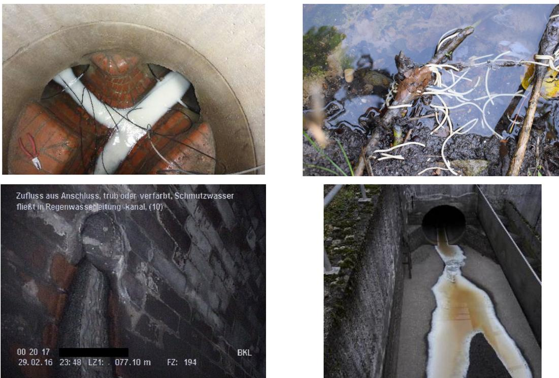
**Abb. 2: Optisch erkennbare Fehleinleitungen in der Regenwasserkanalisation in Behandlungs- oder Speicherbecken und an Einleitstellen**
