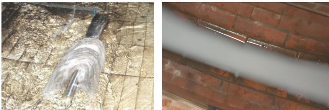
**Abb. 1: Sichtbare Fehleinleitungen in einem Regenwasserkanal**
