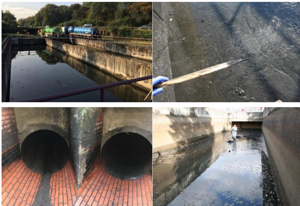
Abbildung 8.2: Beckenreinigung durch den Landesbetrieb Straßenbau NRW (Straßen.NRW)
