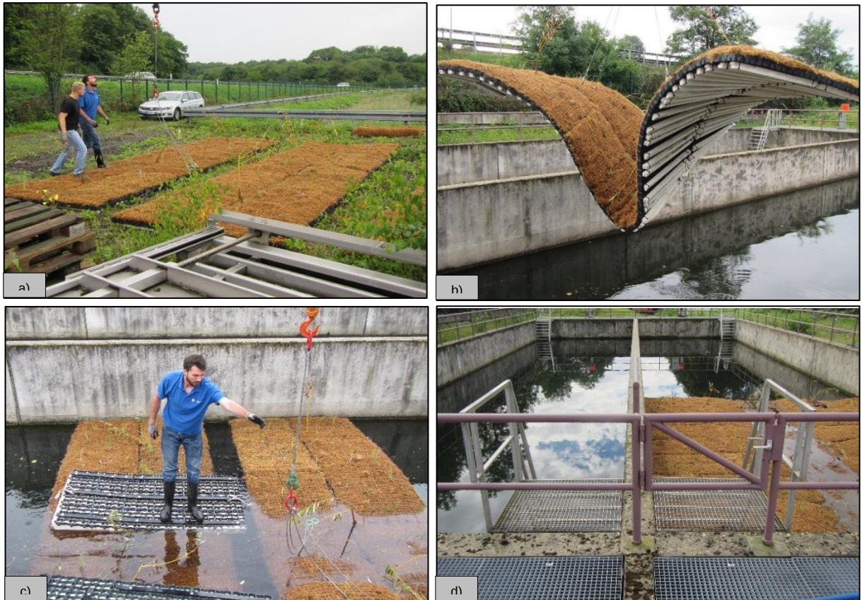
Abbildung 3.7: Einbau der FTWs in die Beckenanlage Köln-Ost. a) Trägerkonstruktion b) Einbau der Matten in die Becken c) Verbindung der Matten d) Beckenanlage nach fertiggestelltem Einbau
