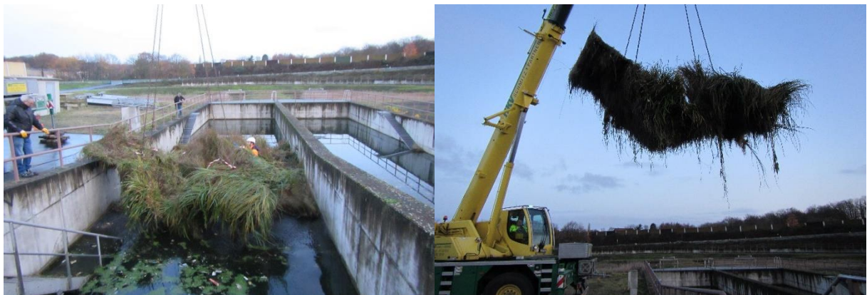
Abbildung 6.1: Rückbau der Flöße aus den RiStWag-Anlagen mittels Mobilkran
