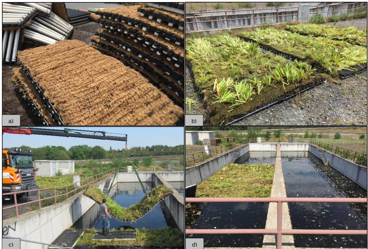
Abbildung 3.4: Einbau der FTWs in die Beckenanlage Köln-Mülheim. a) Trägerkonstruktion b) Trägerkonstruktion mit Pflanzenmatte c) Einbau der Matten in die Becken d) Beckenanlage nach fertiggestelltem Einbau
