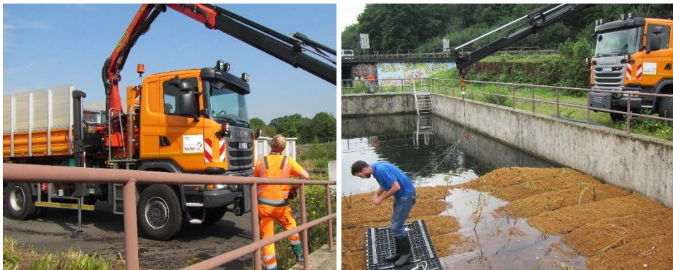
Abbildung 8.1: Einbau der FTWs mittels Mobilkran, zur Verfügung gestellt vom Landesbetrieb Straßenbau NRW (links: Köln-Mülheim; rechts: Köln-Ost)
