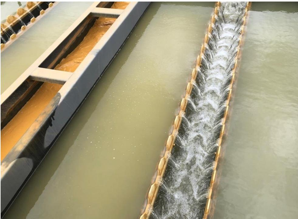
Abbildung A-15: Feldversuch in Blessem am 03.09.2019 um 12:39; Gute Klärung des KWW bei 100 t/h Rohstoffaufgabe und 350 m<sup>3</sup>/h Waschwasser
