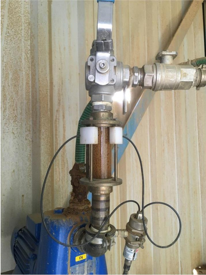
Abbildung A-9: Regelungstechnik zur Flockungsmitteldosierung auf der Kieswäsche Gymnich
