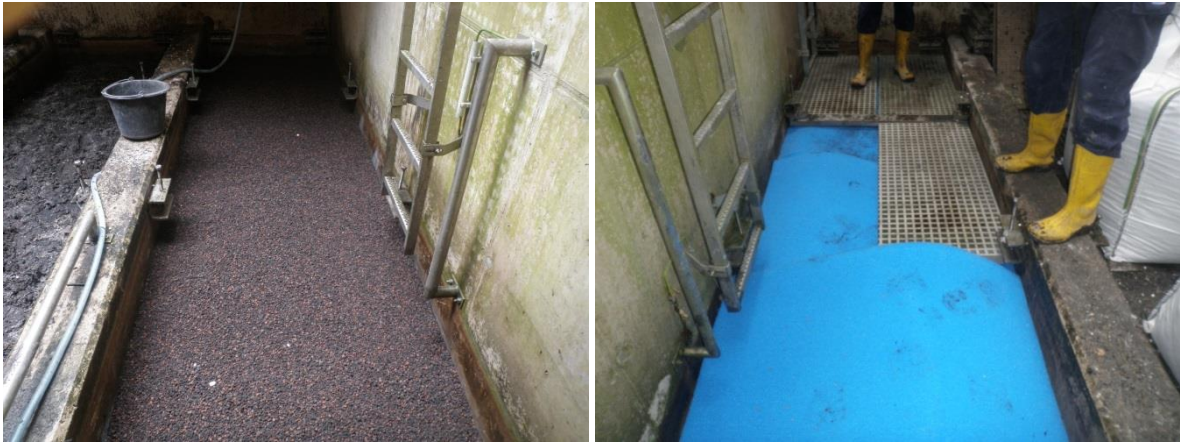
Bild 27: Einbau oberste Filterschicht und Filtermatte am 09.07.2015
