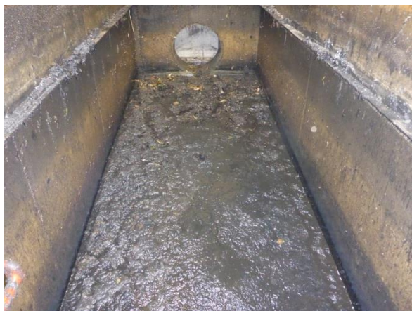
Bild 25: Schlammablagerungen im Sedimentationsraum der Filterstraßen
