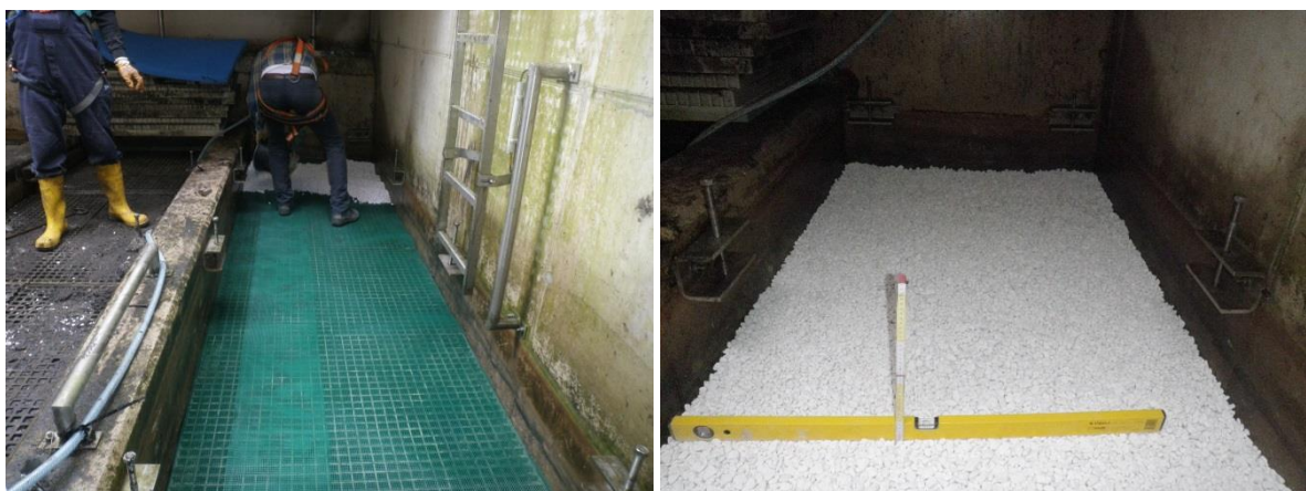
Bild 26: Einbau der untersten beiden Filterschichten am 09.07.2015 Versuchsphase II
