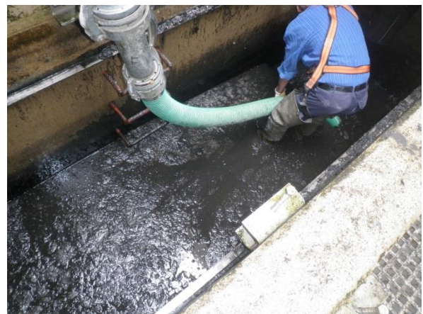
Bild 25: Schlammablagerungen im Sedimentationsraum der Filterstraßen
