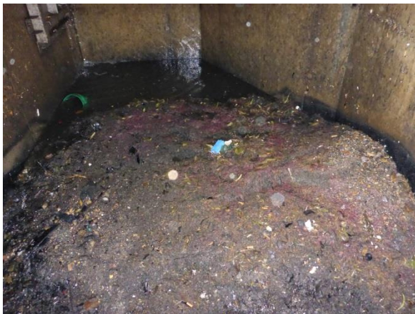
Bild 24: Schlammablagerungen im Sedimentationsraum im Zulaufbereich
