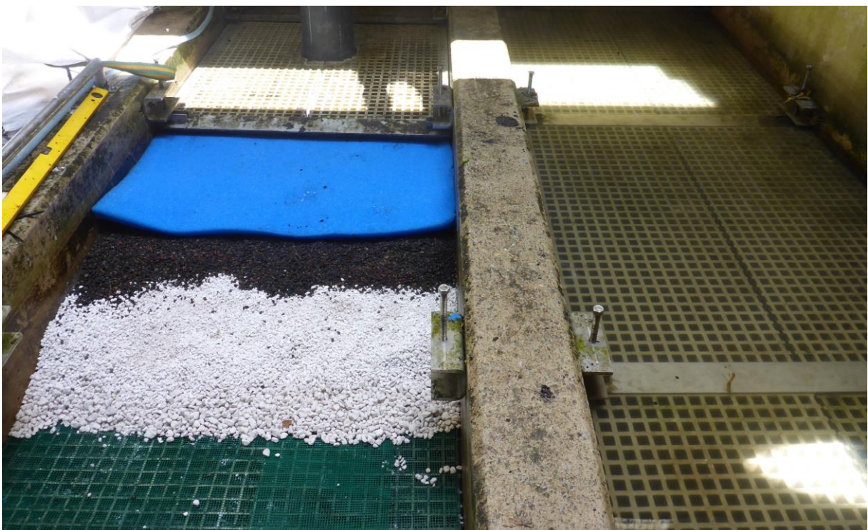
Bild 14: Exemplarischer Filteraufbau der mittleren Filterstraße
