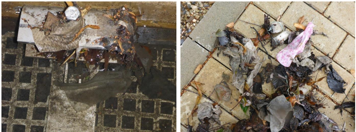
Bild 19: Hygieneartikel in der Filterstraße (linkes Foto vom 31.07.2014) und entfernte Ablagerungen (rechtes Foto vom 14.08.2014)
