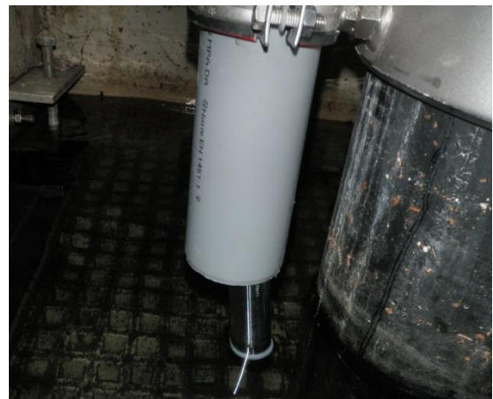
Bild 7: Füllstandsmessung im Ablaufbereich der Filteranlage „In der Fleute“
