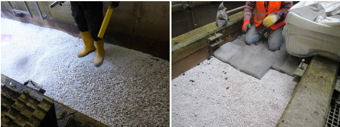
Bild 16: Einbau Filtermaterial mittlere (links) und obere Lage (rechts) am 15.05.2014
