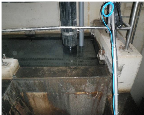
Bild 7: Füllstandsmessung im Ablaufbereich der Filteranlage „In der Fleute“
