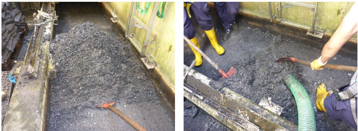
Bild 22: Ausbau des stark verunreinigten Filtermaterials am 07.07.2015
