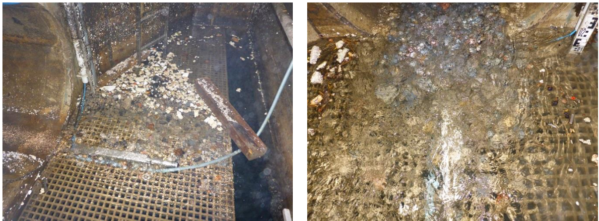
Bild 29: Zulaufsituation 16.11.2015 (linkes Foto) und 04.12.2015 (rechtes Foto)
