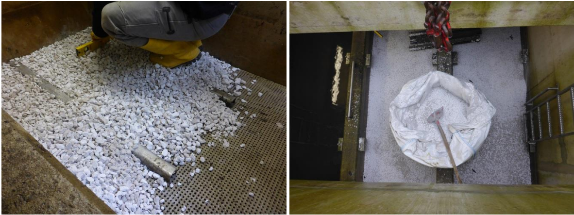
Bild 15: Einbau Filtermaterial unterste Lage am 15.05.2014
