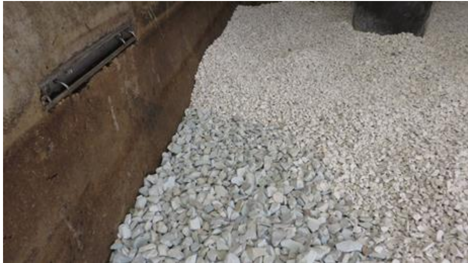
Bild 39: Schichtaufbau mit Zeolith 1 (8-16 mm) und Zeolith 2 (8-10 mm)
