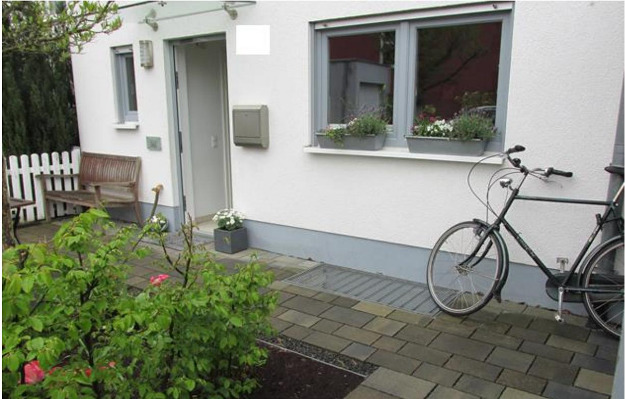
Abb. 5-3: Hauseingang mit ebenerdigem Lichtschacht
