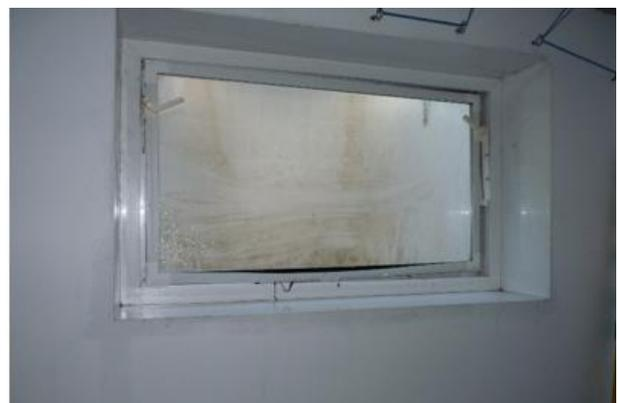
Abb. 4-2: Ungeschützter Lichtschacht und aufgedrücktes Kellerfenster
