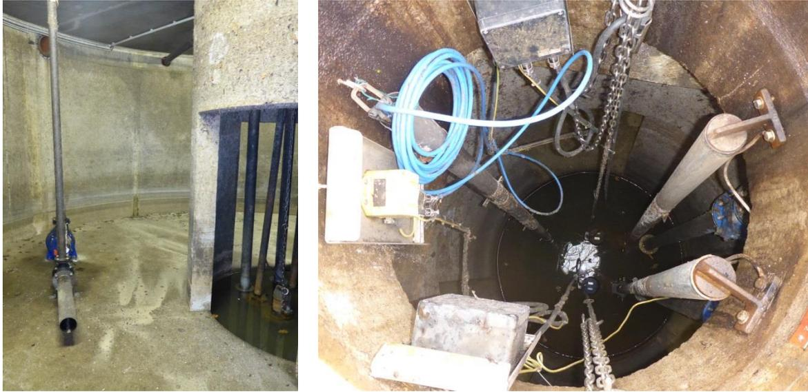
Abbildung 19: Beckenkammer mit Wirbeljet und mittigem Pumpensumpf (links), Pumpensumpf in der Ansicht von oben mit Drucksonde (rechts)
