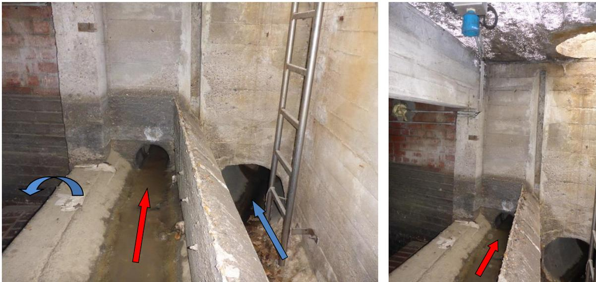
Abbildung 18: Trennbauwerk mit Abschlag in Richtung Beckenkammer (links) sowie Beckenüberlauf (rechte Schelle mit abgehendem Kanal) sowie der Messeinrichtung über der Trockenwetterrinne (rechte Abbildung)
