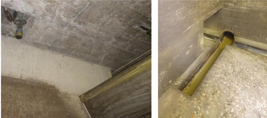
Abbildung 17: Ultraschallsonde im Schwellenbereich des RÜBs „Volumen“ (links), Trockenwetterrinne in Kammer 2 und Wanddurchlass (rechts)
