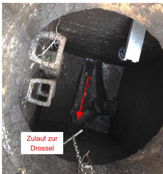
Abbildung 39: Darstellung der Rohrdrossel und der Wasserstandsmessung
