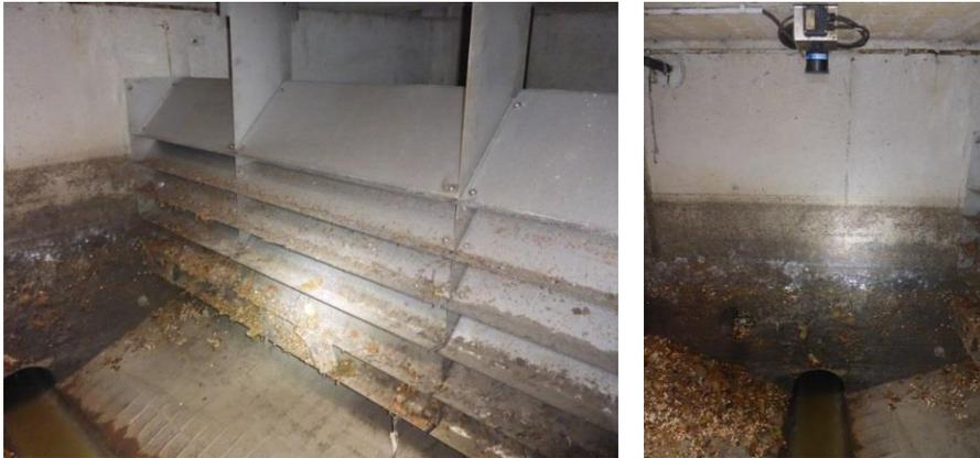
Abbildung 34: Zulauf ins Trennbauwerk mit Blick auf die Schwelle mit Lamellentauchwand (links), Ablauf zur MID-Strecke aus dem Trennbauwerk mit Ultraschallsonde des RÜB „Nebenschluss“ (rechts)
