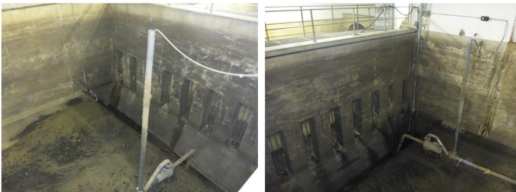
Abbildung 26: Zulaufbereich Kammer 1 (links) und 2 (rechts) mit Pumpensumpf des RÜB „Zwei Kammern“
