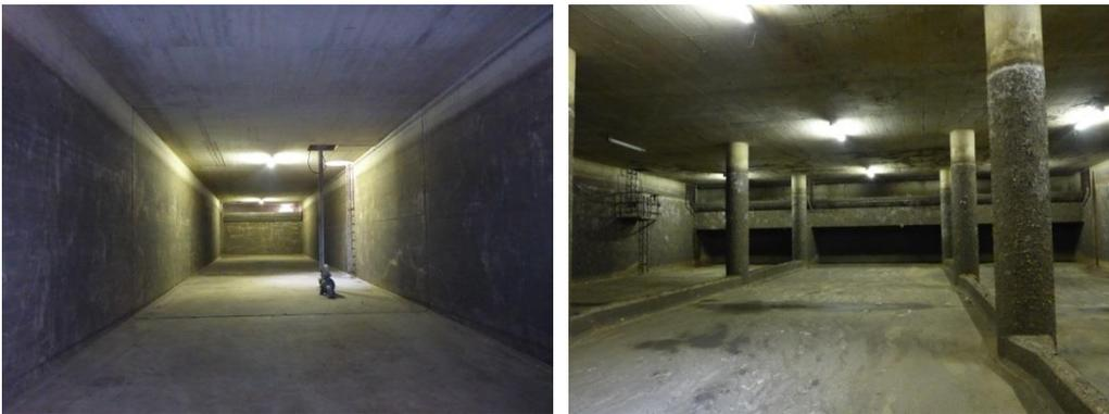
Abbildung 1: Beckenkammer zweier Regenüberlaufbecken mit Blick auf die Schwelle des Klärüberlaufs (Bildmaterial Dr. Pecher AG)
